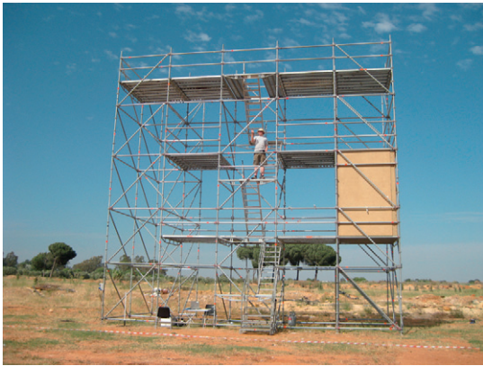
Figura 8: Escenario de validación del proyecto AWARE en las instalaciones de Protec-Fire (Grupo Iturri) en Utrera, Sevilla. La fotografía muestra la estructura usada para simular un edificio.
