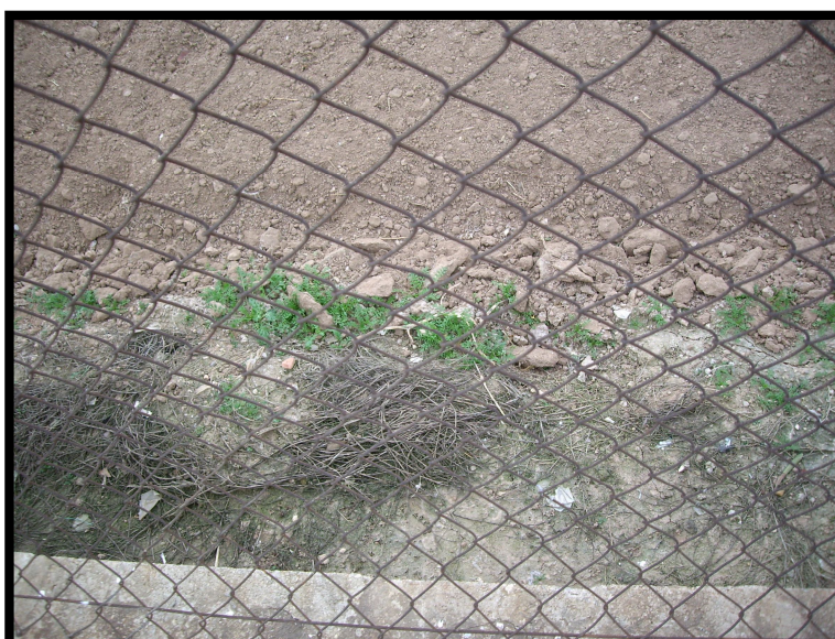
Fig. 22 : Vallado metálico en el vallado perimetral
