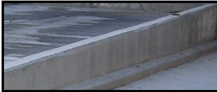
Fig : Pendiente en la zona de lavado de vehículos. Fuente: Propia.
