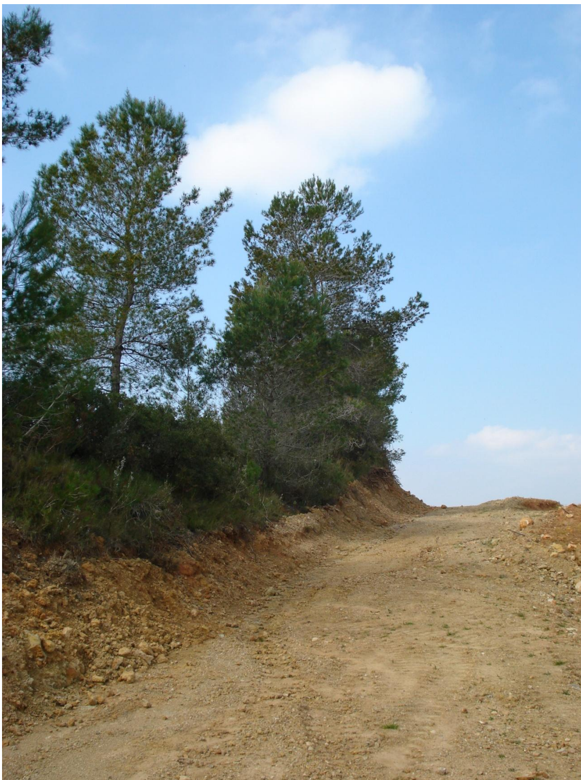
Figura 20: Apertura de caminos en una zona montañosa
