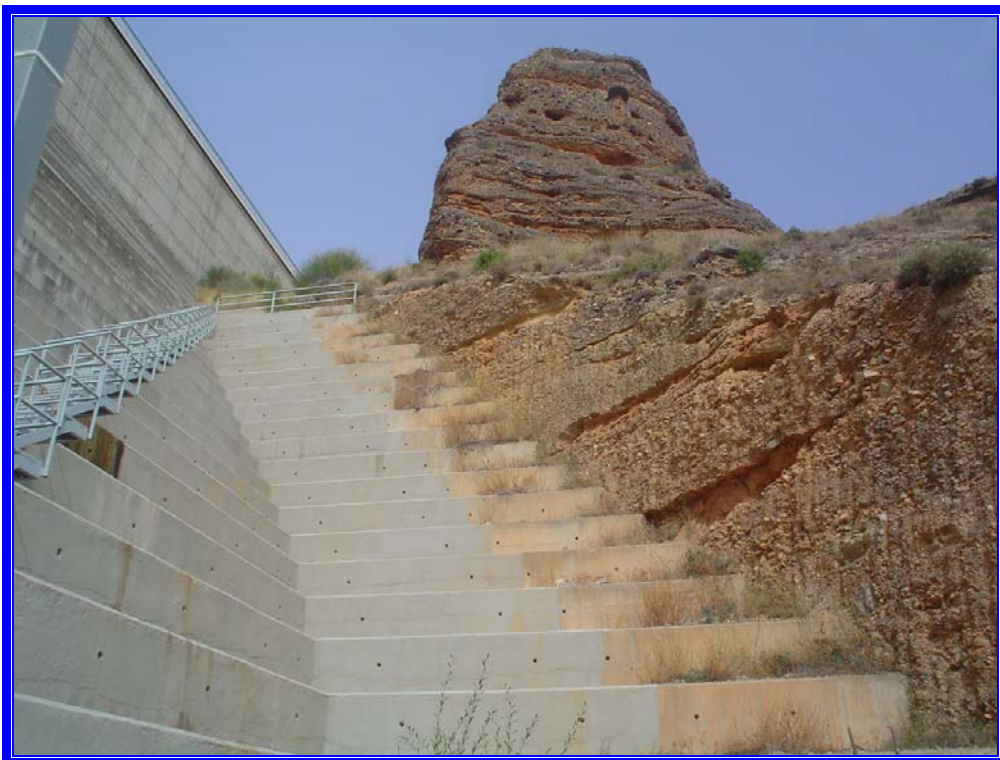
Fotografía 2 : Vista del estribo izquierdo de la presa.
