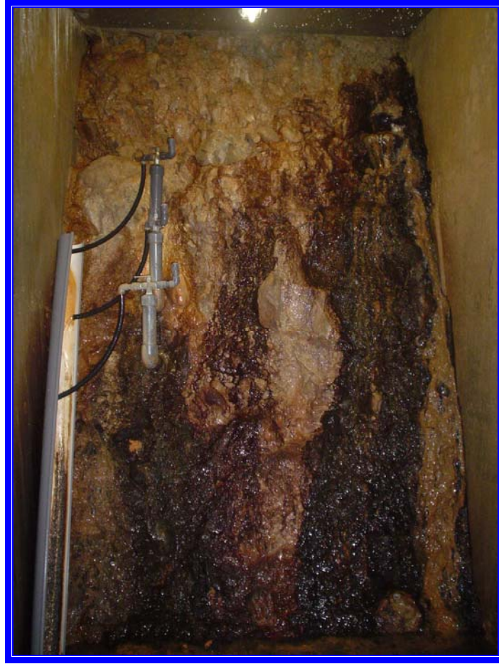
Fotografía 7 : Vista Frontal de la roca del estribo derecho.
