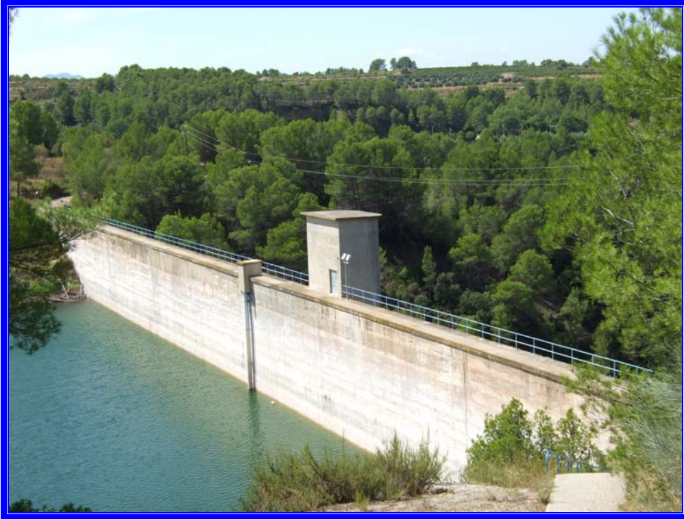
Fotografía 3 : Vista lateral de la presa desde aguas arriba
