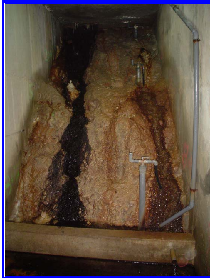
Fotografía 6: Vista Frontal de la roca del estribo izquierdo
