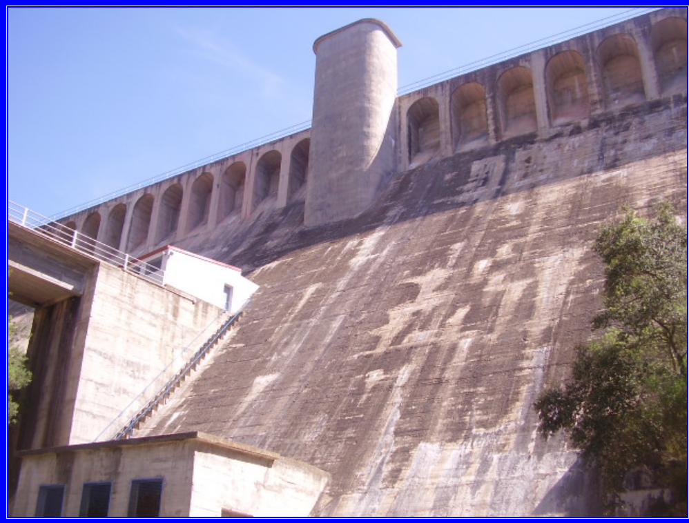
Fotografía 5 : Vista de la presa desde aguas abajo
