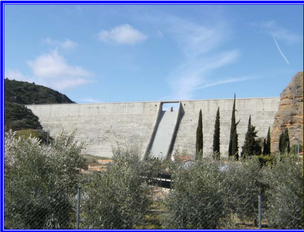
Fotografía 1 : Vista frontal de la presa de Val.
