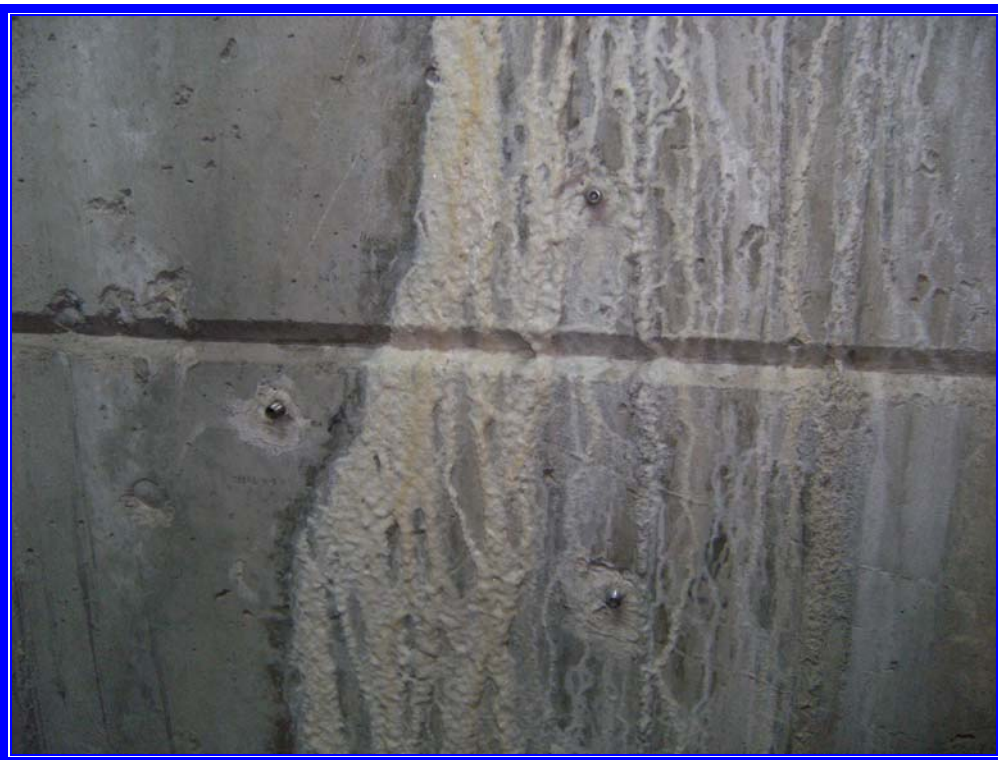
Fotografía 20: Bases de ternas para medir aperturas o cierres de juntas
