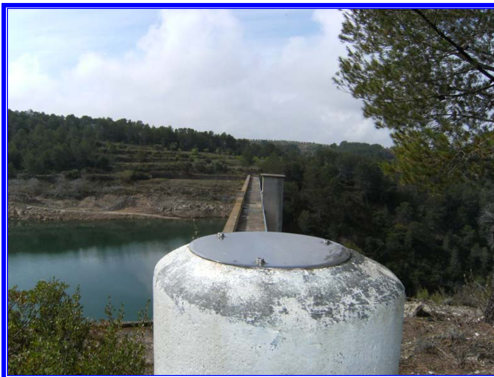
Fotografía 21 : Pilares topográficos
