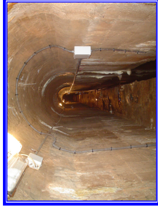
Filtraciones en el paramento aguas abajo
