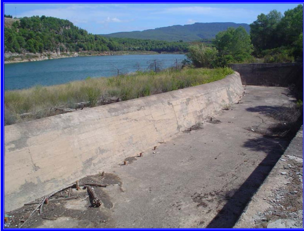
Fotografía 7: Vista frontal del aliviadero lateral de la presa
