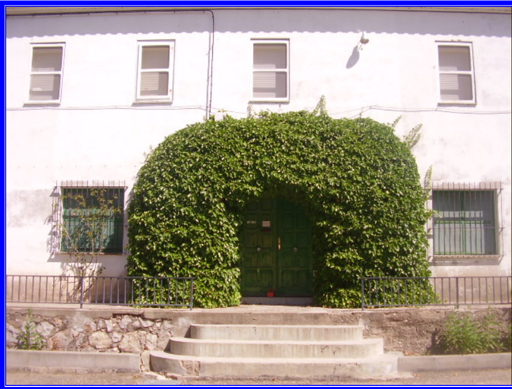
Fotografía 1: Vista frontal de la casa de administración de la presa de Guiamets.
