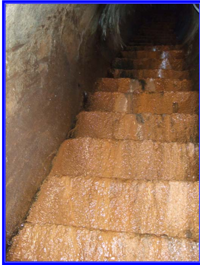
Fotografía 13 : Escalera ciega entre galería inferior y superior.
