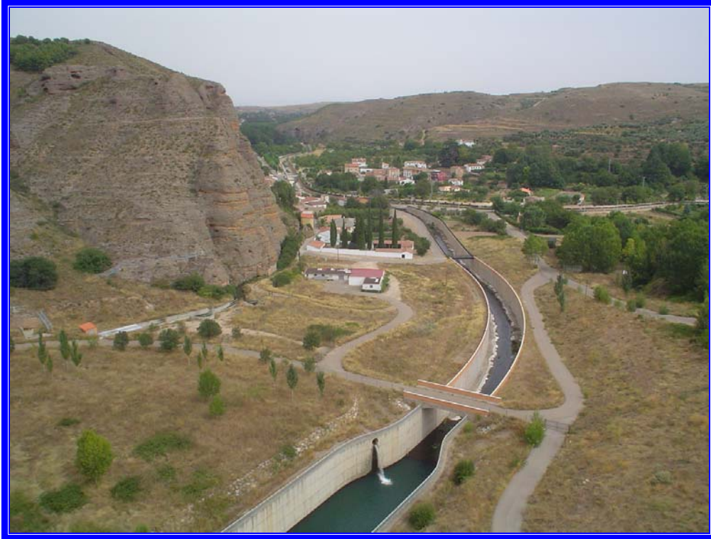
Fotografía 5: Vista general hacia aguas abajo de la presa
