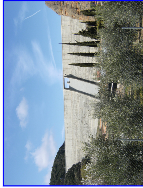
VISTA FRONTAL DE LA PRESA DE EL VAL
