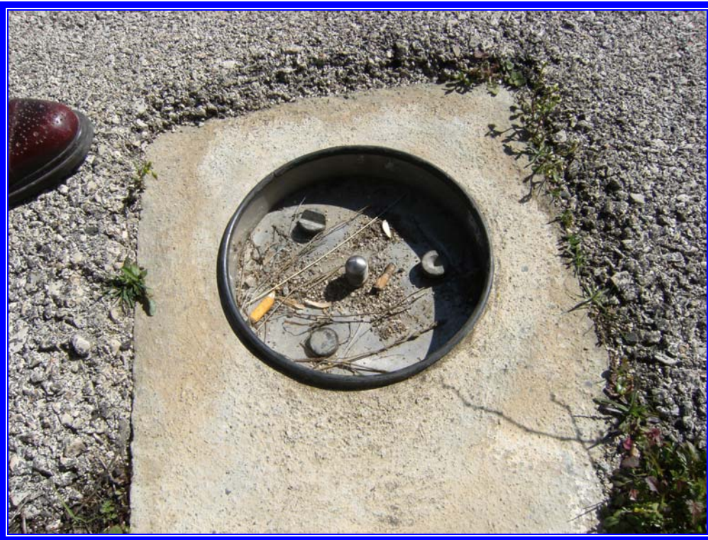
Fotografía 19: Pilar de Topografía en coronación
