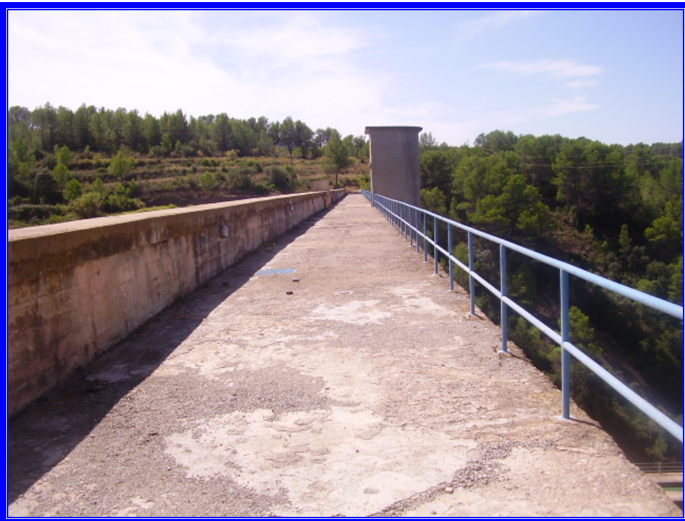
Fotografía 4 : Vista de la coronación de la presa
