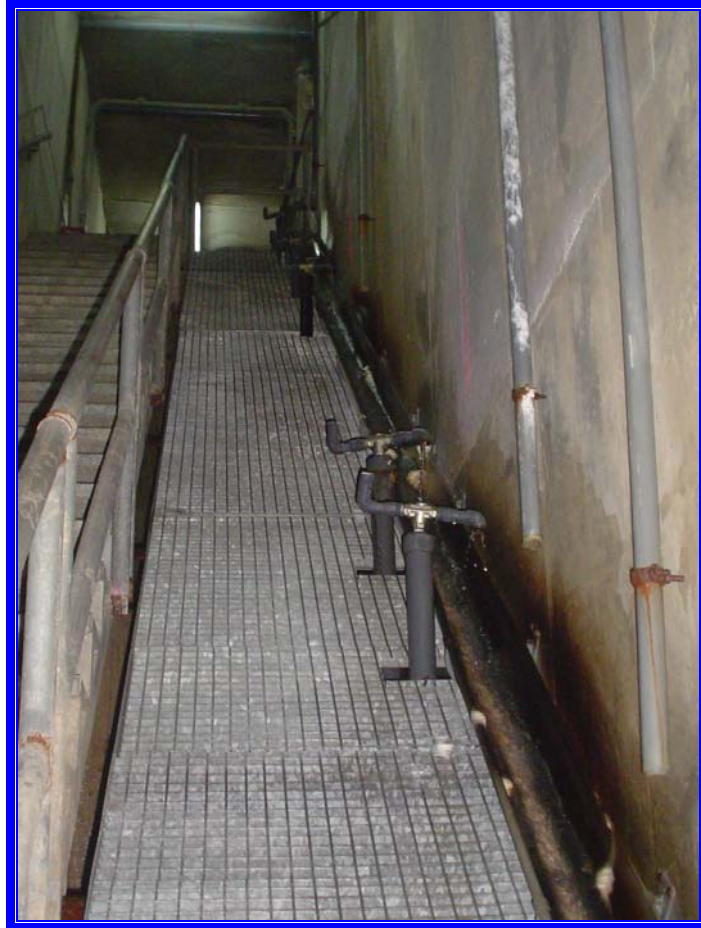
Fotografía 17: Drenes y canaletas colectoras de filtraciones
