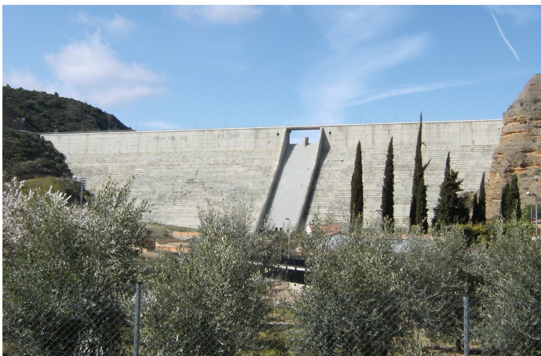
Figura. Vista Frontal de la Presa de El Val
