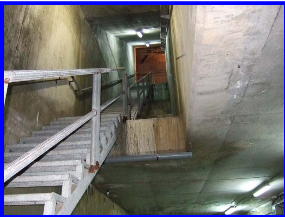
Fotografía 12 : Escalera de acceso entre galería inferior e intermedia
