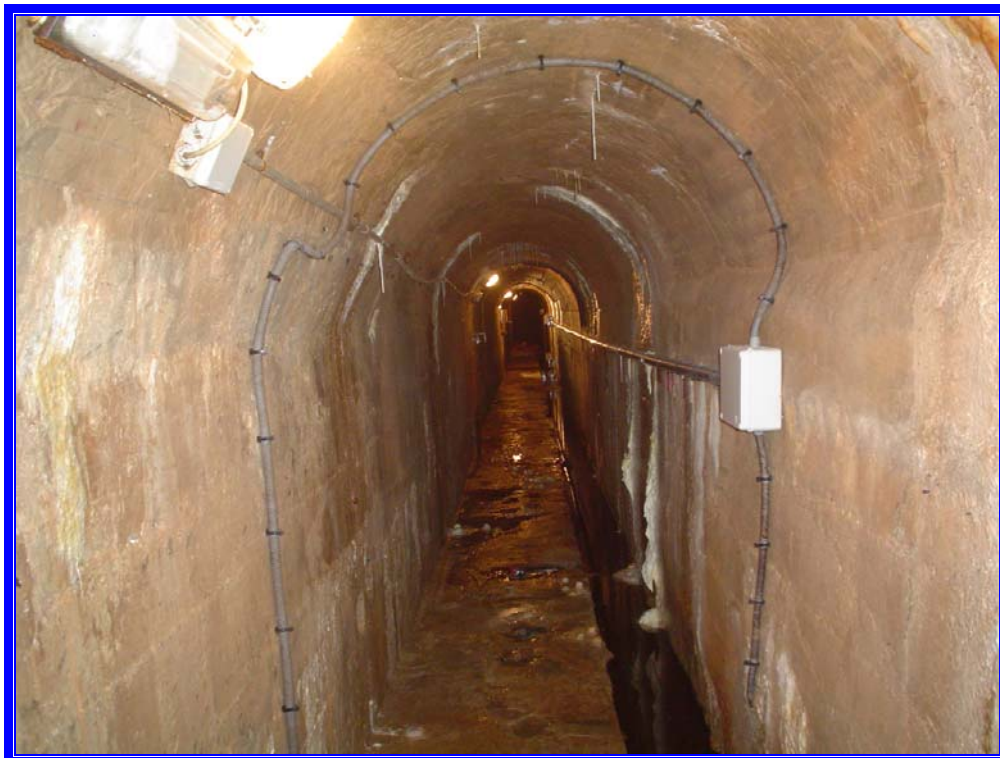
Fotografía 12 : Galería inferior de la presa
