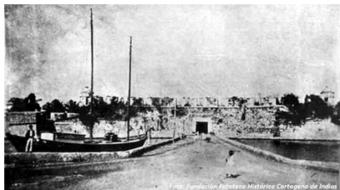
Fig. 10. Vista del puente de la Media Luna luego de la demolición del reducto, circa 1892. Fotografía de la fundación Fototeca Histórica Cartagena de Indias.
