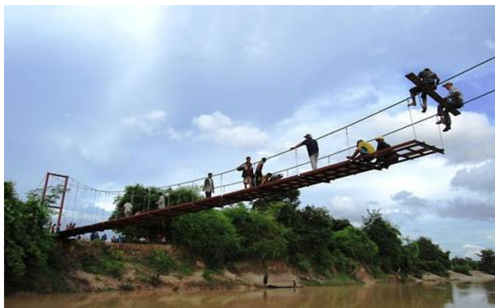
Figura 12. Pasarela colgante en proceso de construcción. www.ticino7.ch/ .
