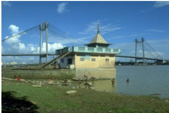
Figura 6. Puente sobre el río Hooghly. Puente atirantado de tablero mixto. Kolkata, India.
