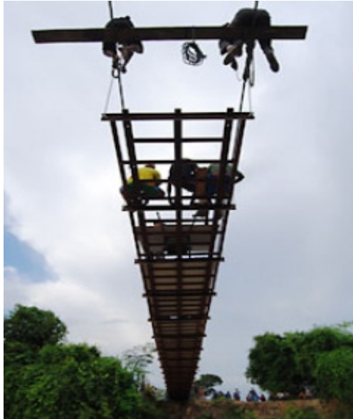
Figura 40. Hombres trabajando en la colocación de la plataforma de la pasarela (Izquierda). Puente colgante típico (Derecha). Pasarela construida por Toni Ruttimann. Ecuador. (Izq - Der).
