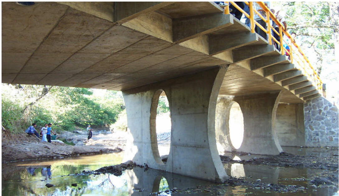
Figura 41. Puente sobre el rio Anchica. El Salvador. Puente losa de hormigón armado. Ing. Guillermo Candela.
