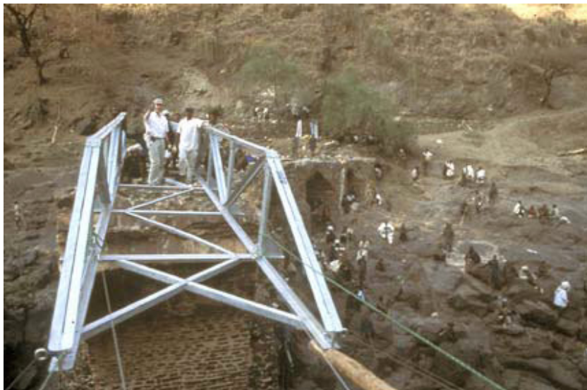
Figura 45. Puente de vigas de celosía metálica con tablero inferior. Río Nilo Azul, Ethiopia. Construido por bridge to Prosperity.
