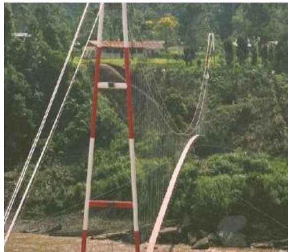
Figura 13. Pasarela colgante construida en la frontera entre Honduras y El Salvador por Toni Ruttimann.
