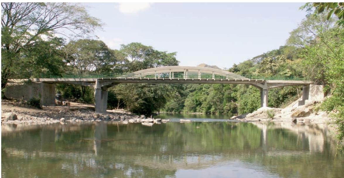
Figura 17. Puente sobre el río Torola; Departamento de Morazán, El Salvador. Puente de arco de hormigón postensado tipo (bow-string). Guillermo Candela García. Revista de Obras Públicas 3.487 (16): 31-46. 2008.
