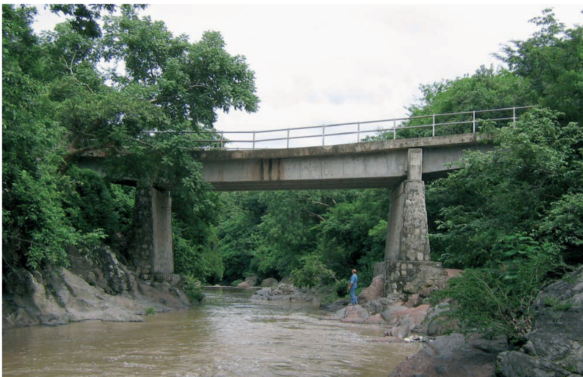
Figura 16. Puente sobre le rio chiquito; Departamento de Morazán, El Salvador. Puente de vigas de canto variable. Guillermo Candela García. Revista de Obras Públicas 3.411 (11): 47-57. 2001.
