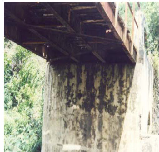
Figura 43. Puente de vigas metálicas de 14 mts de long. Y 4 mts de ancho. Compuesta por 4 vigas de sección I. Vista superior de la plataforma (Izq). Vista inferior del puente mostrando las 4 vigas I (Der). Indonesia.
