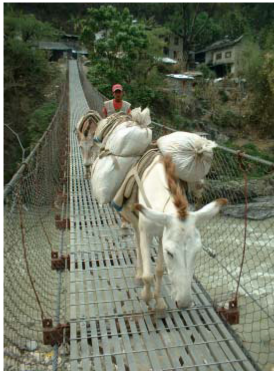
Figura 39. Puente colgante suspendido típico en Nepal. (SSTB). www.nepaltrailbridges.org/
