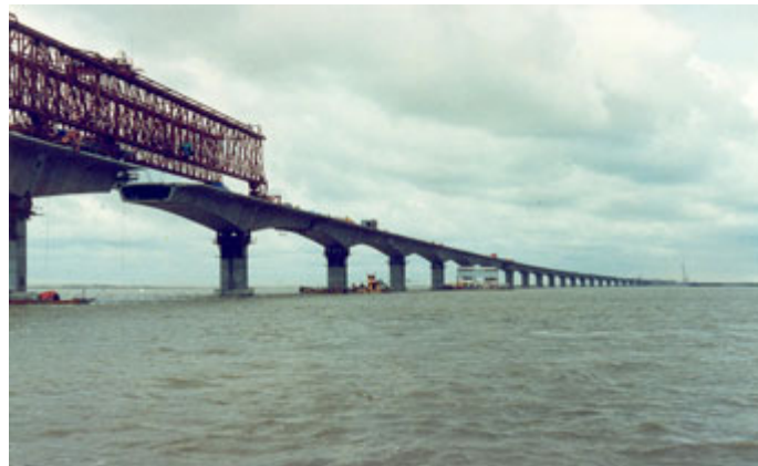
Figura 7. Puente sobre de Rio Jamuna. Bangladesh.
