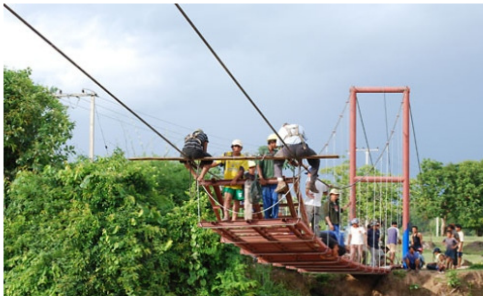
Figura 11. Toni trabajando con los beneficiarios en la construcción de una pasarela colgante. www.ticino7.ch/ .
