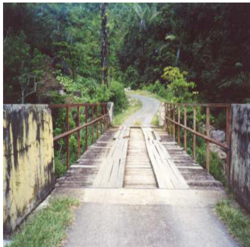
Figura 43. Puente de vigas metálicas de 14 mts de long. Y 4 mts de ancho. Compuesta por 4 vigas de sección I. Vista superior de la plataforma (Izq). Vista inferior del puente mostrando las 4 vigas I (Der). Indonesia.
