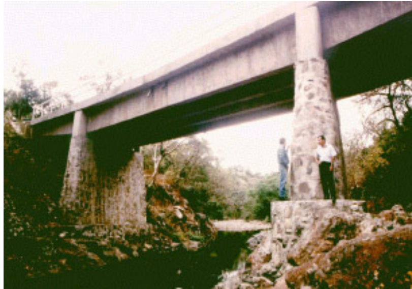
Figura 42. Puente sobre el rio chiquito; Departamento de Morazán, El Salvador. Puente de vigas de canto variable. Ing. Guillermo Candela.
