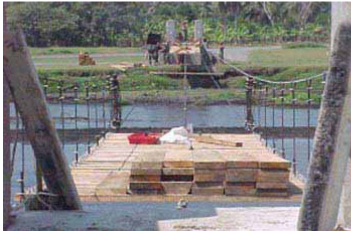
Figura 38. Puente tipo reconstruido después del huracán Mitch en Centroamérica. Ingrid Raventós (2000).
