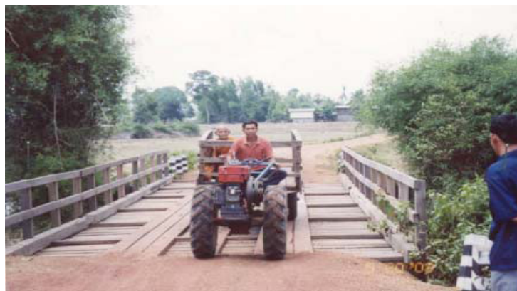
Figura 36. Puente de vigas de madera de 10 mts X 4.5 mts de ancho de uso peatonal y con flujo bajo de vehículos motorizados. Laos.
