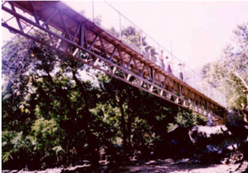
Figura 44. Pasarela peatonal de 30 metros de luz sobre el río Teosinte, Departamento de La Libertad (El Salvador), construida para una constructora local.
