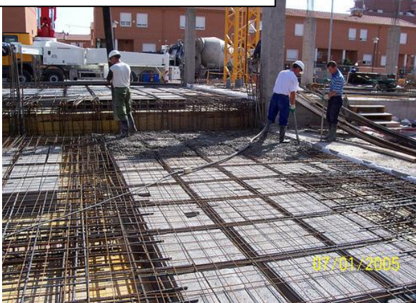
FIG 15 Forjado reticular o bidireccional
