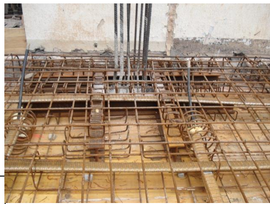
FIG 125 armadura para refuerzo anclaje pasivo
