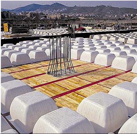
FIG 16 Forjado reticular. Solución recuperable.
