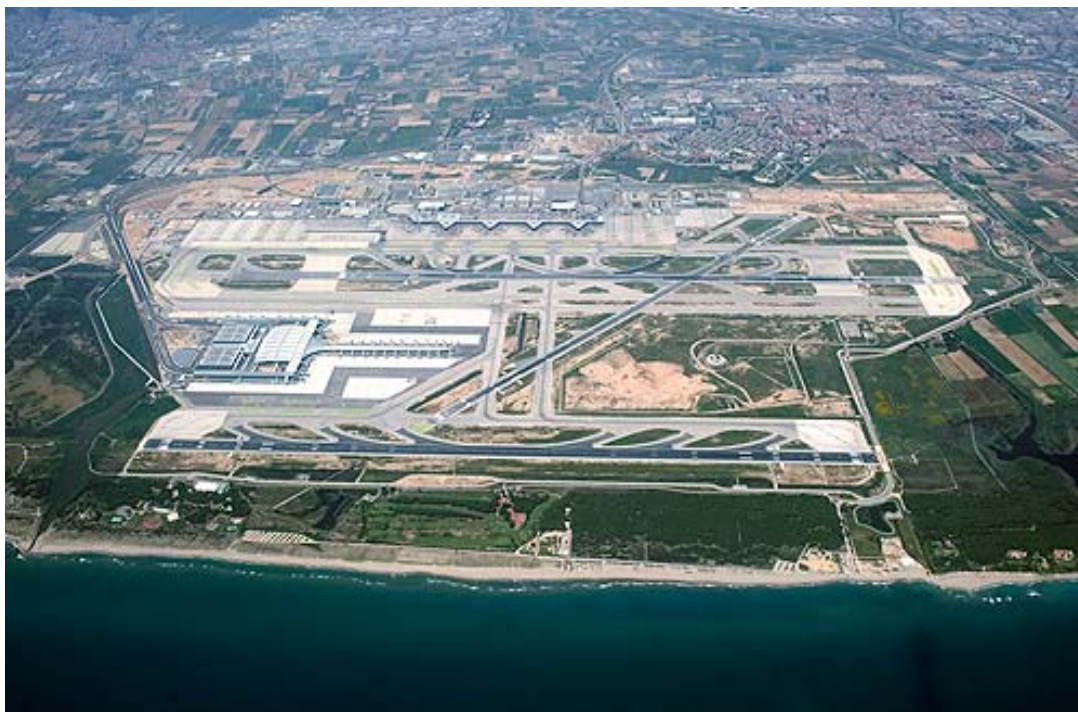
Ilustración 36. Fotografía aérea del aeropuerto de Barcelona. Fuente: Internet.
