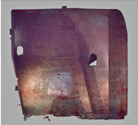
Fig. 4. Torre Matta. Rilievo laser scanner 3D del vano interno al bastione che ingloba parte della rondella quattrocentesca (Mitello & Muscatello, 2014).
