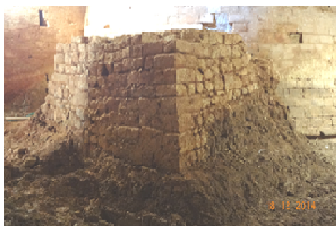
Fig. 10. Struttura muraria addossata alla rondella.
