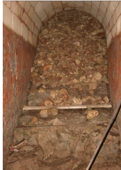
Fig. 6. Ingresso originario alla torre alla quota dei fossati prima della rimozione del materiale di accumulo.
