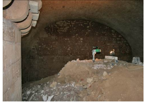
Fig. 5. L'interno del bastione prima dello svuotamento.
