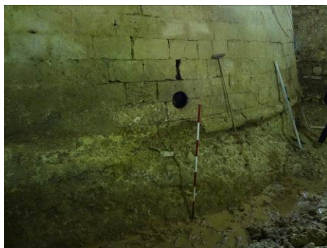
Fig. 11. Rondella quattrocentesca. In evidenza il basamento con il toro marcapiano che si innestano nel banco roccioso di fondazione.
