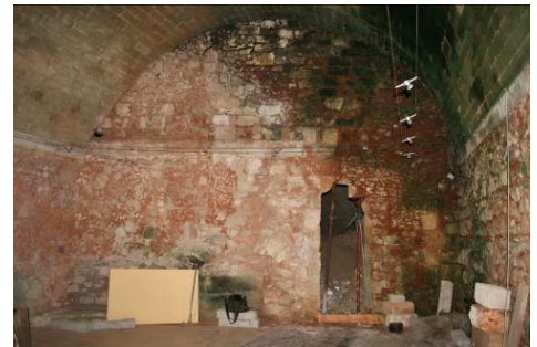
Fig. 7. Sala al piano superiore. Il varco nel muro, sulla destra, era l'unico accesso alla Torre Matta prima dello svuotamento.
