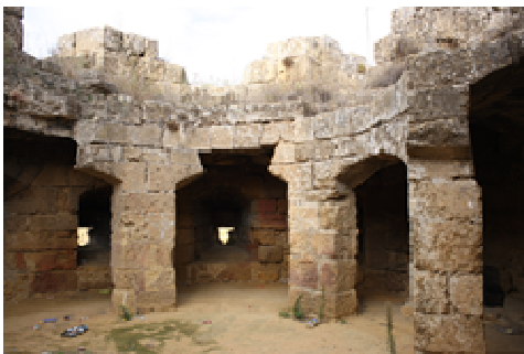
Fig. 5. Vista del interior del Cubete.
