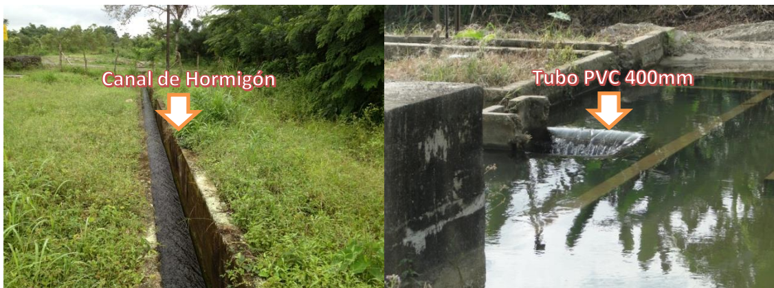
Figura 5 Conducción de Hormigón y PVC
