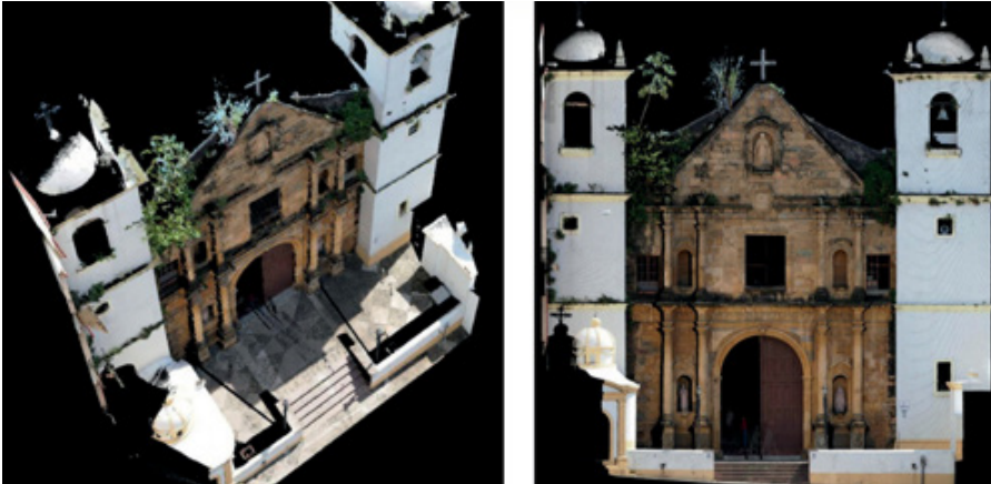
Figura 4. Nube de puntos “coloreada” y ortoimagen de la fachada de la iglesia de la Merced de Panamá (Fuente: Rubio et al. , 2018)
