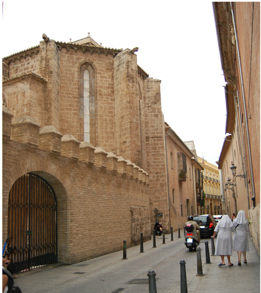
Figura 76. Conjunto de San Juan del Hospital de València, 2015 (Fuente: propia)
