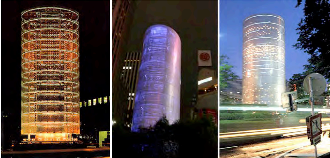
Fig. 28 .Toyo Ito – Tower of Winds(1985). Yokohama, Japón
