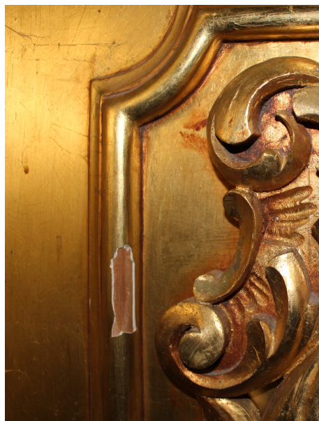
Fig. 21 Suciedad acumulada y faltante
