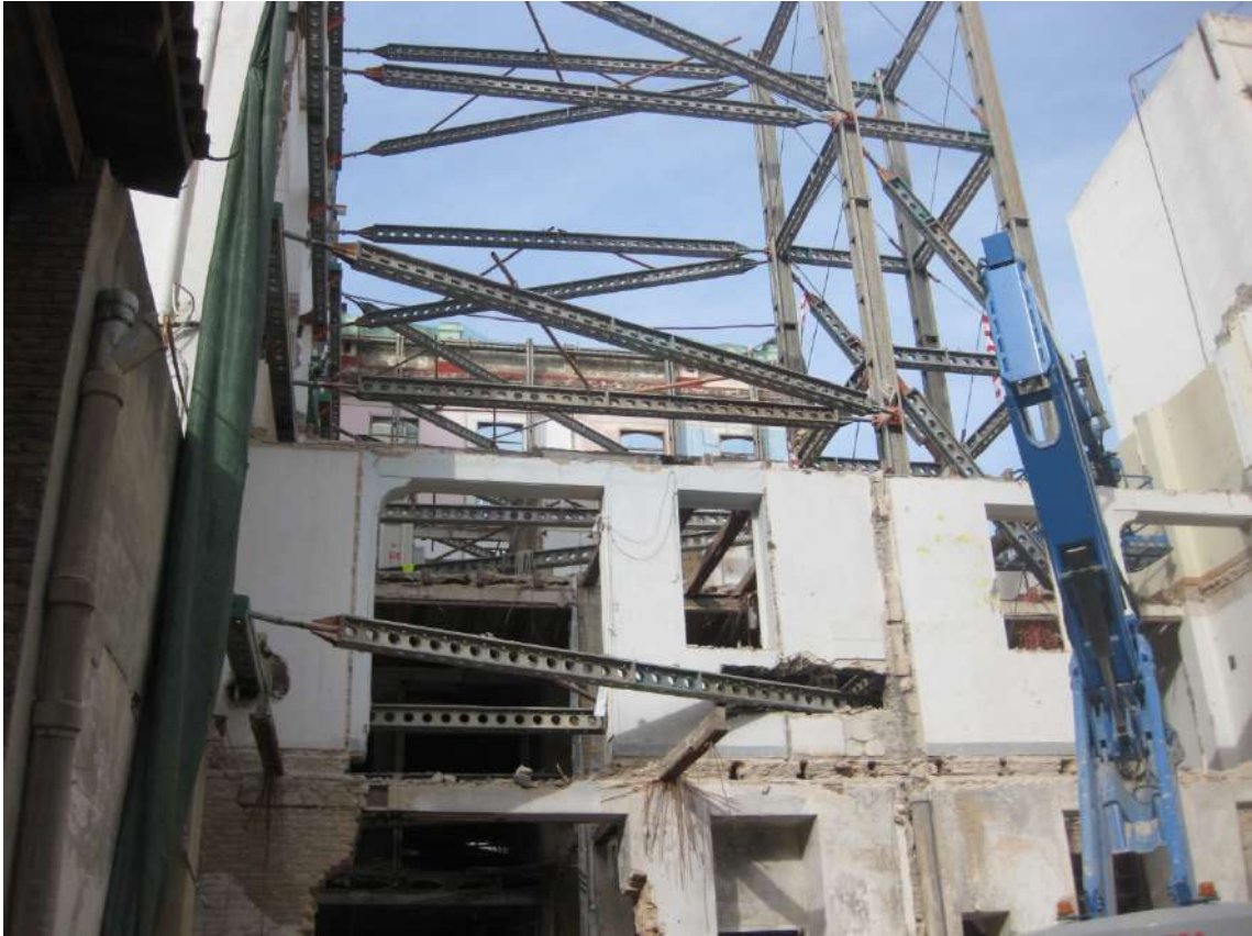
Ilustración 33. Demolición de fachada trasera hasta cota de forjado de planta segunda.
