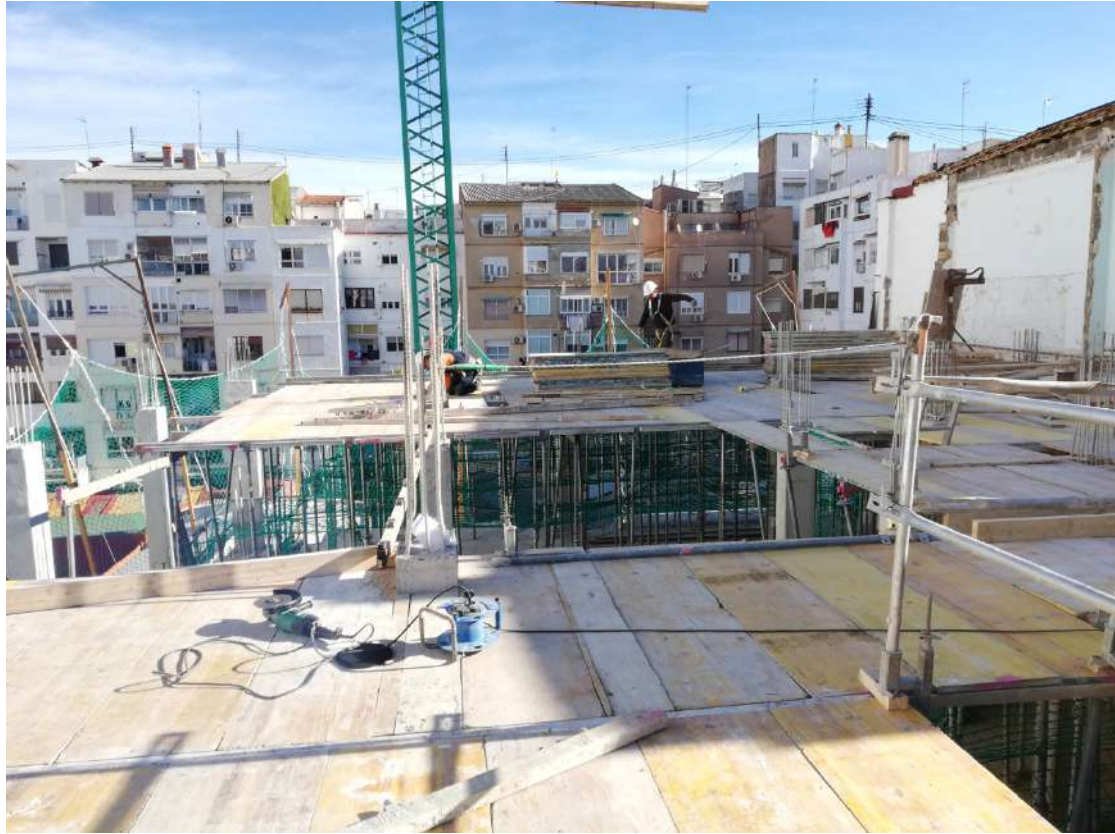
Ilustración 170. Montaje de encofrado de forjado de planta quinta.
