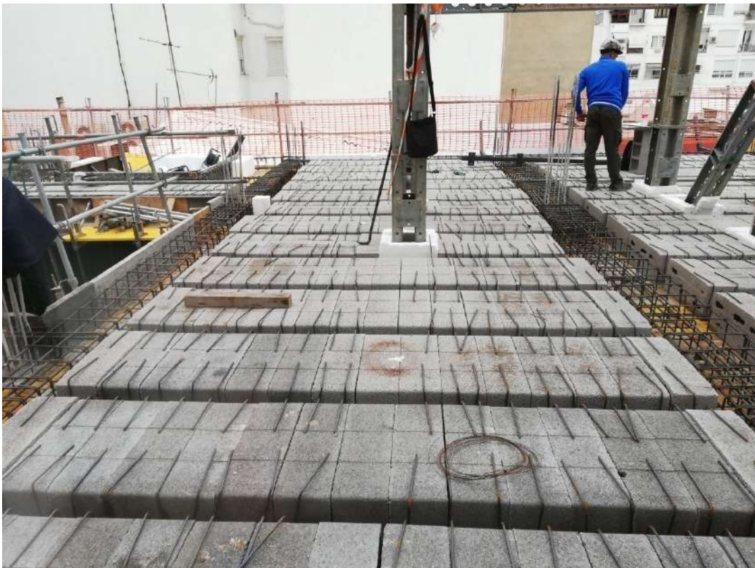
Ilustración 156. Armado de forjado de planta tercera.
