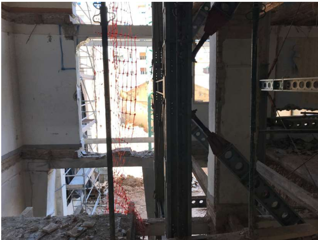
Ilustración 8. Huecos sin proteger acorde a normativa vigente.
