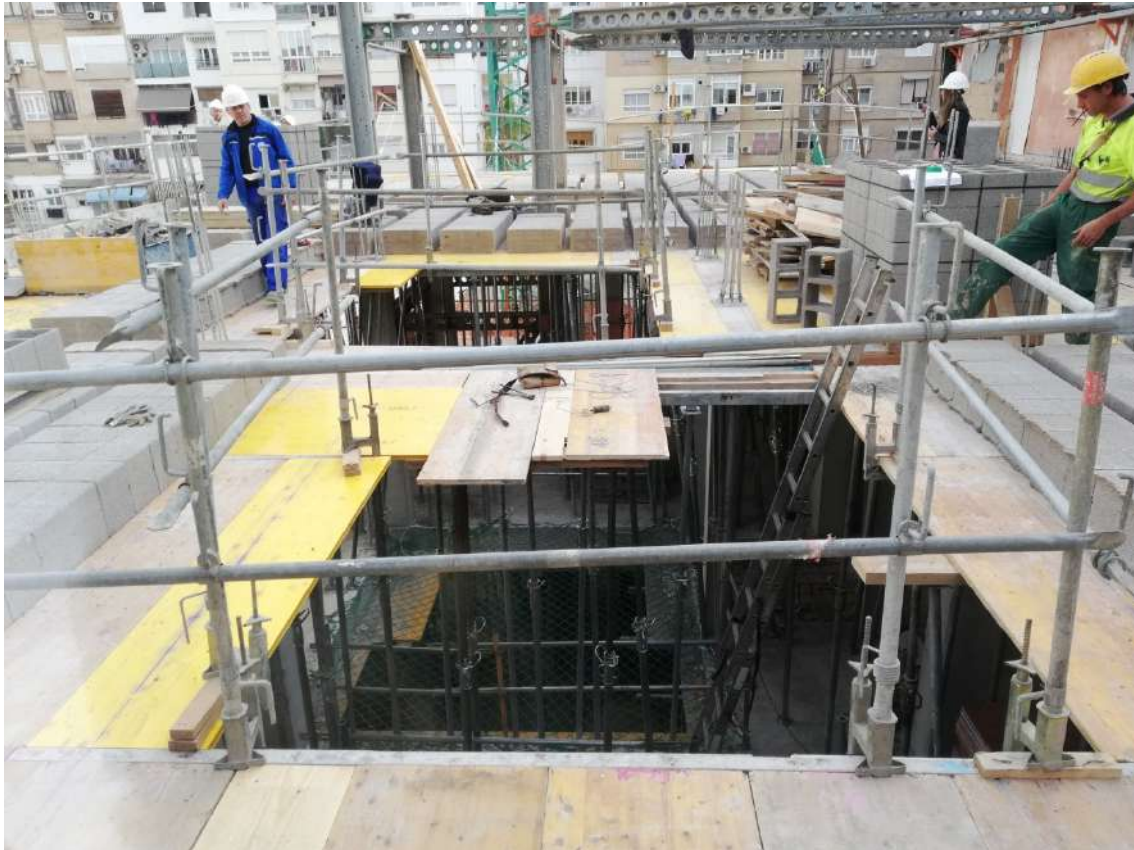
Ilustración 162. Montaje de forjado de planta cuarta.
