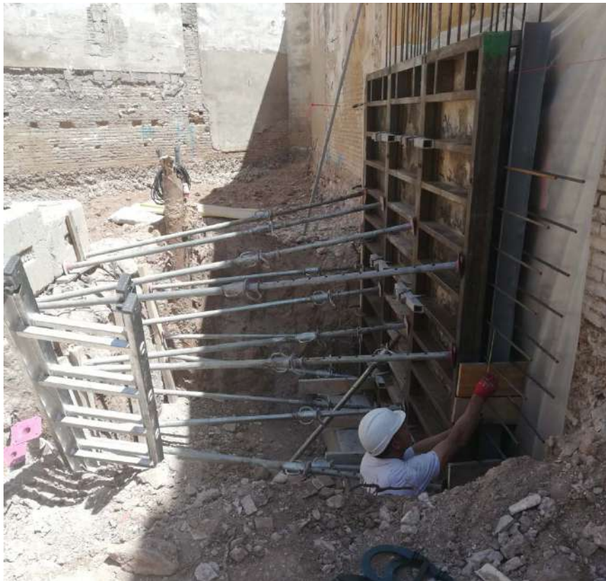
Ilustración 51. Encofrado de muro apuntalado contra el terreno.
