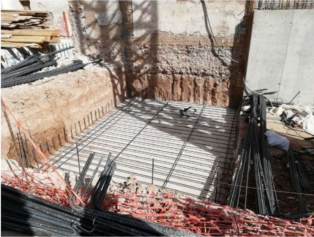
Ilustración 74. Armadura inferior de losa de cimentación.
