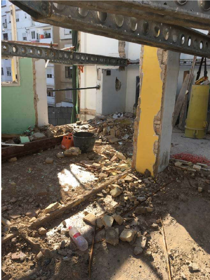
Ilustración 31. Visualización de la obra desde forjado de planta tercera.
