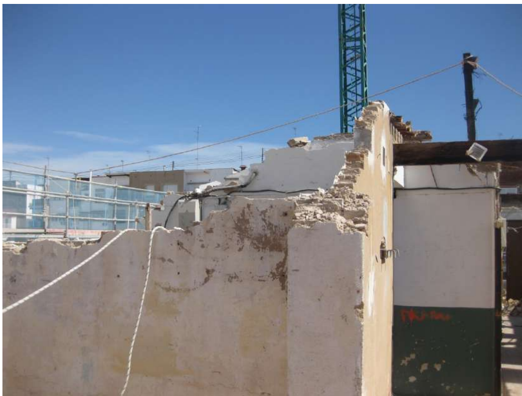
Ilustración 12. Parte superior de la caja de escalera ya derribada.
