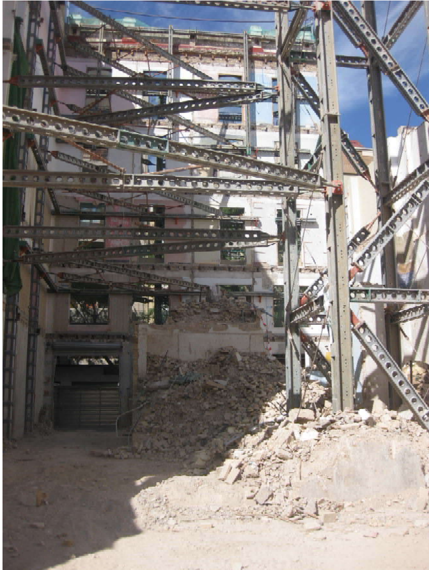
Ilustración 45.1. Demolición caja de escalera.
