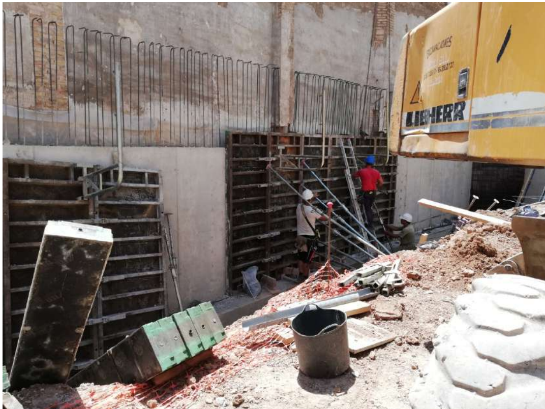
Ilustración 72. Desencofrado de muro perimetral.
