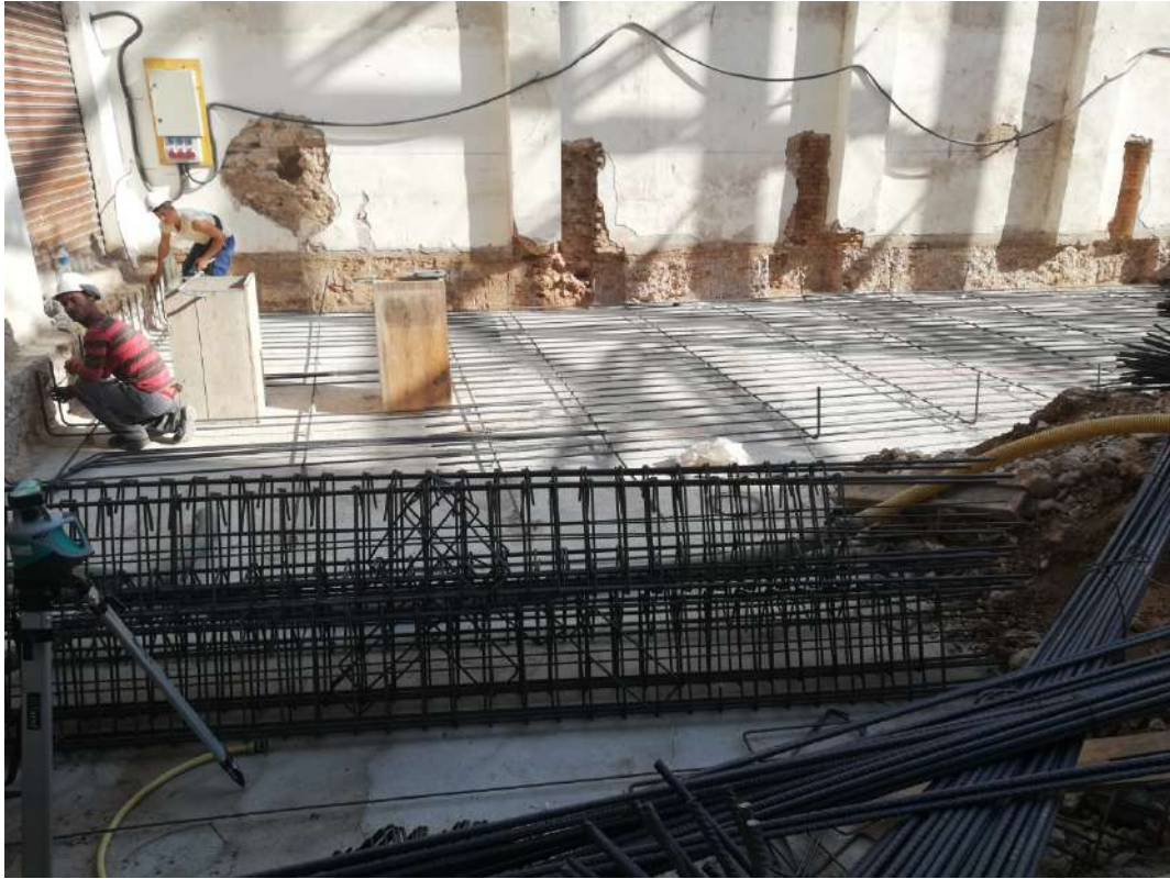
Ilustración 85. Colocación de armado de losa de cimentación.
