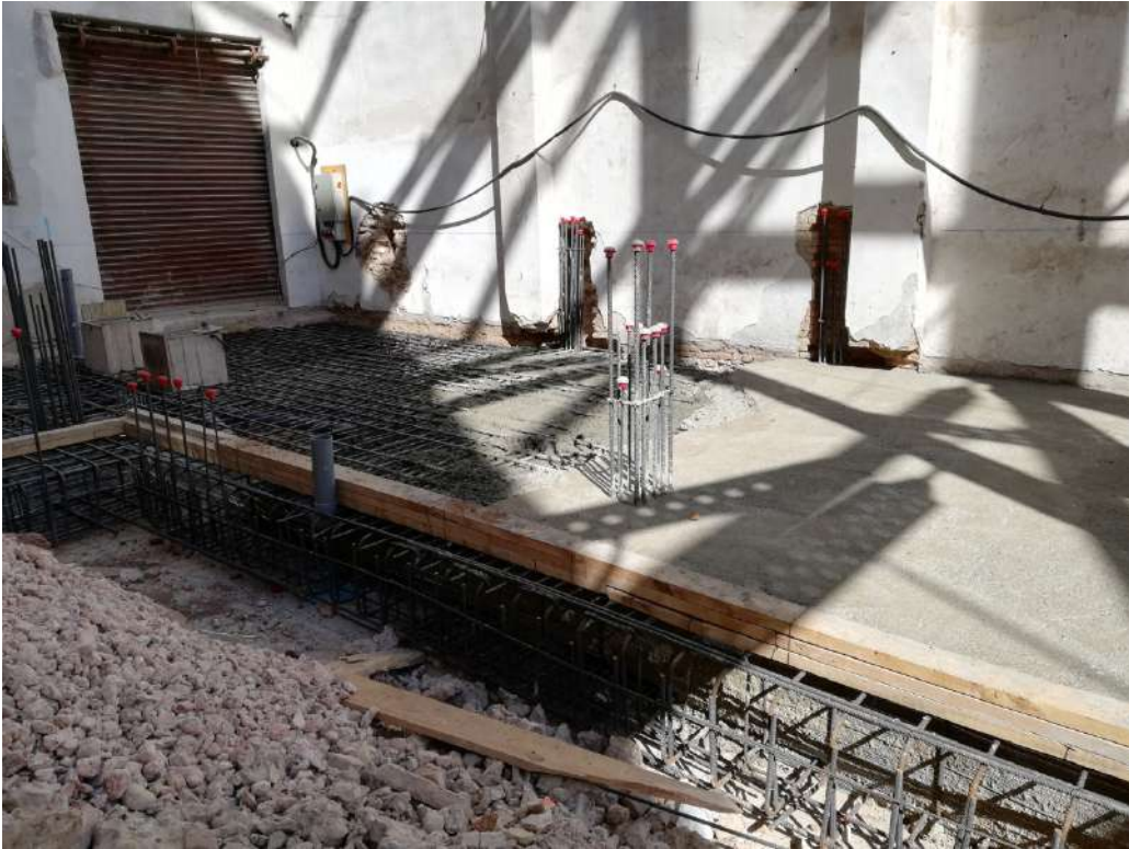
Ilustración 91. Tramo de losa ya hormigonado.
