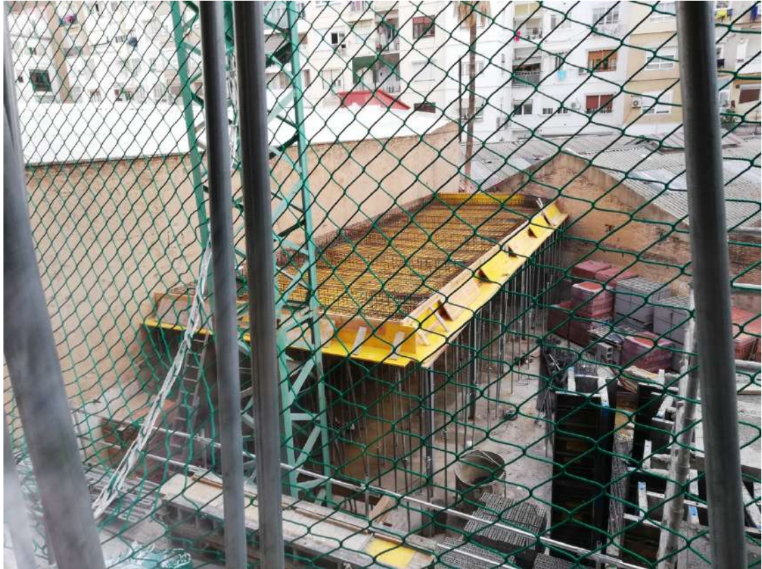
Ilustración 163. Cubierta de la piscina.
