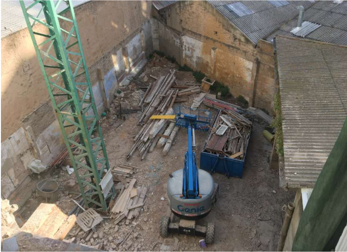
Ilustración 23. Material de retiro acumulado en el patio de manzana trasero.
