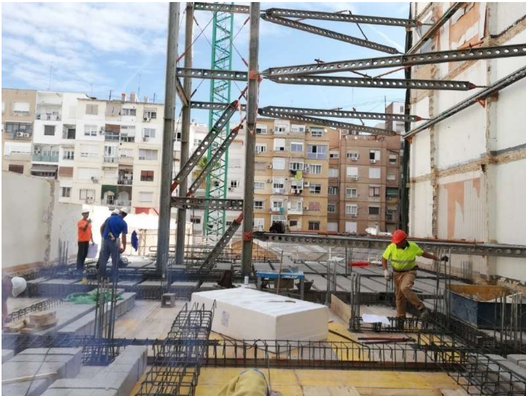
Ilustración 147. Montaje de forjado de planta segunda.
