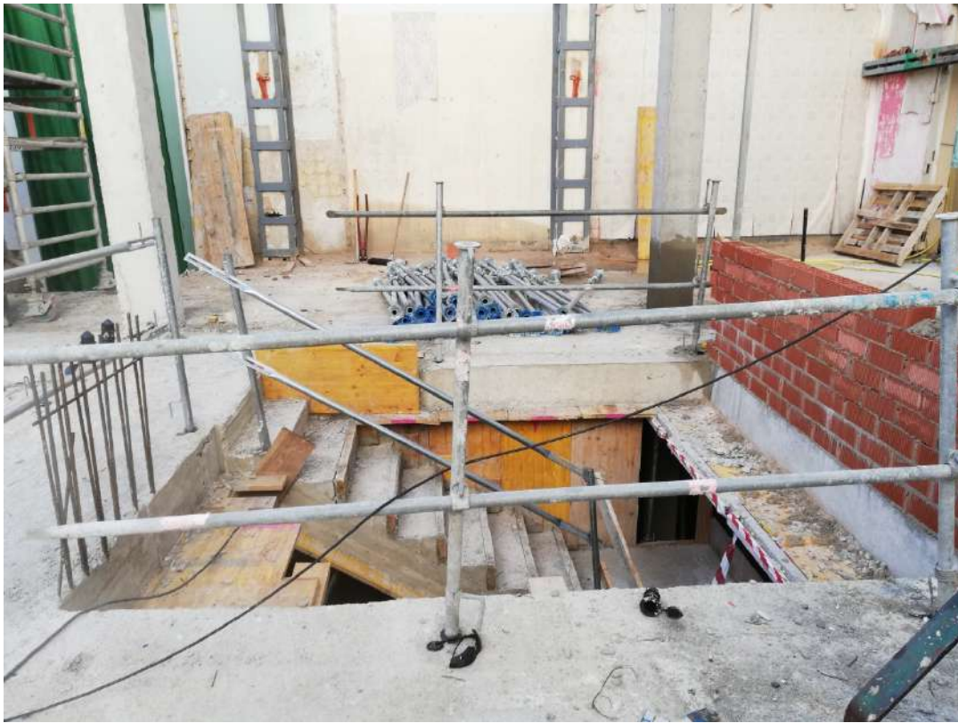
Ilustración 152. Tramo de escalera de acceso a planta segunda ya ejecutado.
