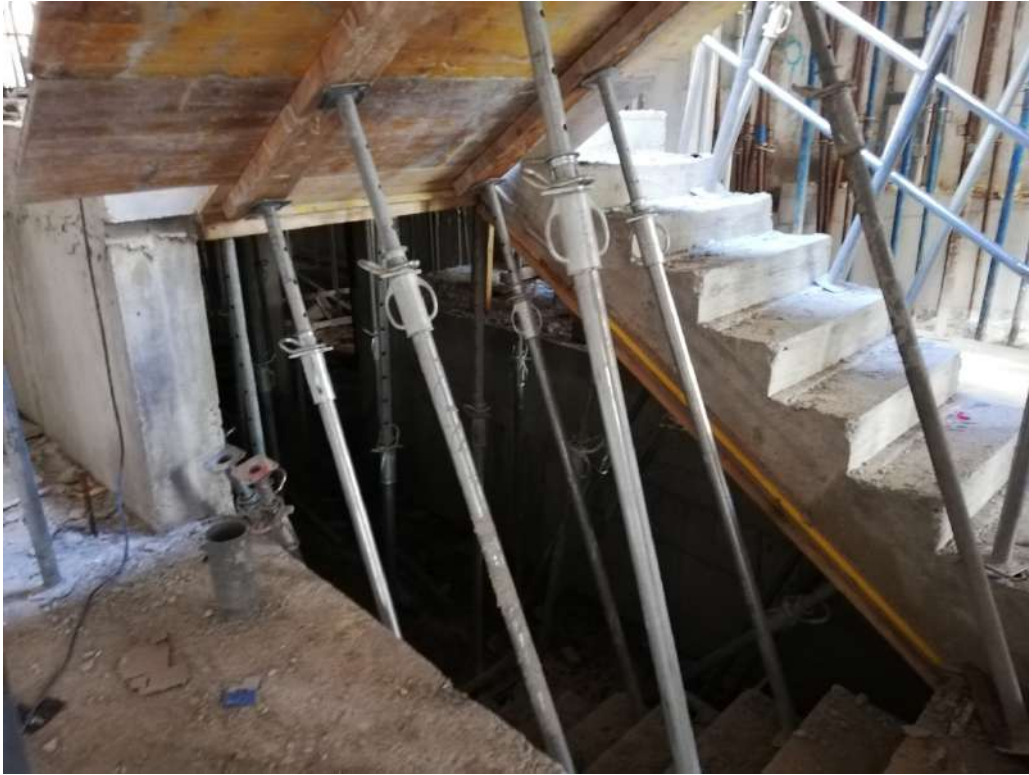
Ilustración 141. Tramo de escalera ya ejecutado.
