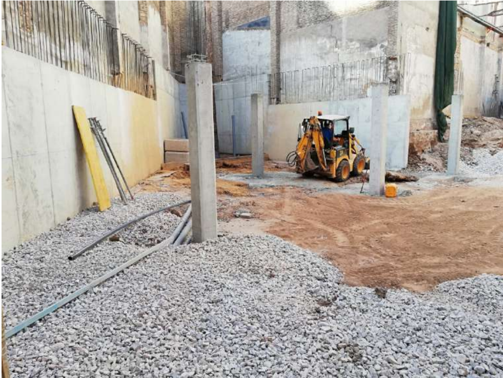
Ilustración 101. Miniexcavadora distribuyendo la grava.
