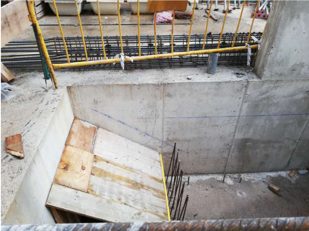
Ilustración 129. Replanteo de escalera de acceso al aparcamiento.
