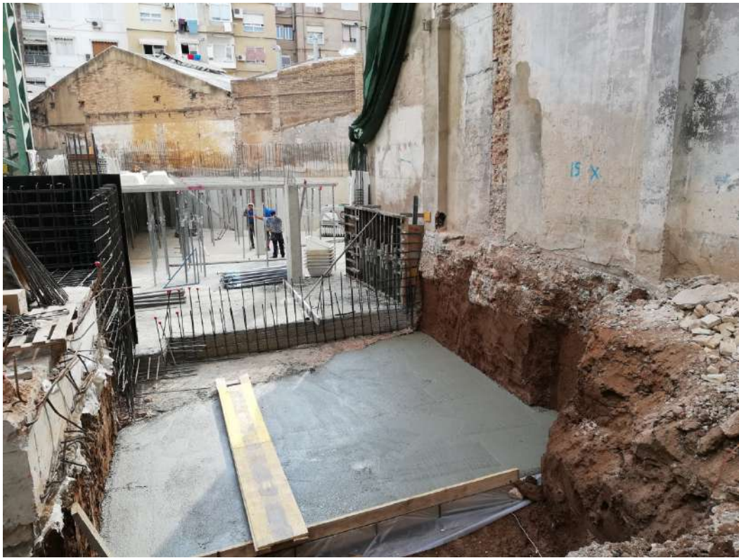
Ilustración 114. Vertido de hormigón de limpieza para tramo de losa.
