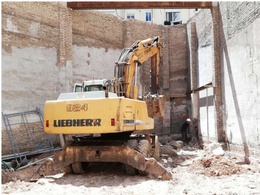
Ilustración 57. Picaje de pilar medianero y excavación en la zona.
