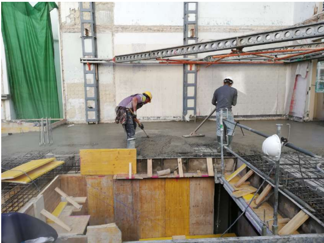
Ilustración 151. Reparto de hormigón por toda la superficie.
