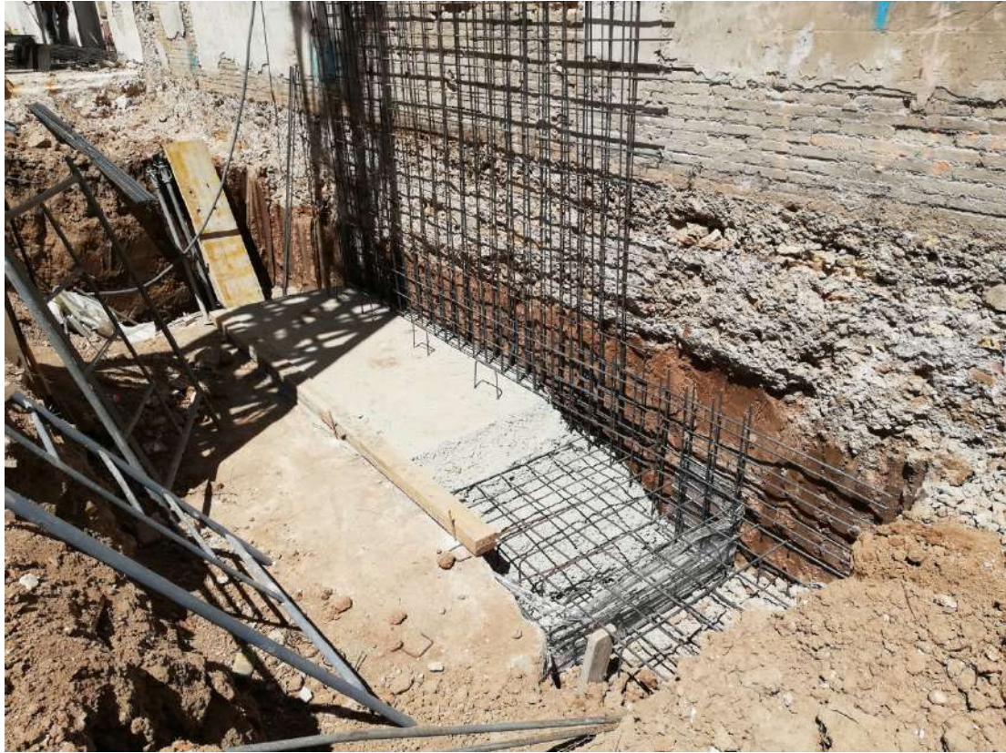
Ilustración 56. Armadura muro perimetral junto a grúa torre.
