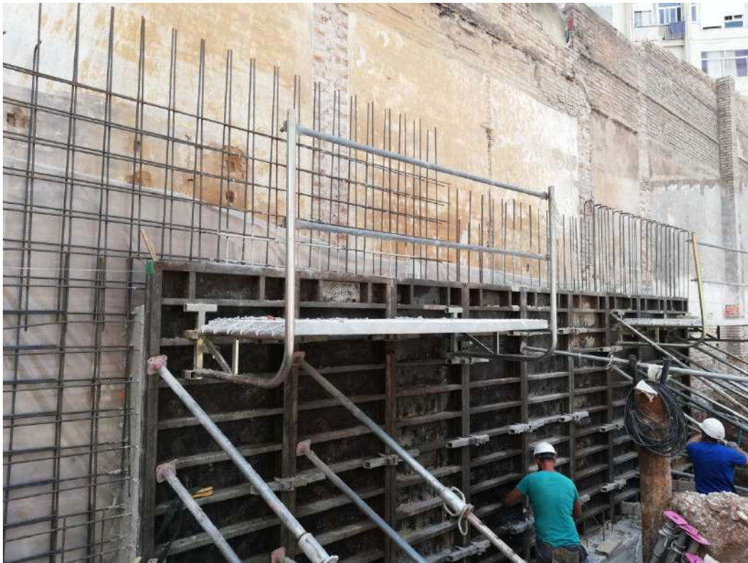
Ilustración 52. Desencofrado de muro perimetral.
