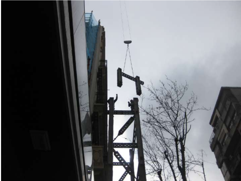
Ilustración 3. Colocación de estructura metálica del estabilizador de fachada.
