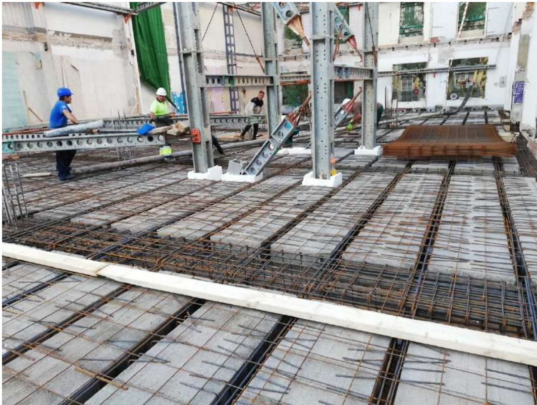
Ilustración 138. Armado de forjado unidireccional de planta primera.
