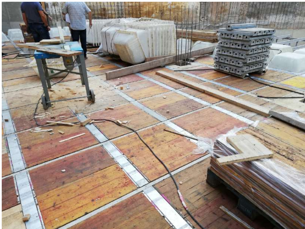
Ilustración 115. Montaje de encofrado de forjado.
