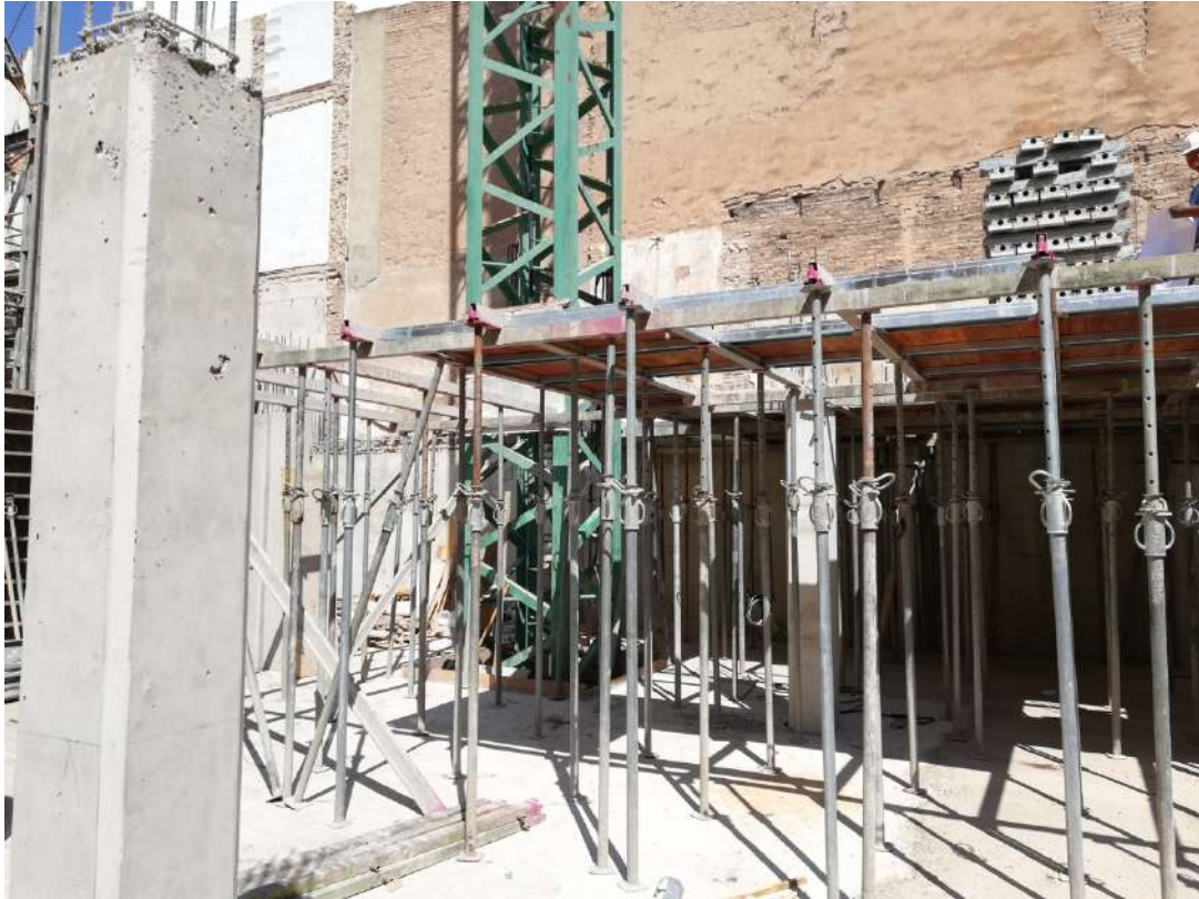
Ilustración 112. Montaje de encofrado de forjado reticular.
