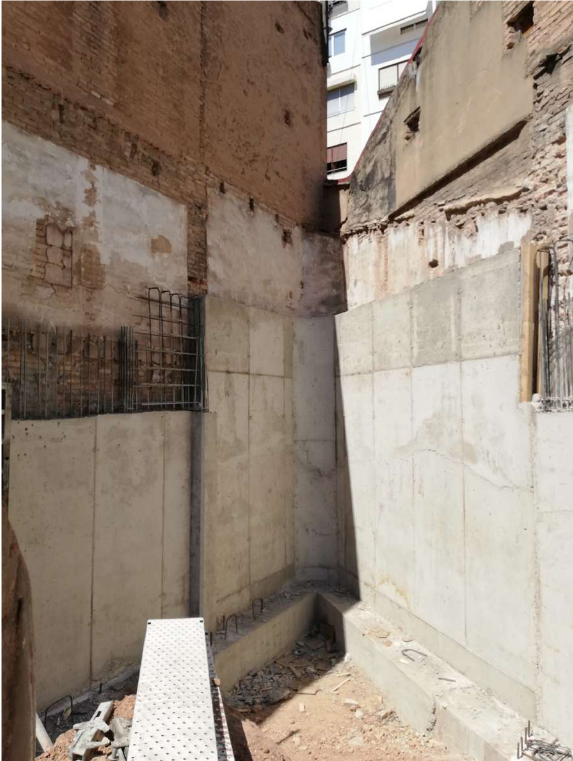
Ilustración 65. Muro curvo medianero con el cine.
