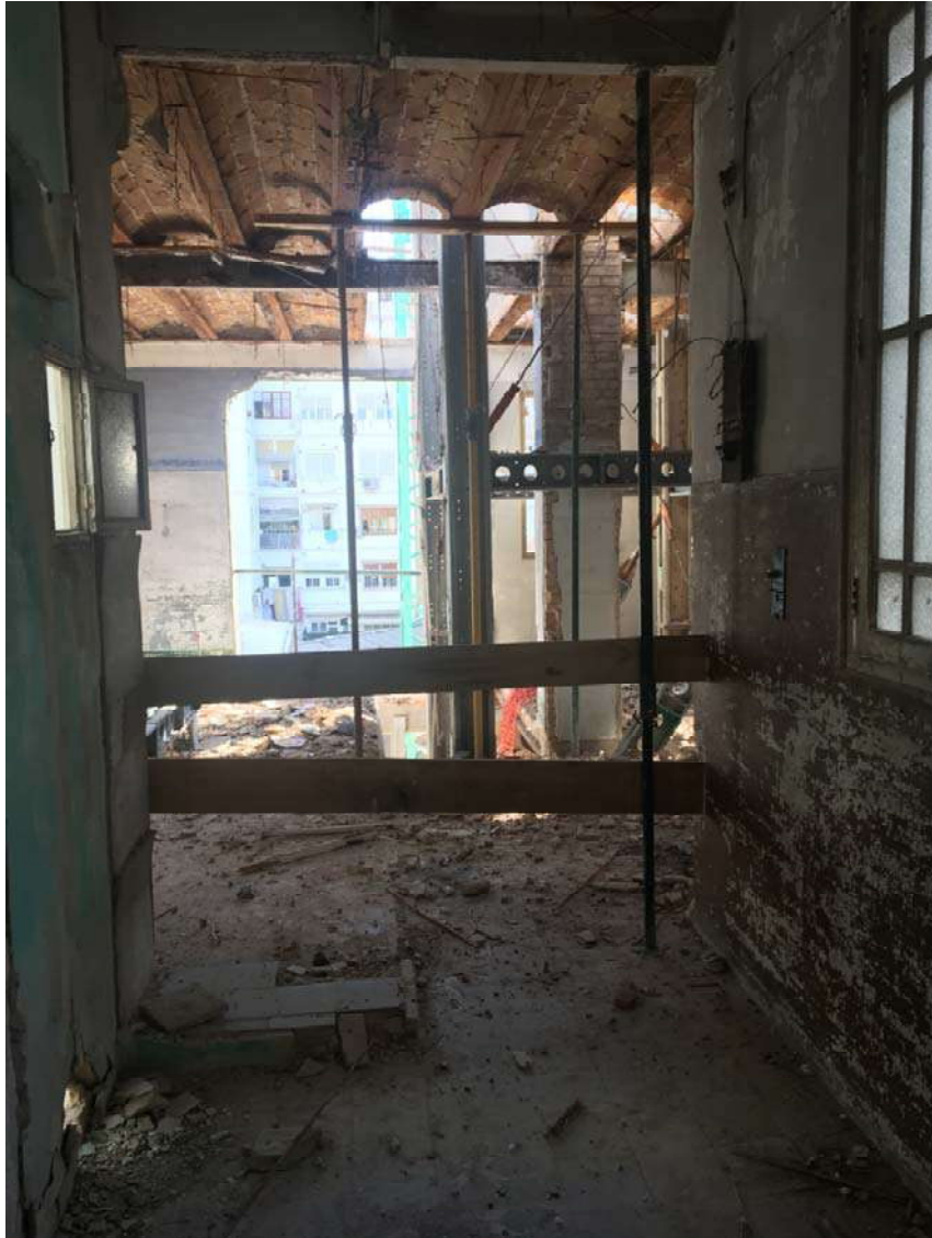
Ilustración 20. Parte del forjado de planta quinta sin demoler.
