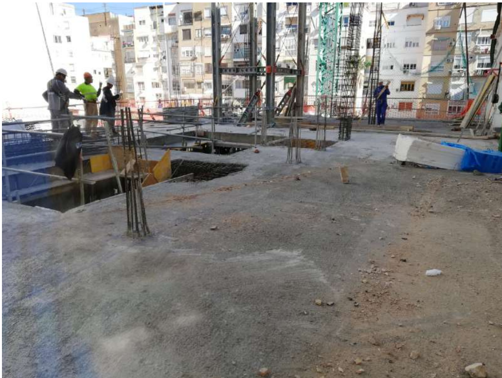
Ilustración 160. Forjado de planta tercera ya hormigonado.
