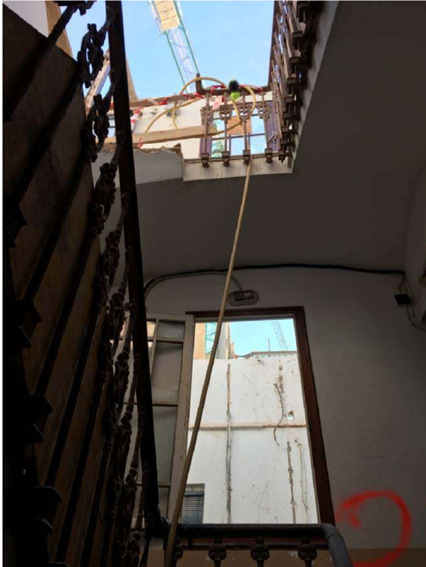
Ilustración 30. Hueco de caja de escalera.
