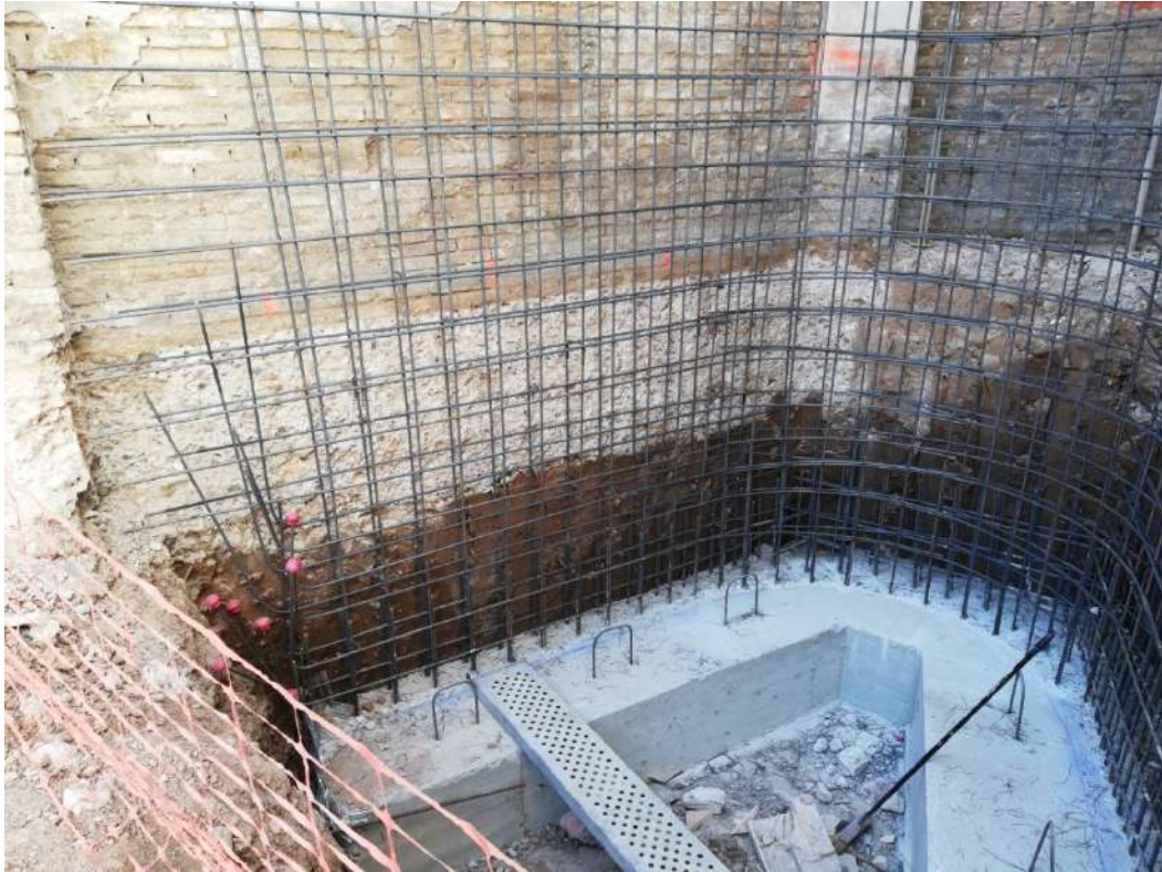
Ilustración 61. Armado de muro curvo medianero con local comercial.
