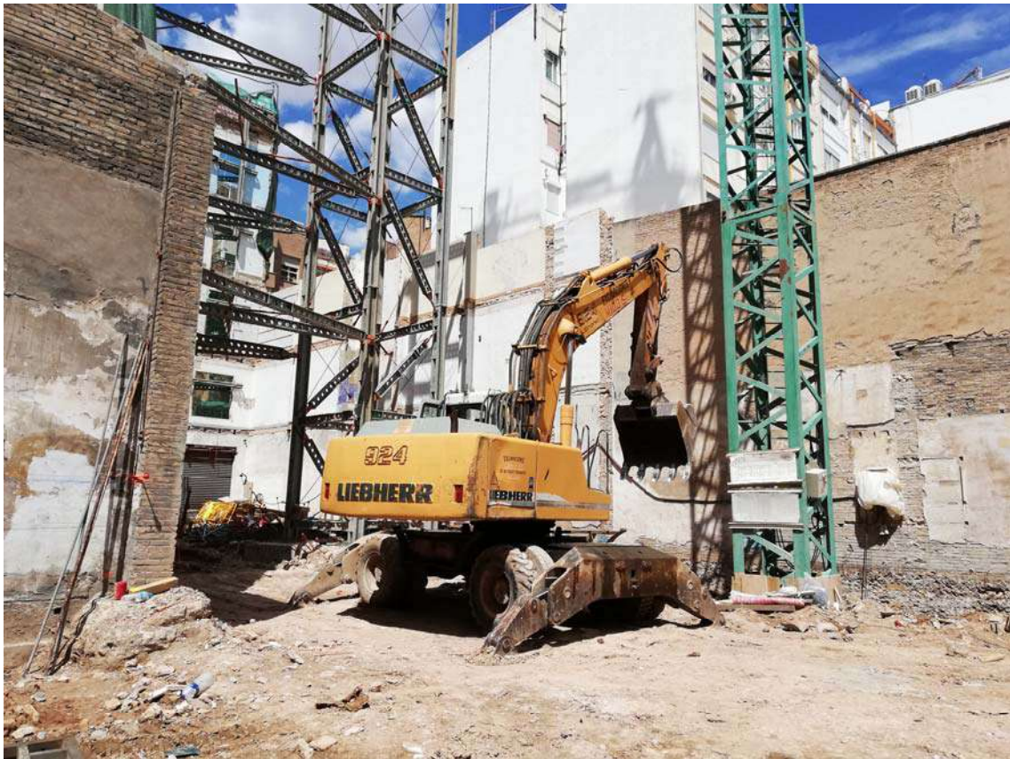
Ilustración 57.1. Trabajos de excavación.
