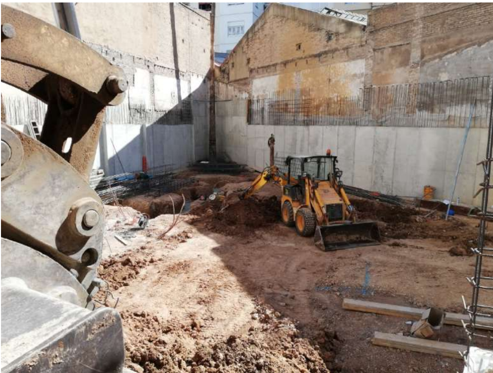
Ilustración 92. Excavación de zapatas aisladas y vigas.
