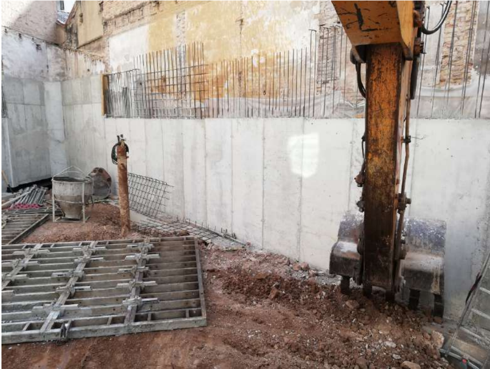
Ilustración 76. Rebaje de cota de excavación.
