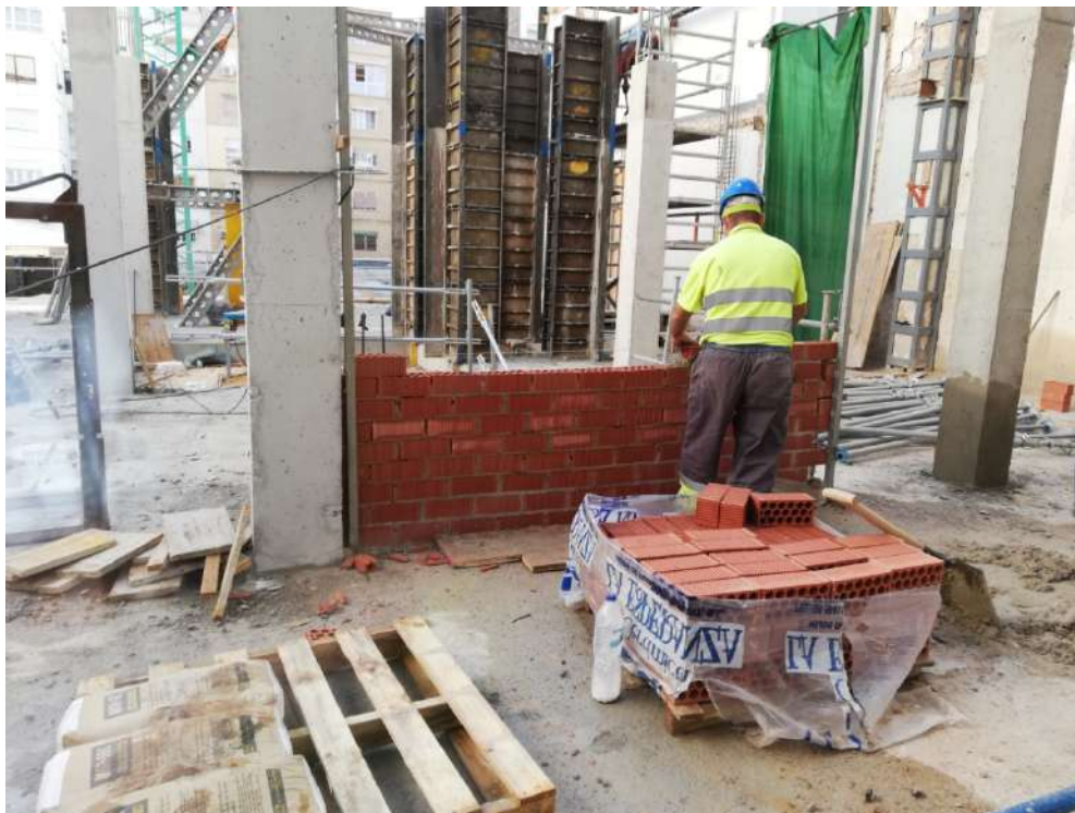
Ilustración 153. Ejecución de mureta.
