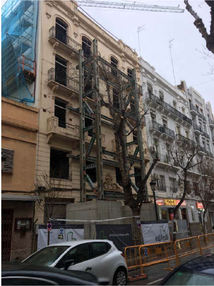
Ilustración 2. Instalación de últimos tramos de estabilizador de fachada.
