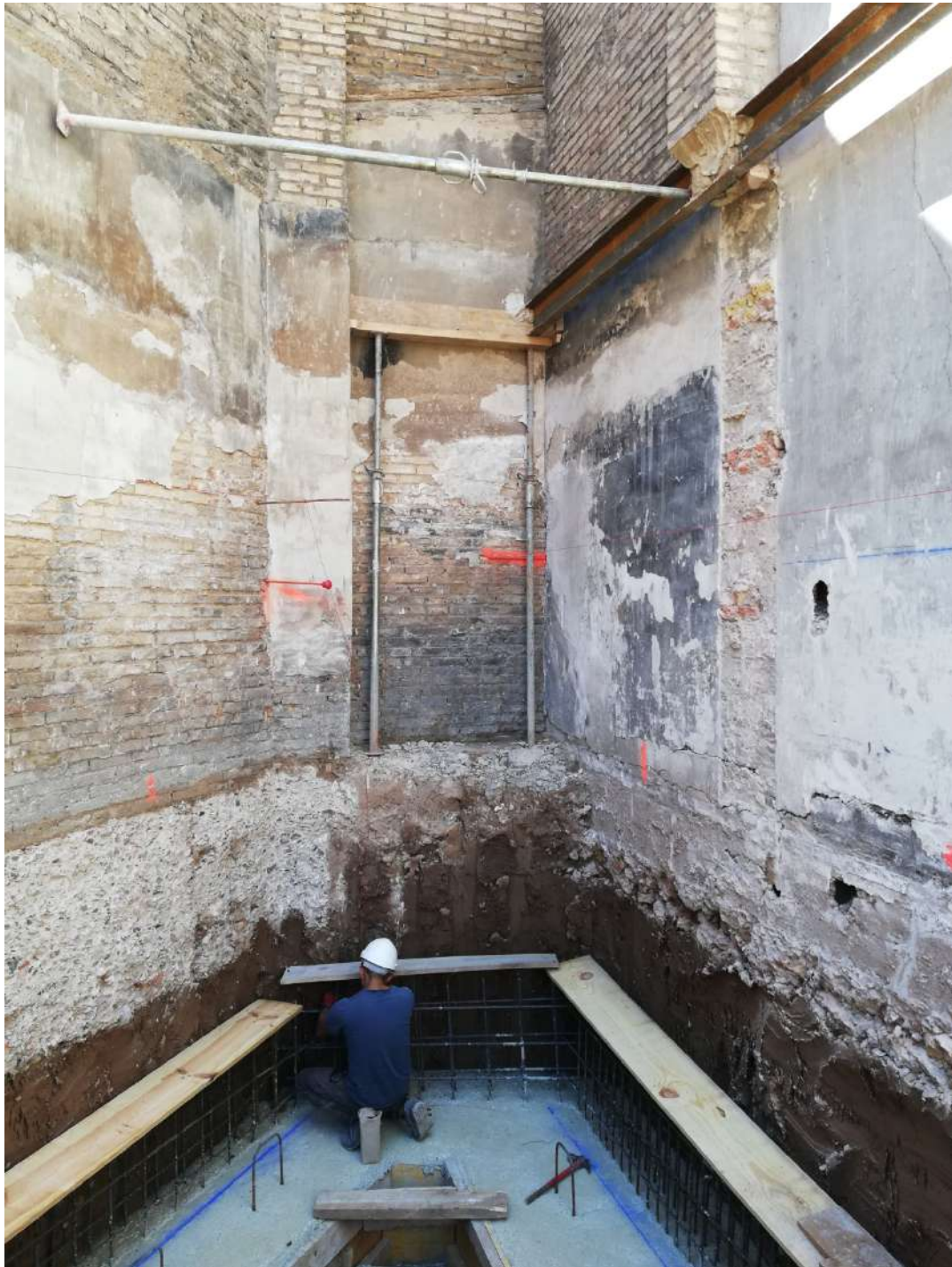
Ilustración 58. Tablonces de madera sobre armaduras en espera.
