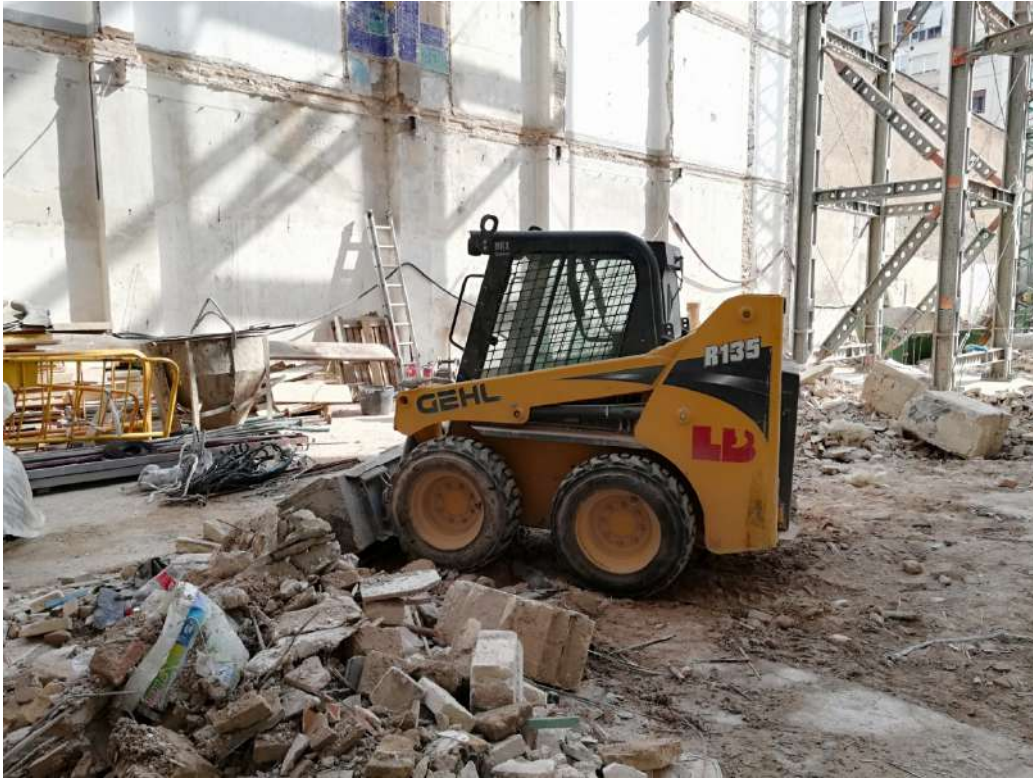
Ilustración 46. Pala cargadora retirando escombros.
