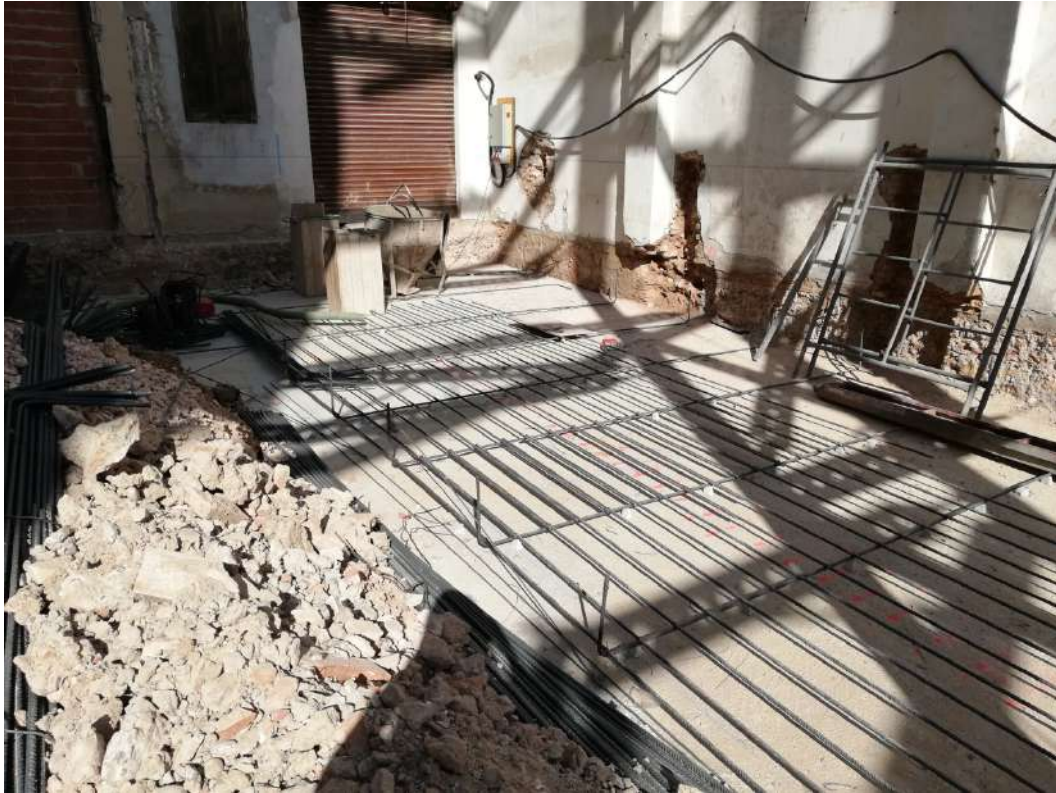
Ilustración 82. Colocación armado inferior de losa de cimentación.
