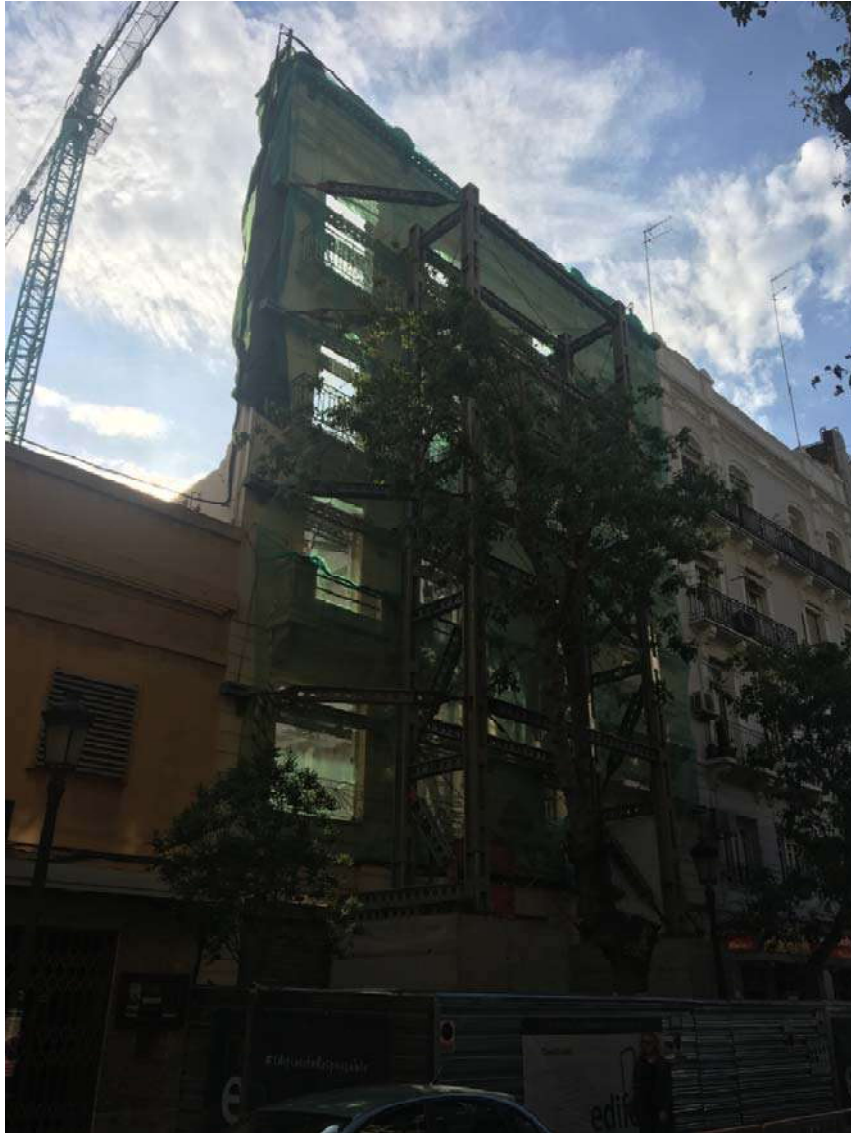
Ilustración 38. Visualización de la fachada principal tras demolición de la estructura.
