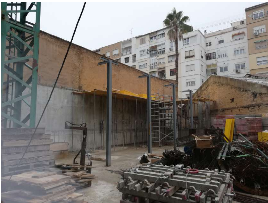
Ilustración 158. Pilares y encofrado de cubierta de la piscina.
