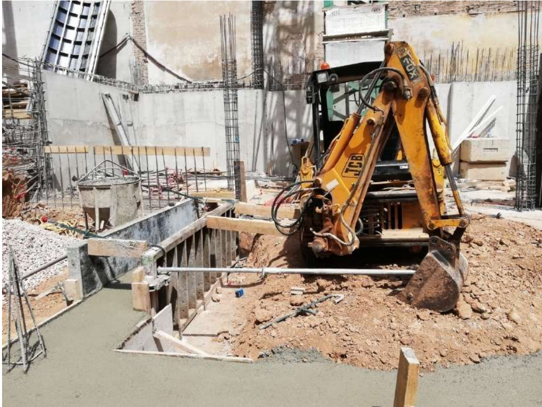
Ilustración 97. Hormigonado últimas vigas de atado y centradora.
