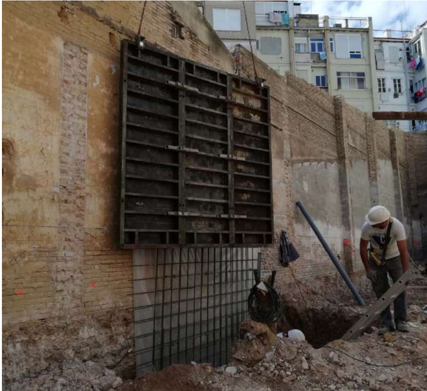
Ilustración 50. Colocación de encofrado para muro de hormigón visto.
