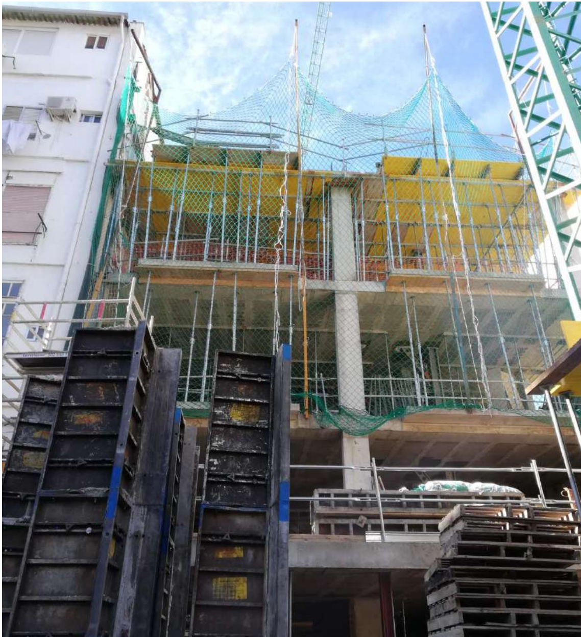
Ilustración 165. Visualización de la obra desde la zona del aparcamiento y piscina.
