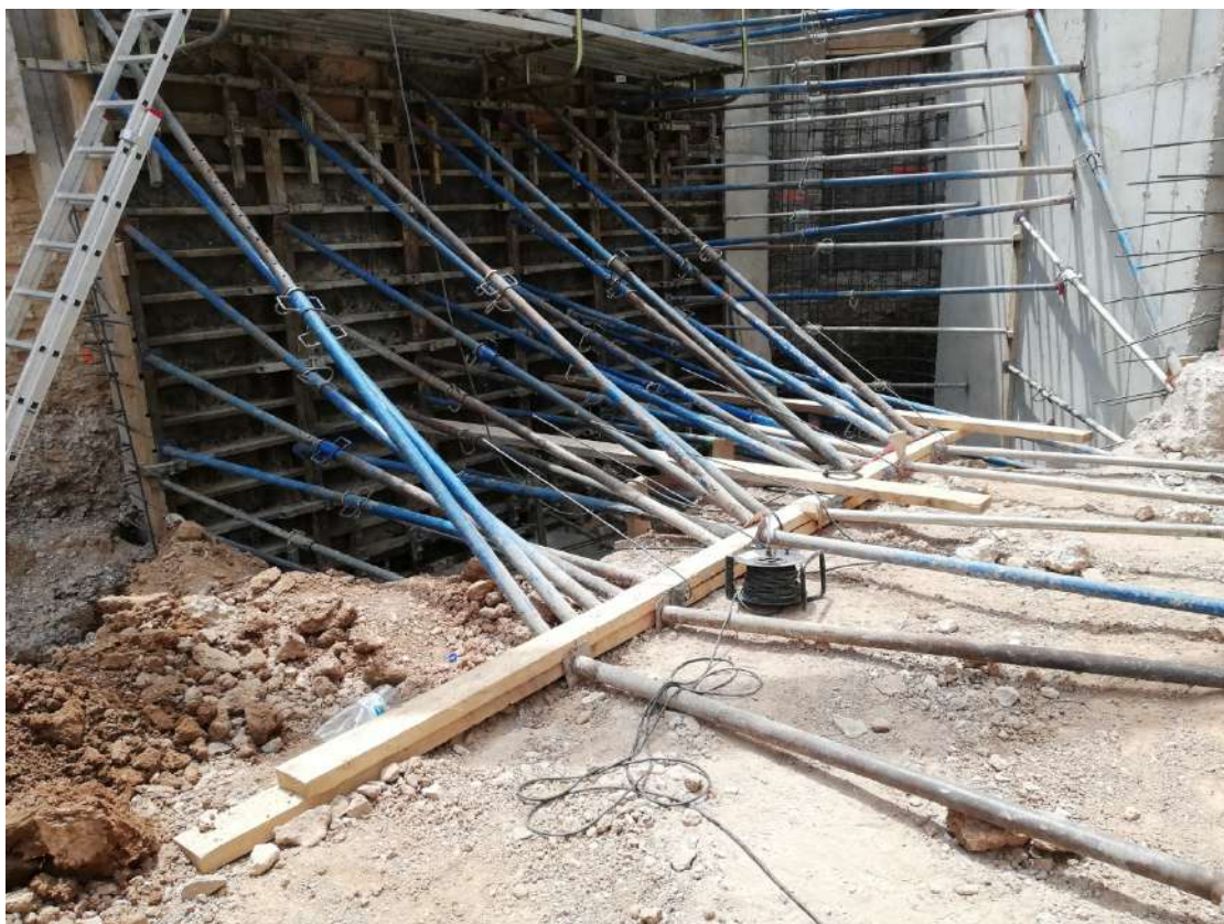
Ilustración 68. Apuntalado de encofrado de muro perimetral.
