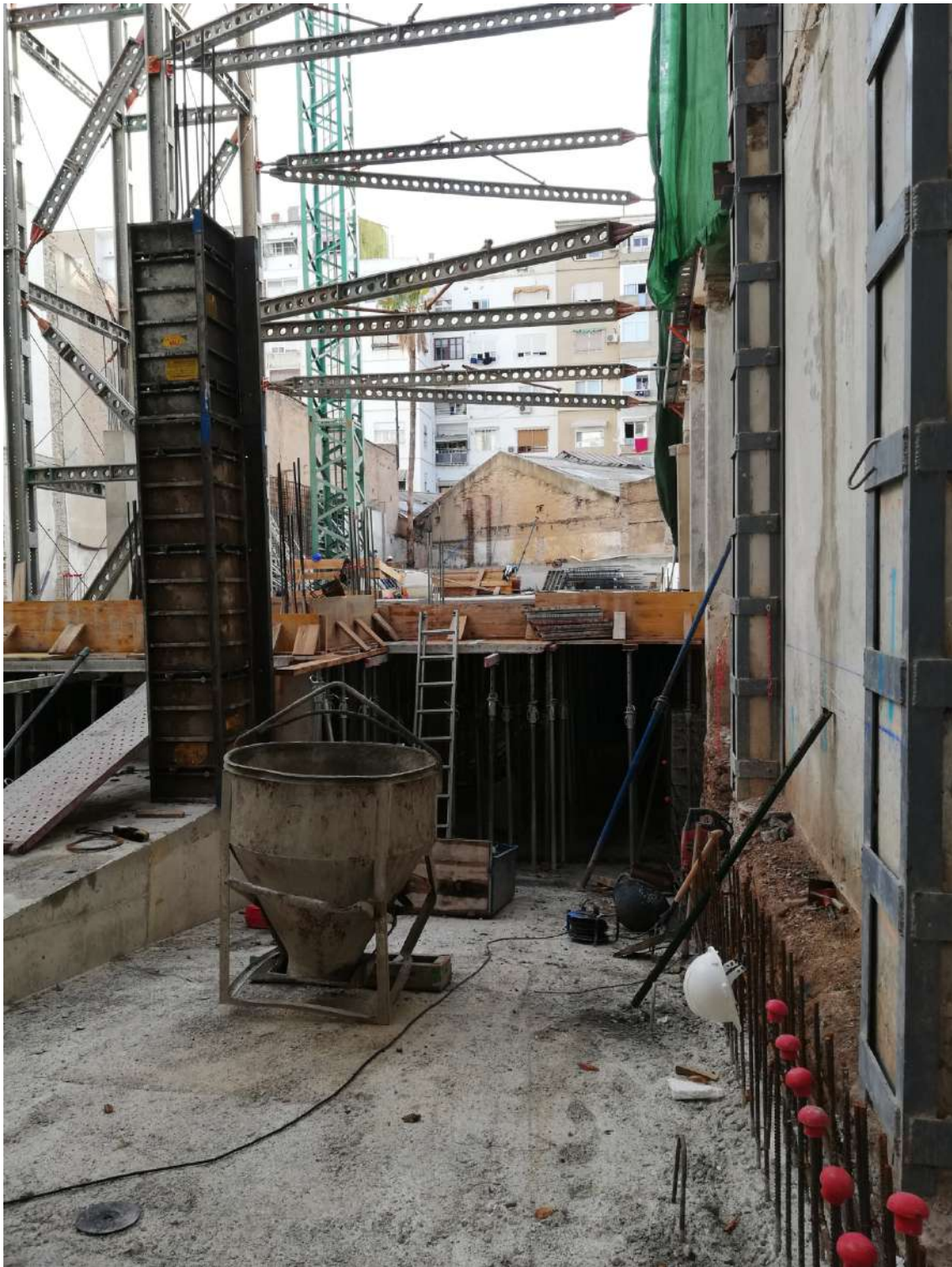
Ilustración 128. Rampa de acceso al aparcamiento ya hormigonada.
