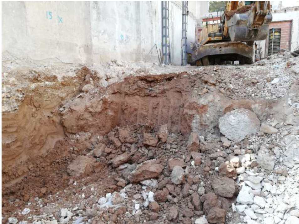
Ilustración 111. Excavación para formación de losa.
