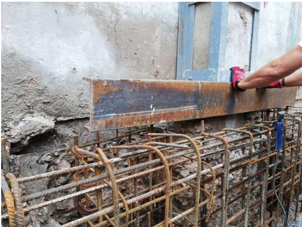
Ilustración 133. Colocación de perfil en U.
