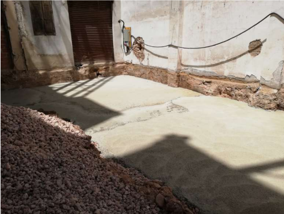
Ilustración 70. Hormigón de limpieza en losa de cimentación.
