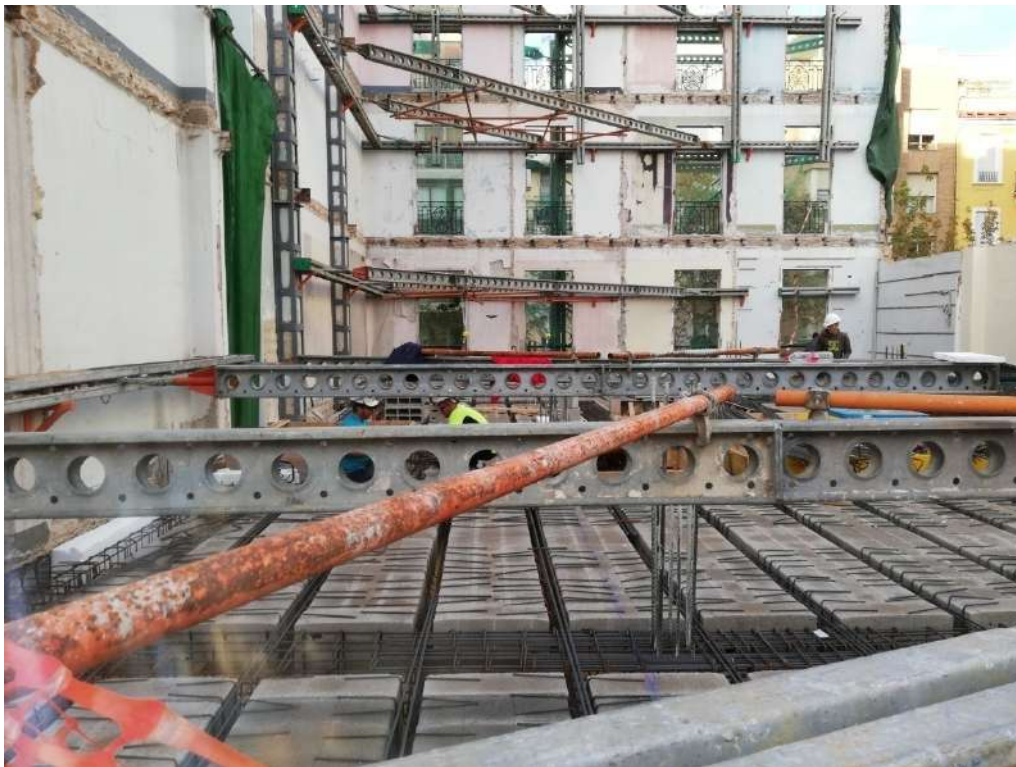
Ilustración 149. Montaje forjado de planta segunda.
