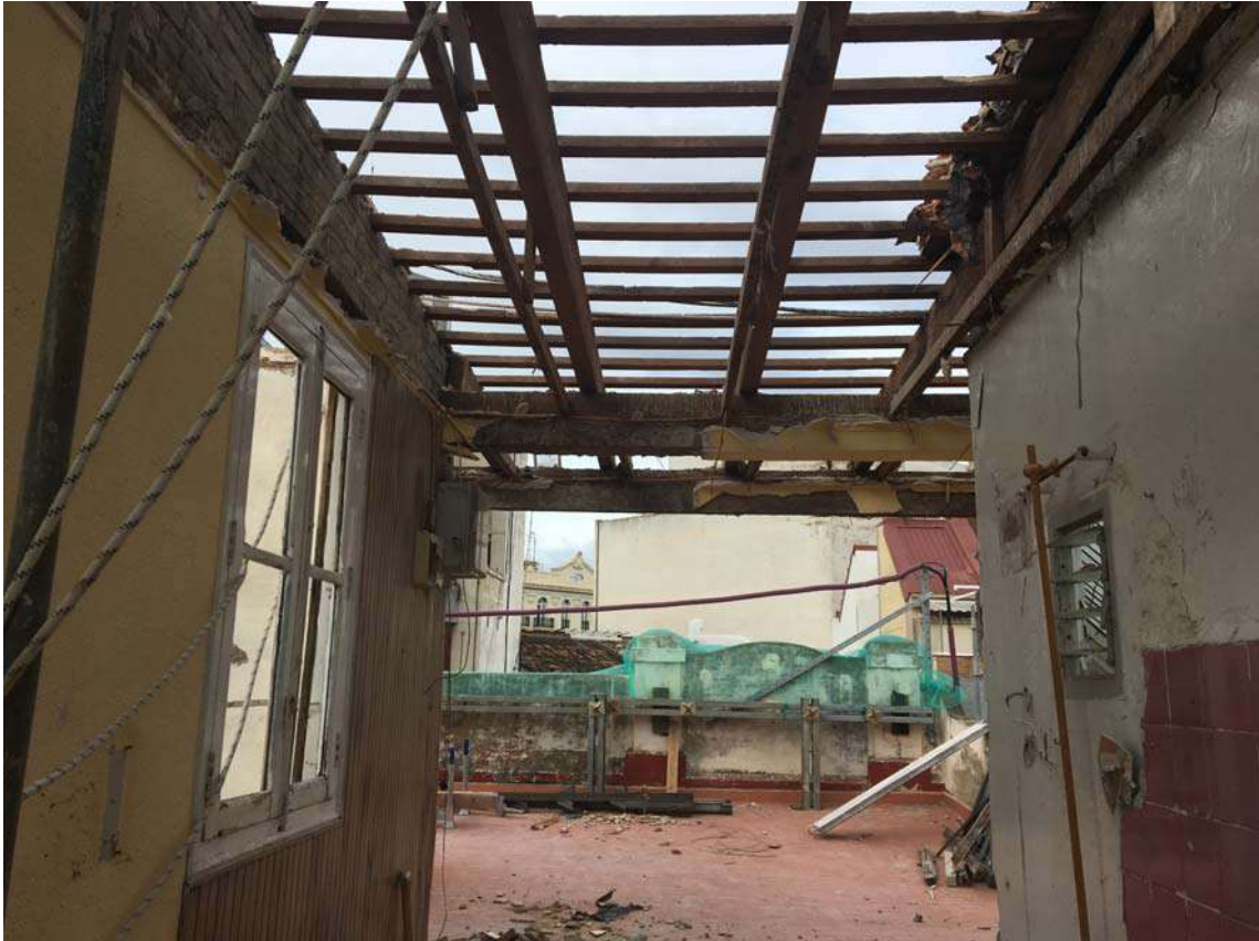
Ilustración 8.2. Trabajos de demolición.
