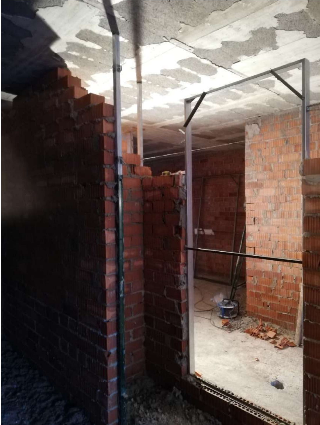
Ilustración 169. Formación de tabiquería interior en entreplanta.
