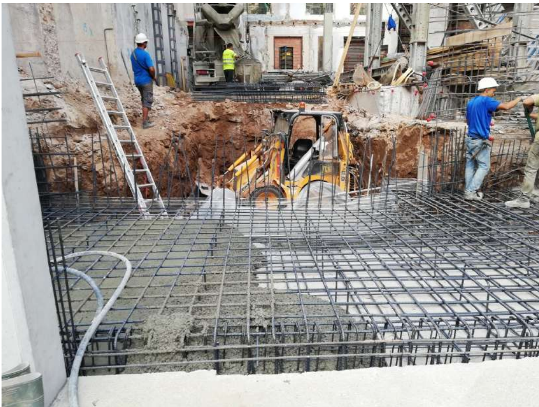
Ilustración 107. Hormigonado siguiente tramo de losa a cota -1,70 m.
