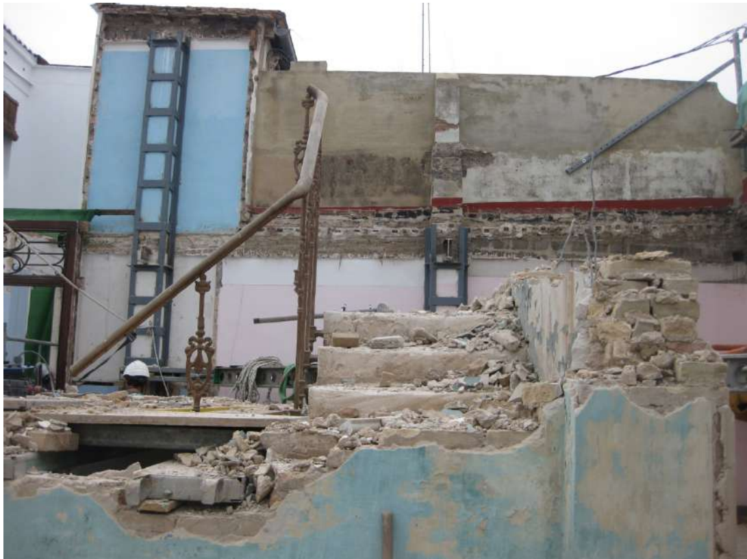
Ilustración 27. Caja de escalera.
