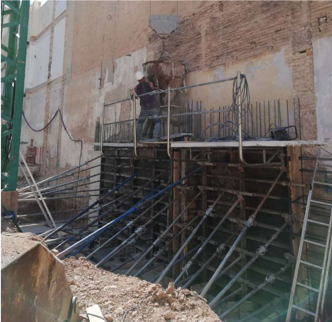
Ilustración 64. Vertido de hormigón con cubilote.
