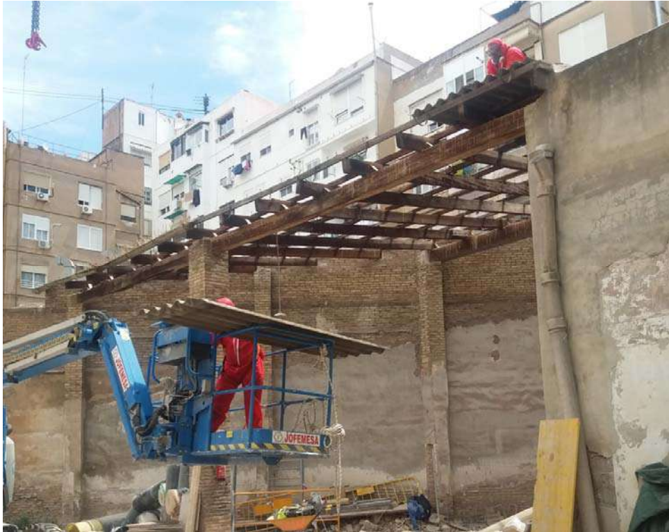
Ilustración 44. Operarios retirando material con amianto.
