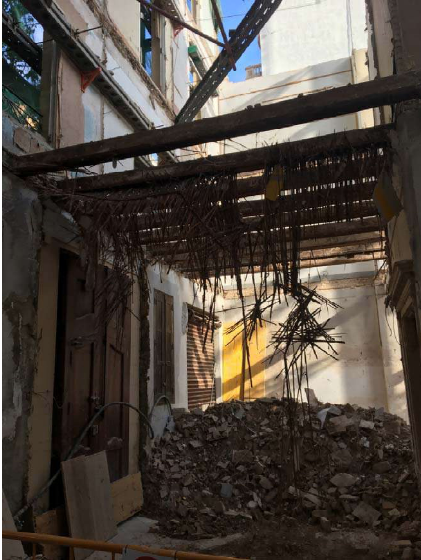
Ilustración 39. Parte de viguetas de madera de forjado sin retirar.
