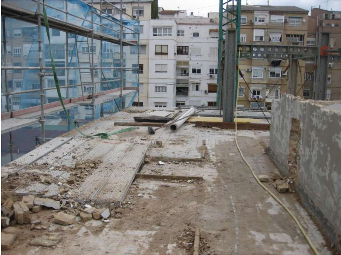
Ilustración 26. Fachada medianera con el cine demolida hasta cota forjado planta cuarta.
