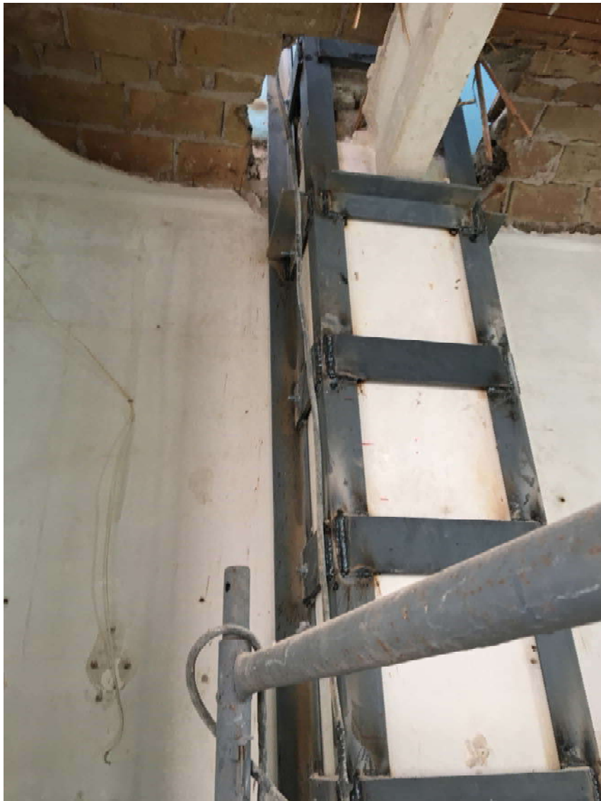
Ilustración 5.1. Pilar empresillado.
