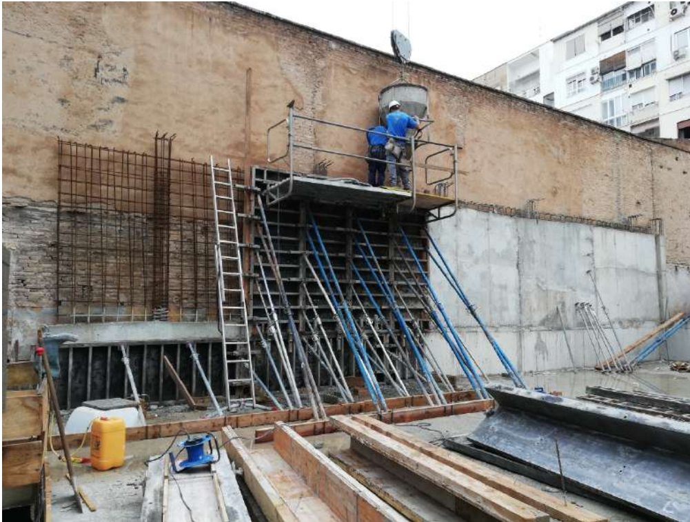
Ilustración 131. Hormigonado de muro perimetral medianero con el cine.
