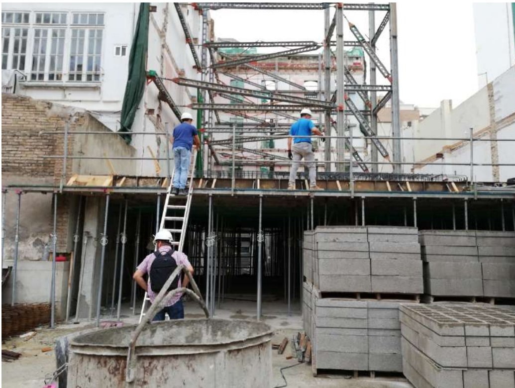
Ilustración 135. Encofrado de forjado unidireccional de planta primera.
