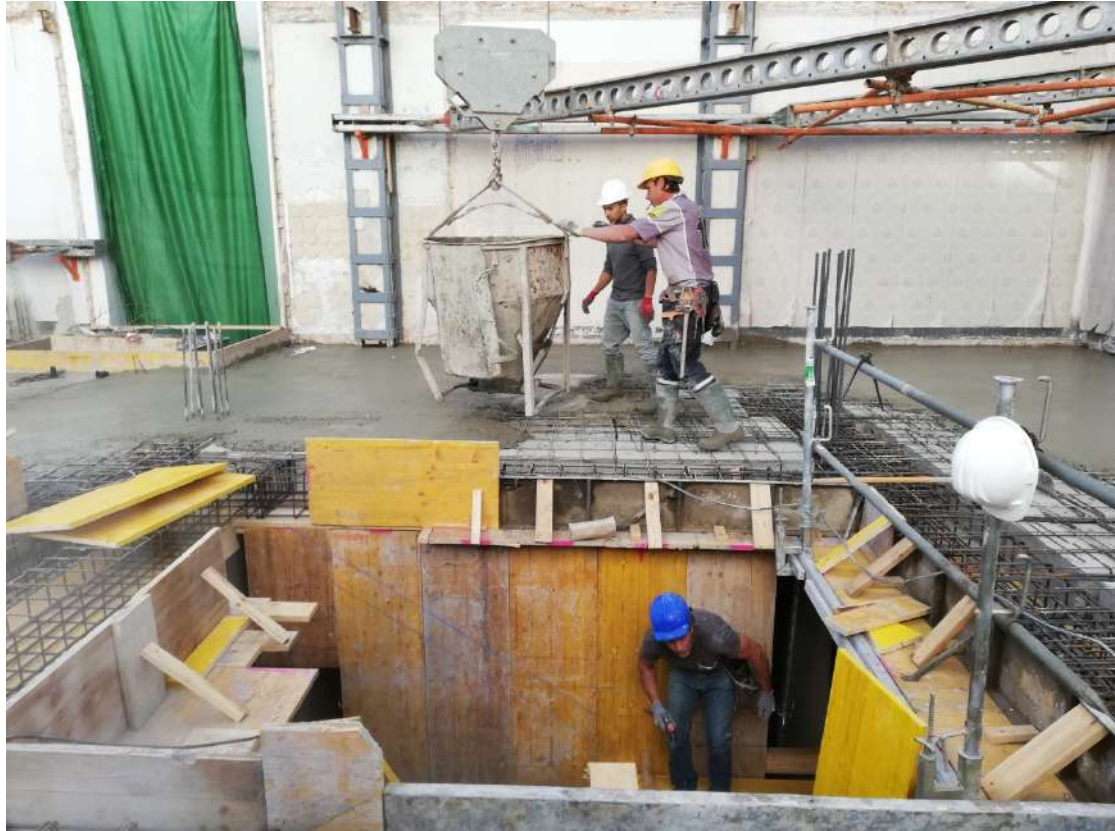
Ilustración 150. Vertido de hormigón.
