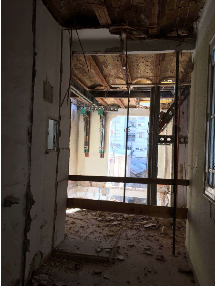
Ilustración 27.1. Demoliciones planta cuarta.
