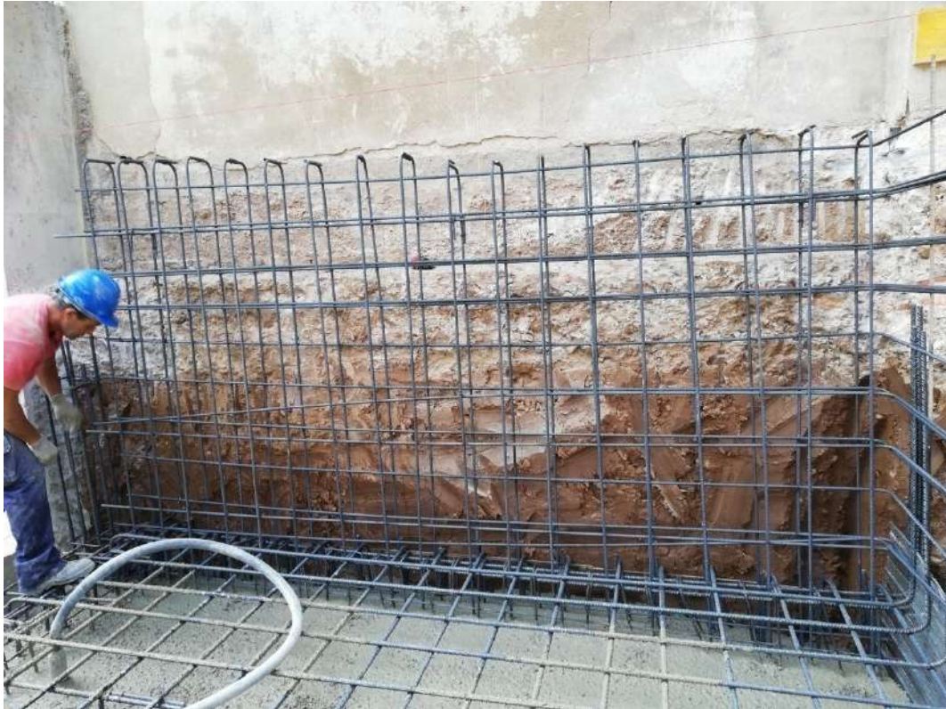
Ilustración 108. Colocación de armaduras en muro medianero con edificio anexo.
