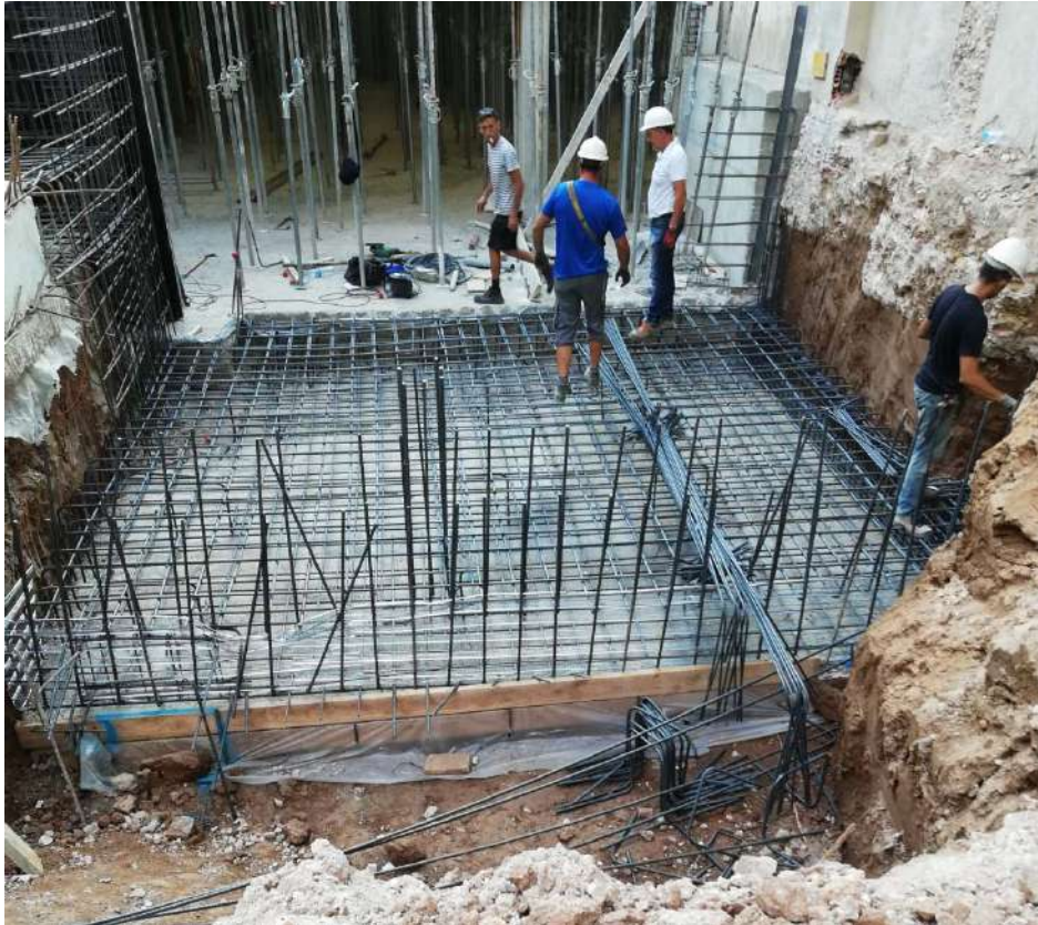
Ilustración 116. Losa de cimentación ya armada.
