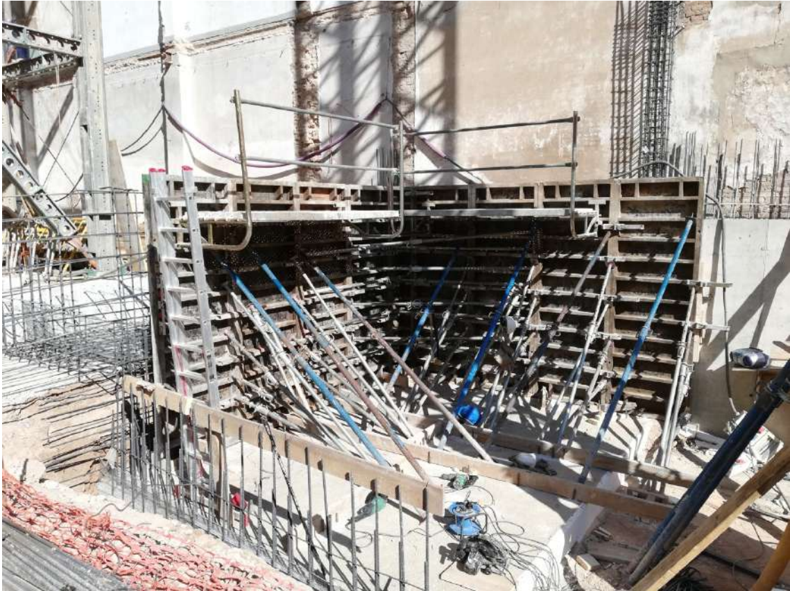
Ilustración 84. Encofrado de muro divisorio entre losas de cimentación a distinta cota.
