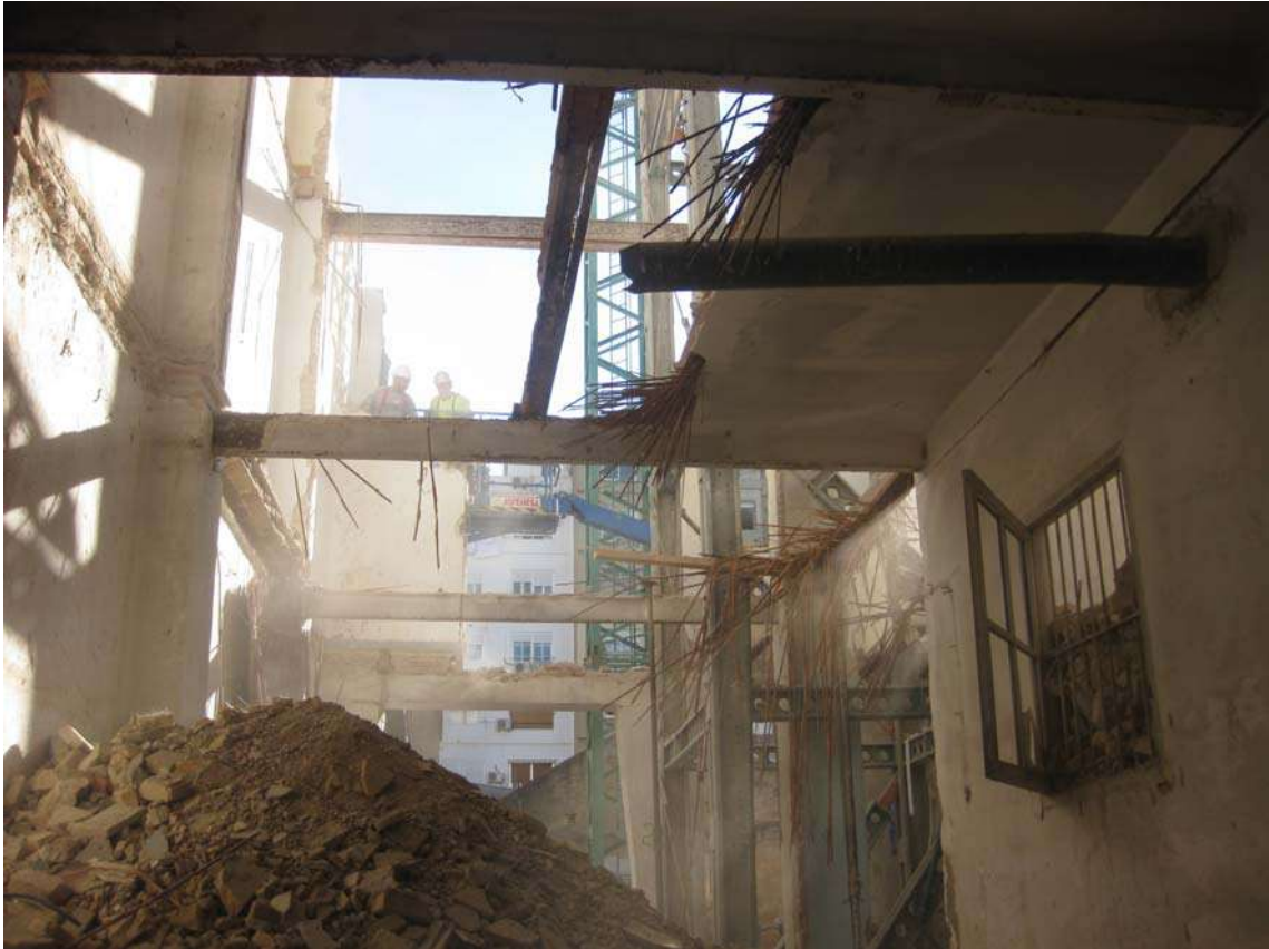
Ilustración 37.1. Demolición forjado planta primera.
