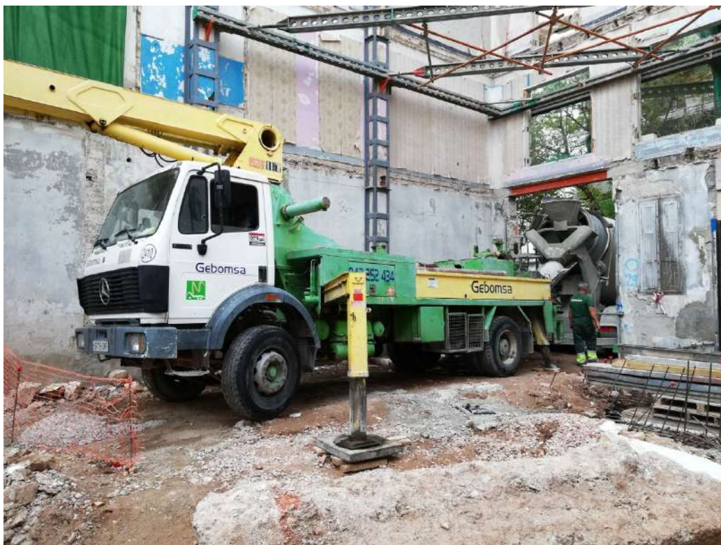
Ilustración 121. Camión para hormigonado por bombeo estacionado.
