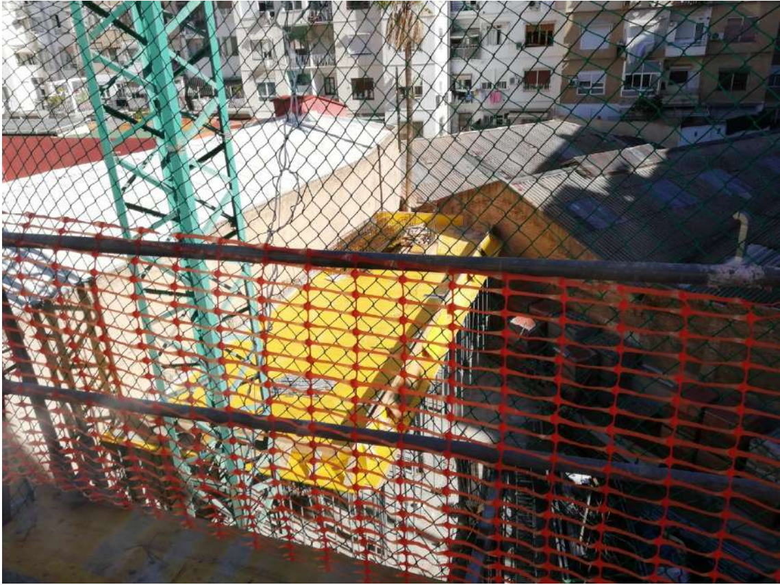
Ilustración 161. Montaje de encofrado de cubierta de la piscina.
