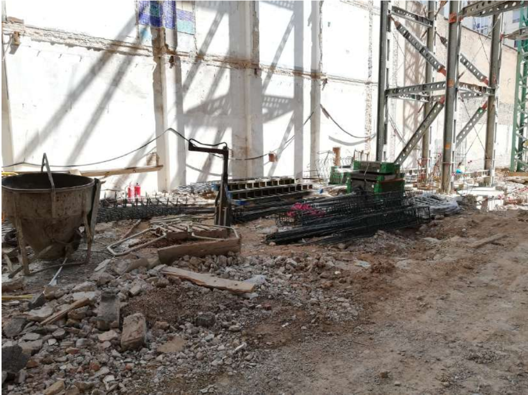
Ilustración 59. Material acopiado en obra.
