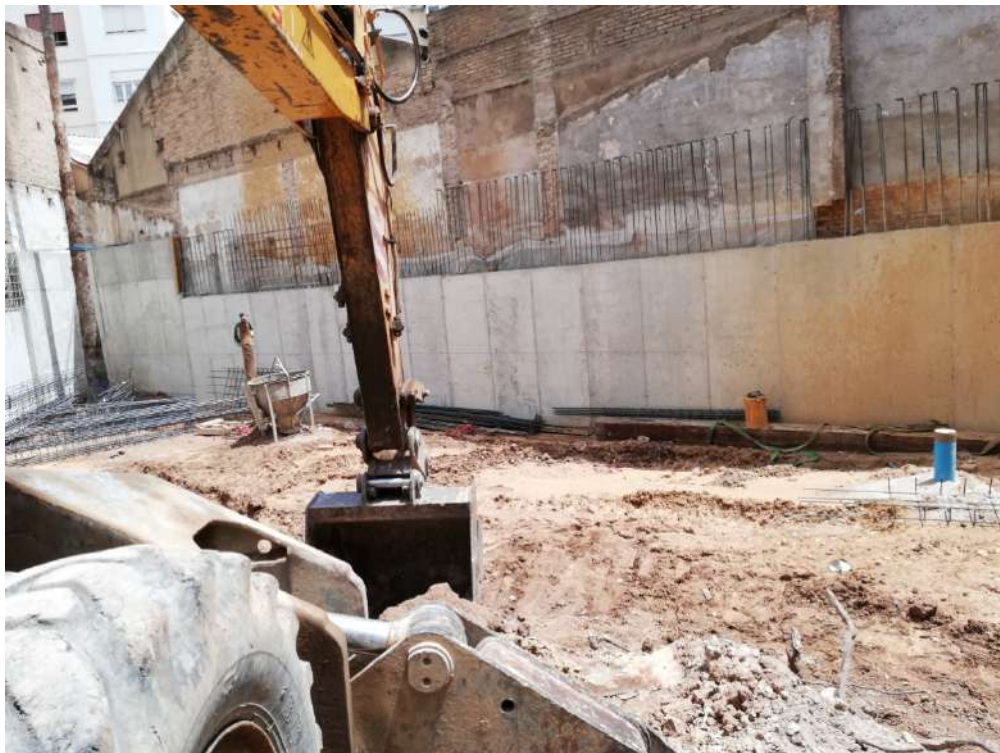
Ilustración 89. Excavación para formación de la rampa de acceso.
