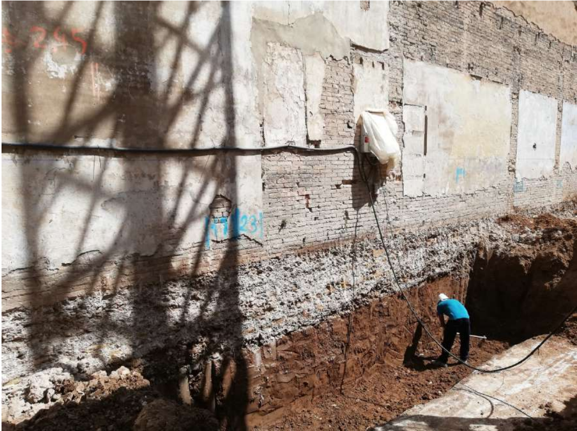
Ilustración 54. Remates de excavación.
