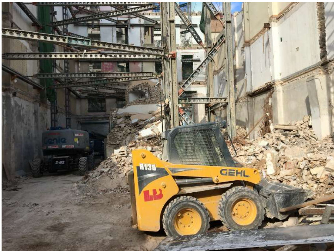
Ilustración 41. Visualización de la obra tras demolición.
