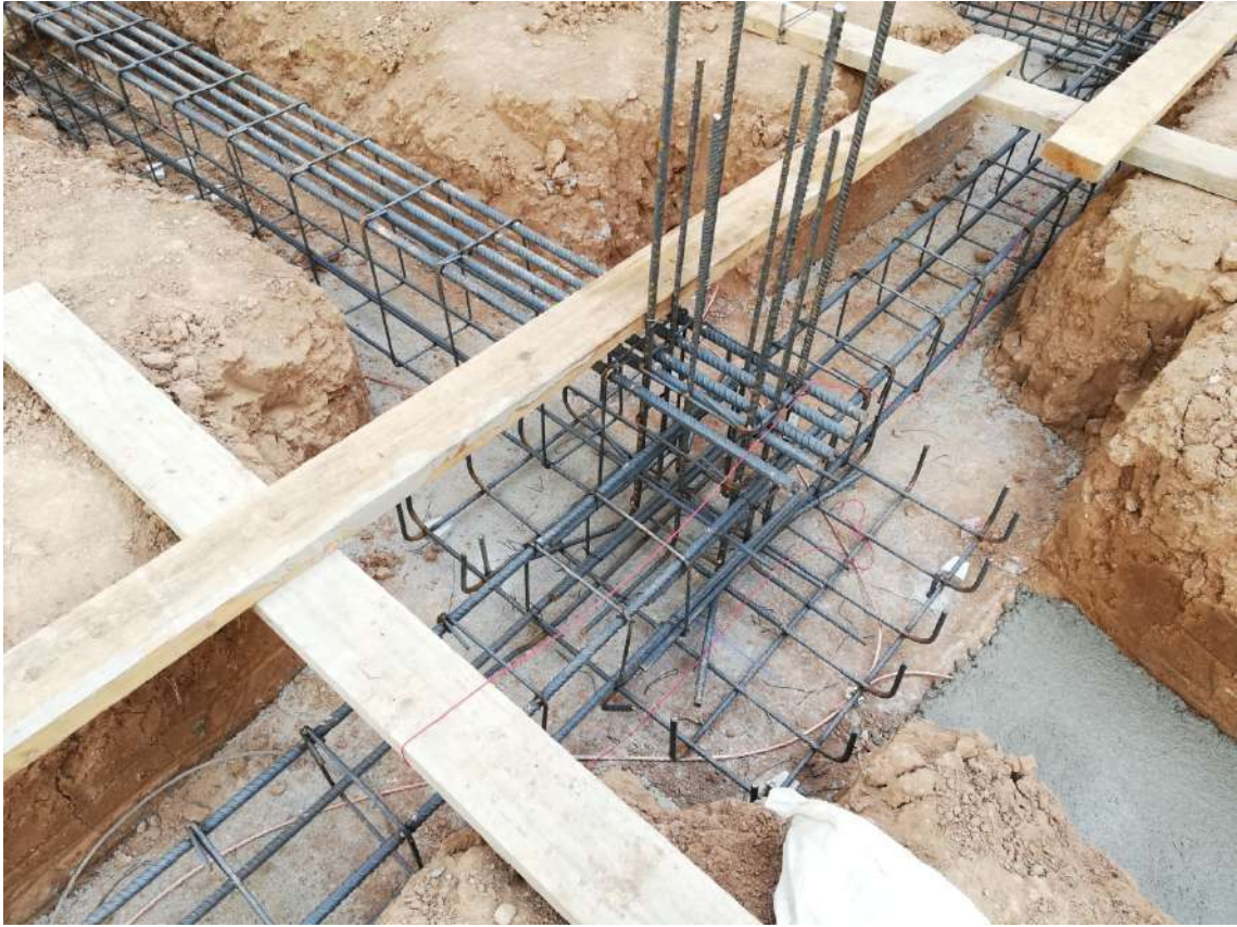
Ilustración 95. Armado de zapata aislada y vigas. Paso de toma de tierra.
