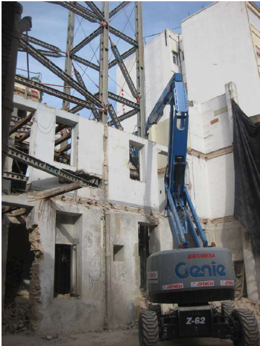
Ilustración 32. Demolición de forjado.
