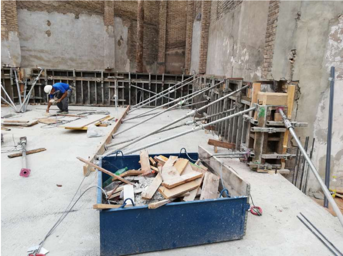
Ilustración 124. Encofrado de murete perimetral medianero con el local comercial.
