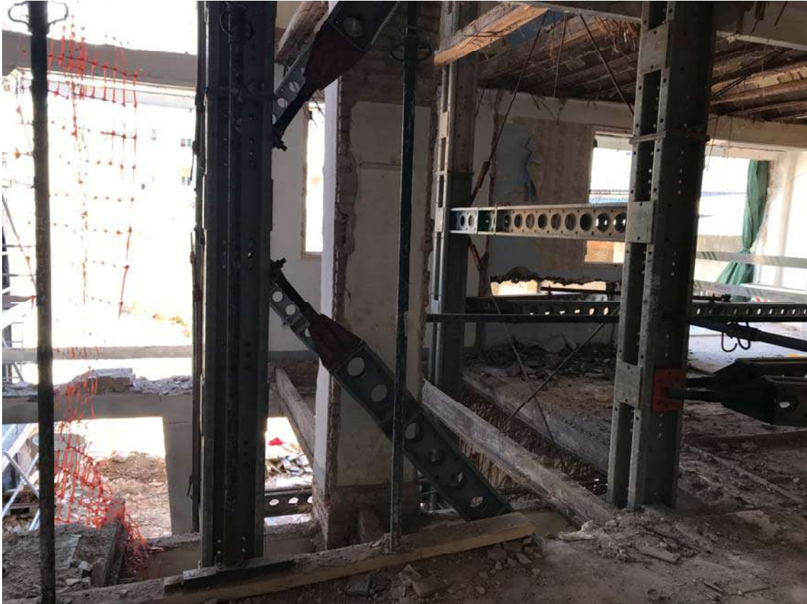
Ilustración 5.2. Trabajos de demolición.
