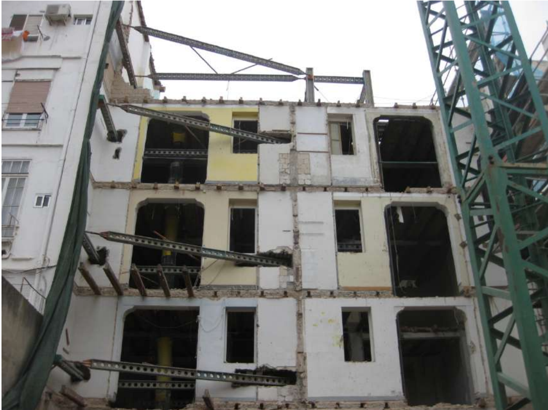
Ilustración 25. Fachada trasera demolida hasta forjado de planta cuarta.
