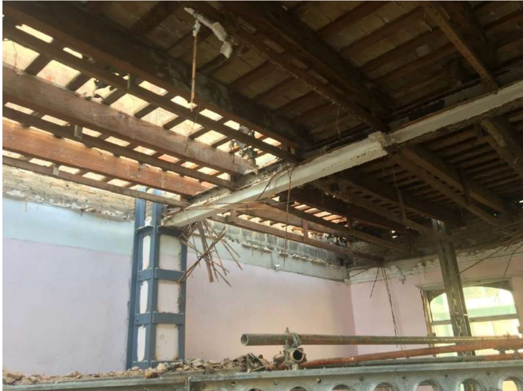
Ilustración 21. Parte de forjado de planta quinta sin demoler.
