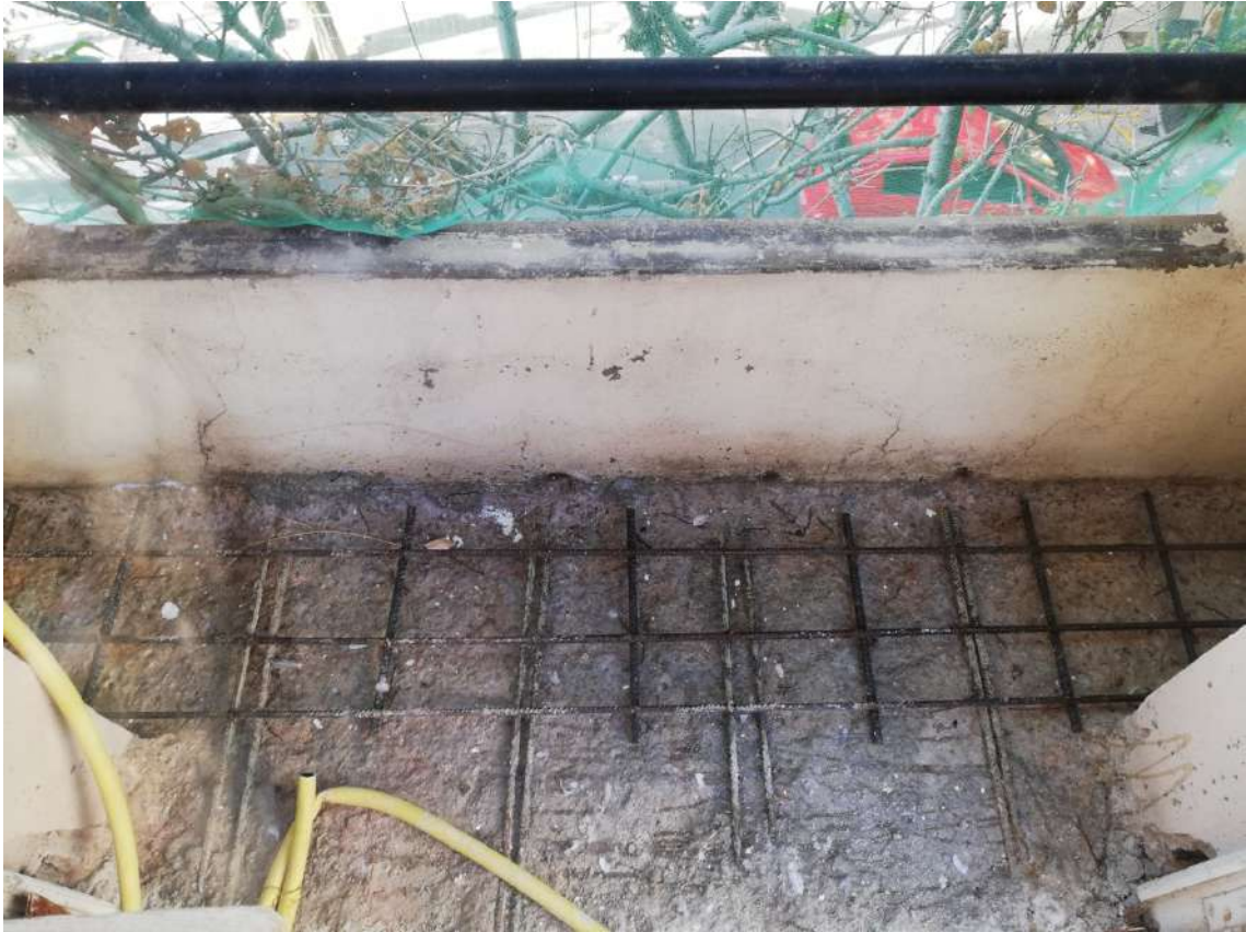
Ilustración 154. Rehabilitación de balcones existentes.
