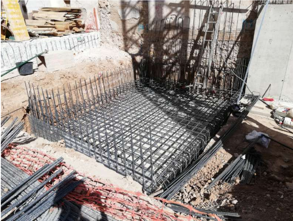
Ilustración 78. Losa de cimentación ya armada y lista para hormigonar.
