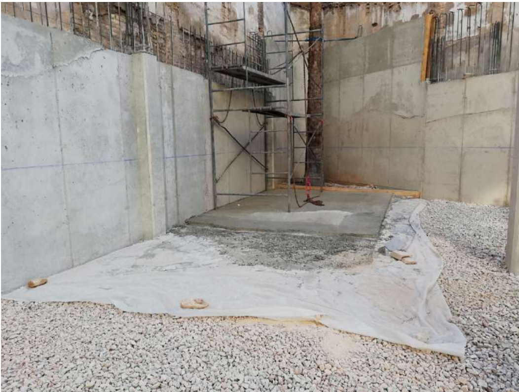
Ilustración 100. Ejecución de solera en zona aparcamiento.
