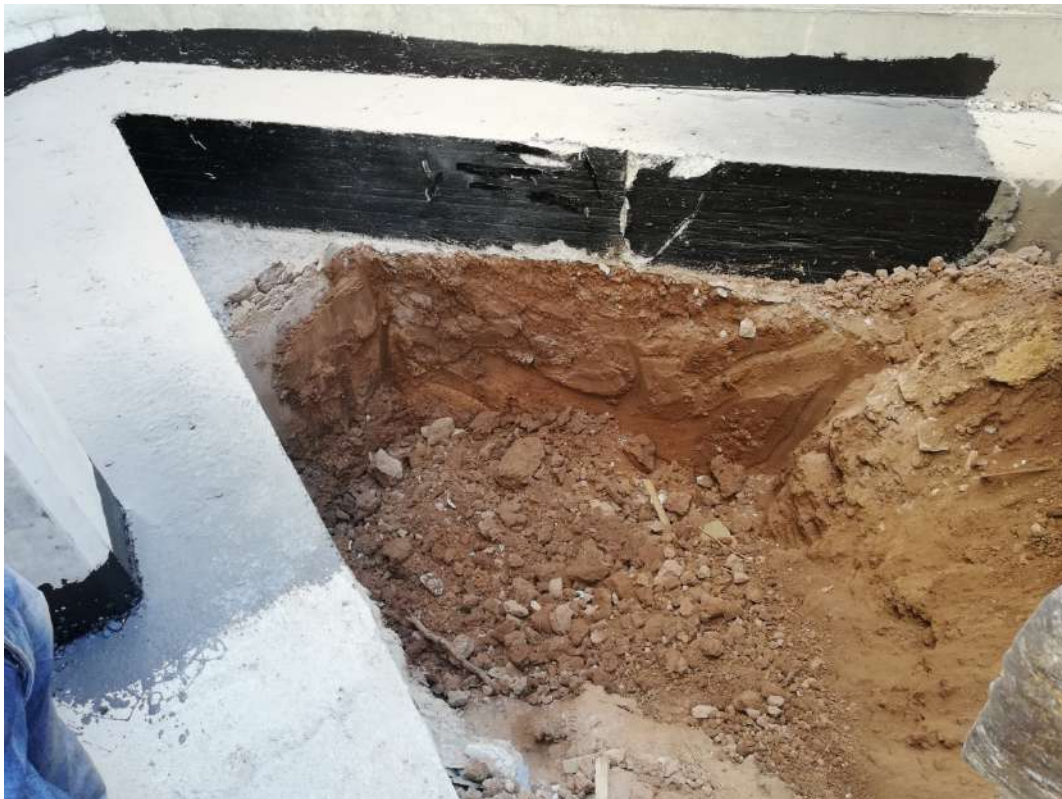
Ilustración 81. Excavación de hueco para posterior plantación de palmera.
