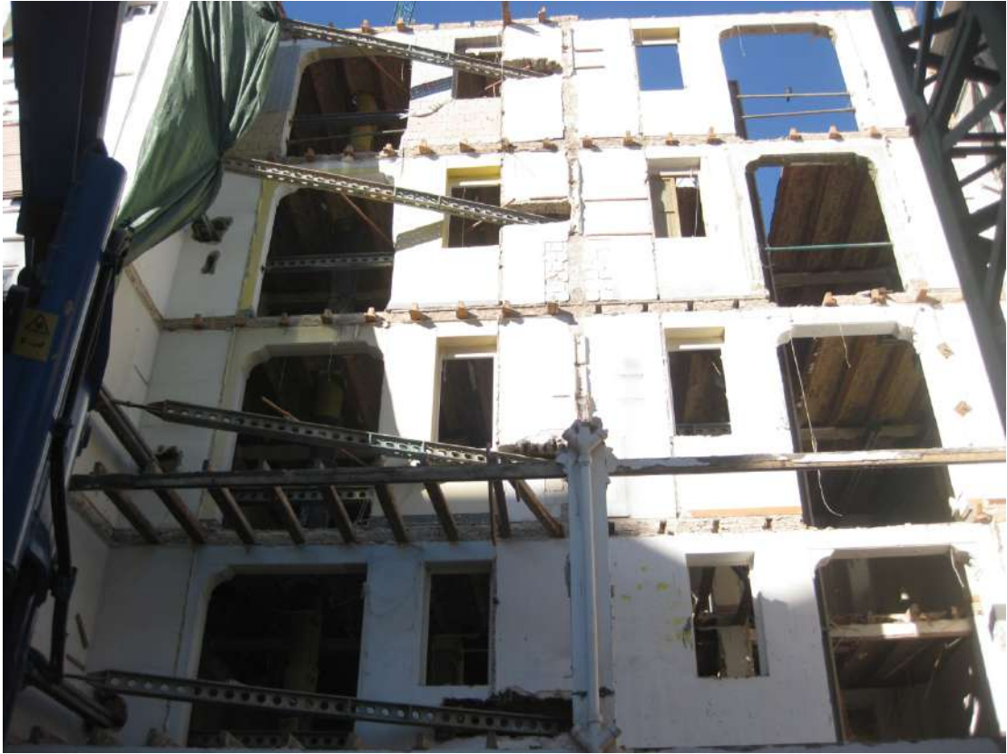
Ilustración 18. Demolición ejecutada en fachada trasera.
