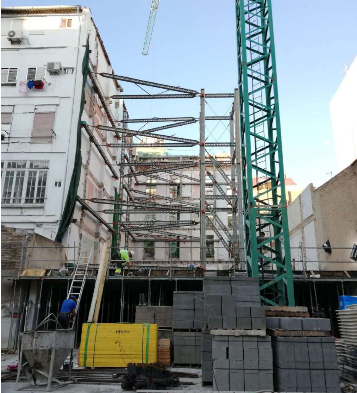
Ilustración 140. Visualización de la obra desde la zona de aparcamiento.
