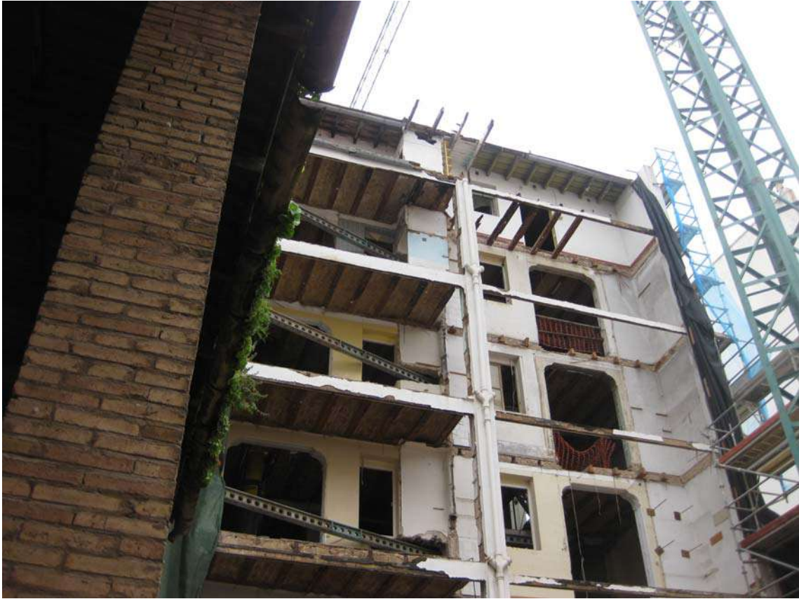
Ilustración 8.1. Trabajos de demolición.
