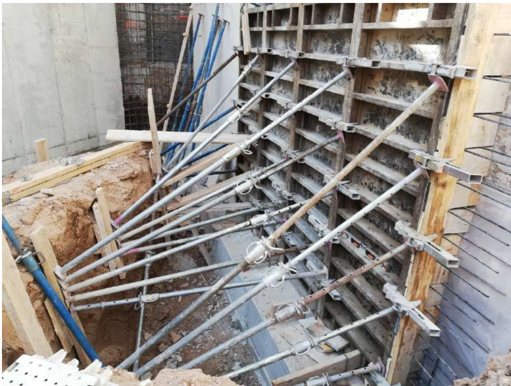
Ilustración 75. Muro perimetral ya hormigonado.
