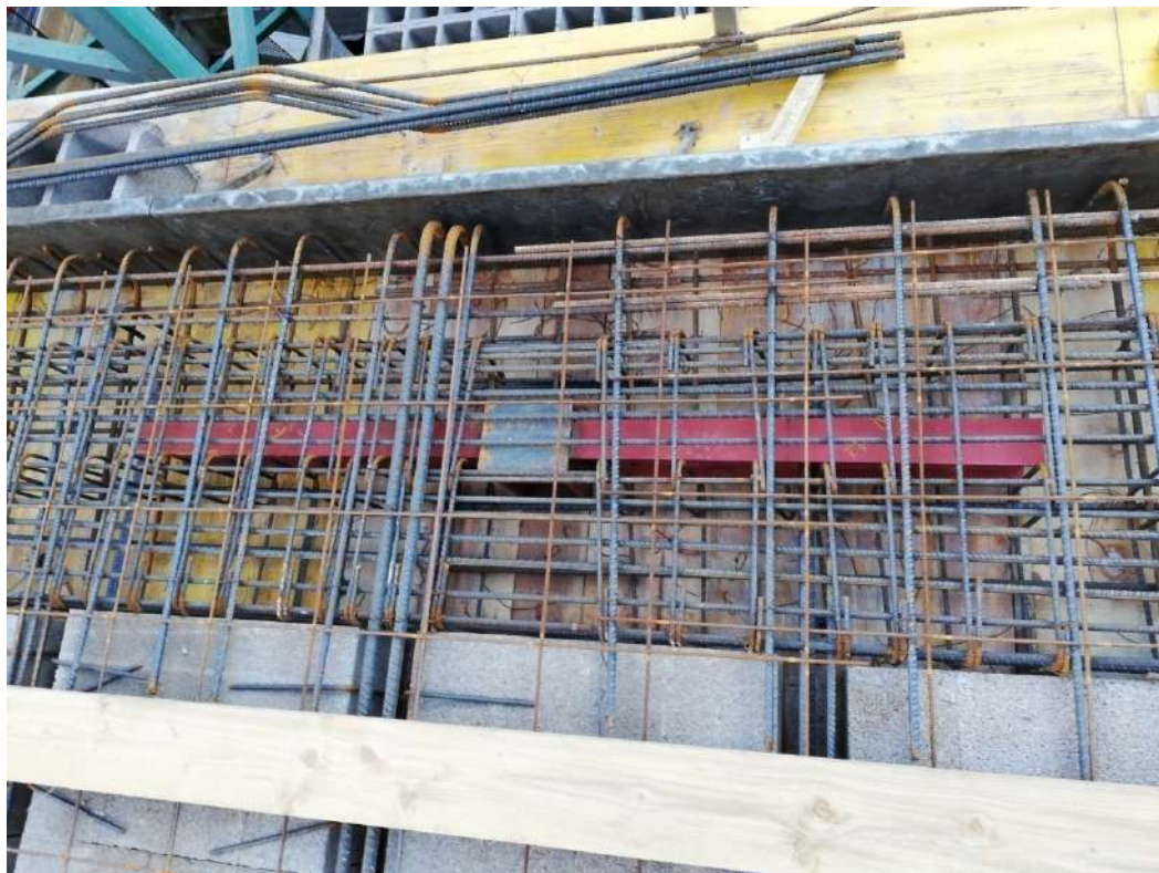
Ilustración 139. Encuentro de pilar metálico con viga.
