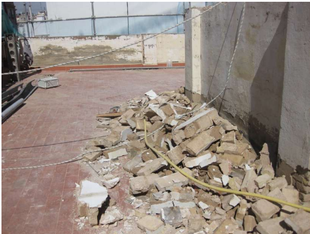
Ilustración 15. Acopio de escombros en el forjado de planta 5ª.
