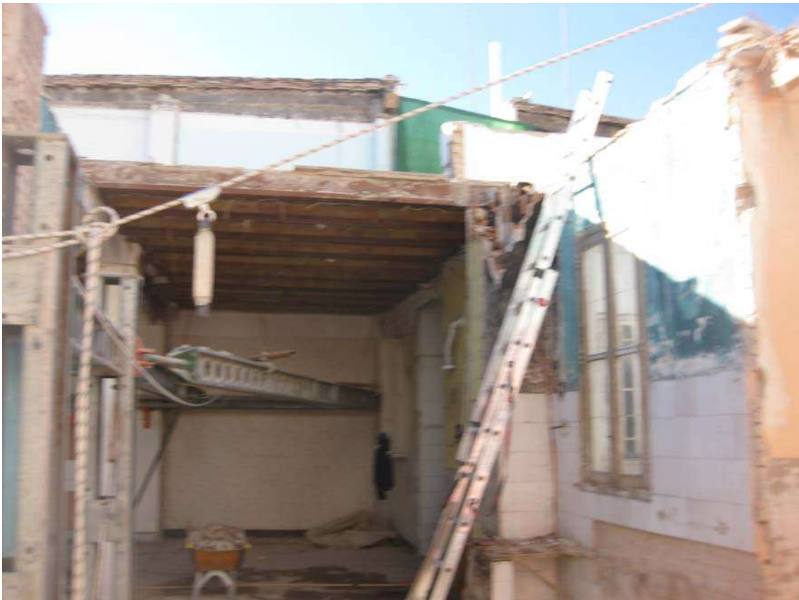
Ilustración 15.1. Demoliciones de cubierta.
