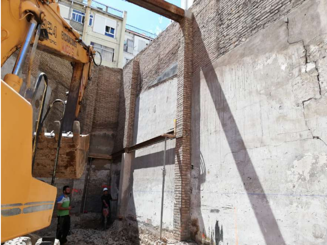
Ilustración 55. Viga metálica arriostrando pilares medianeros con local comercial.
