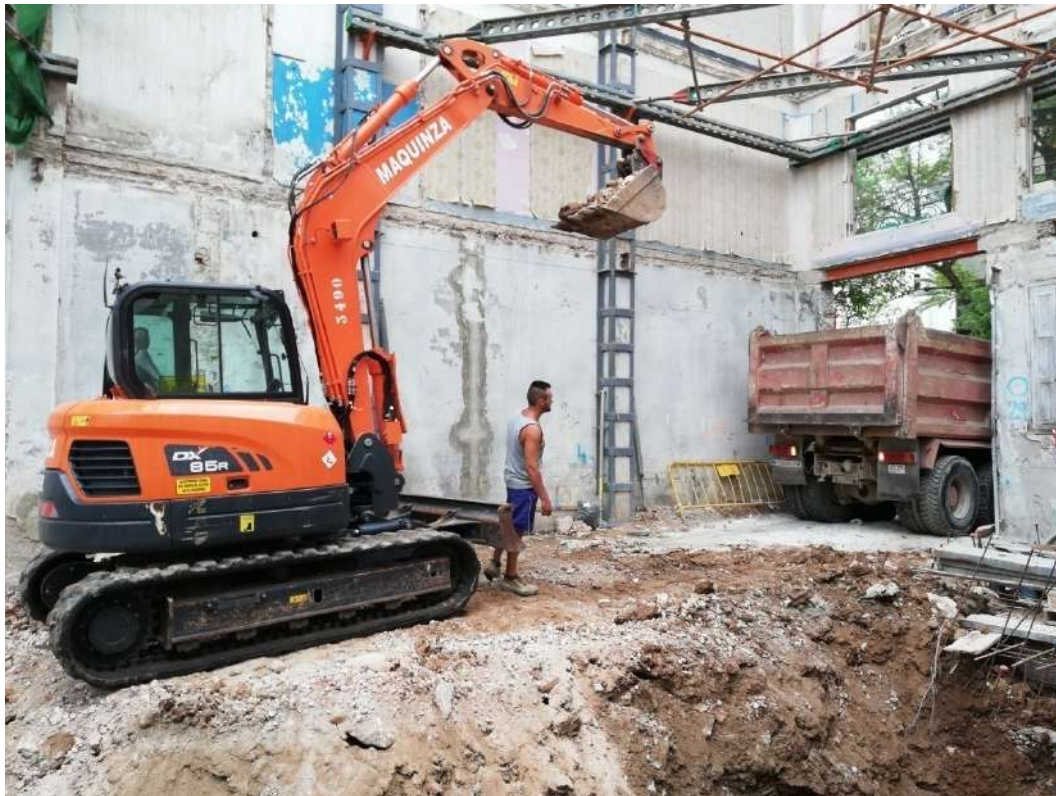
Ilustración 122. Excavadora y camión volquete accediendo a la obra.
