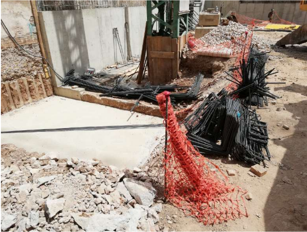
Ilustración 66. Armado de losa de cimentación acopiado.
