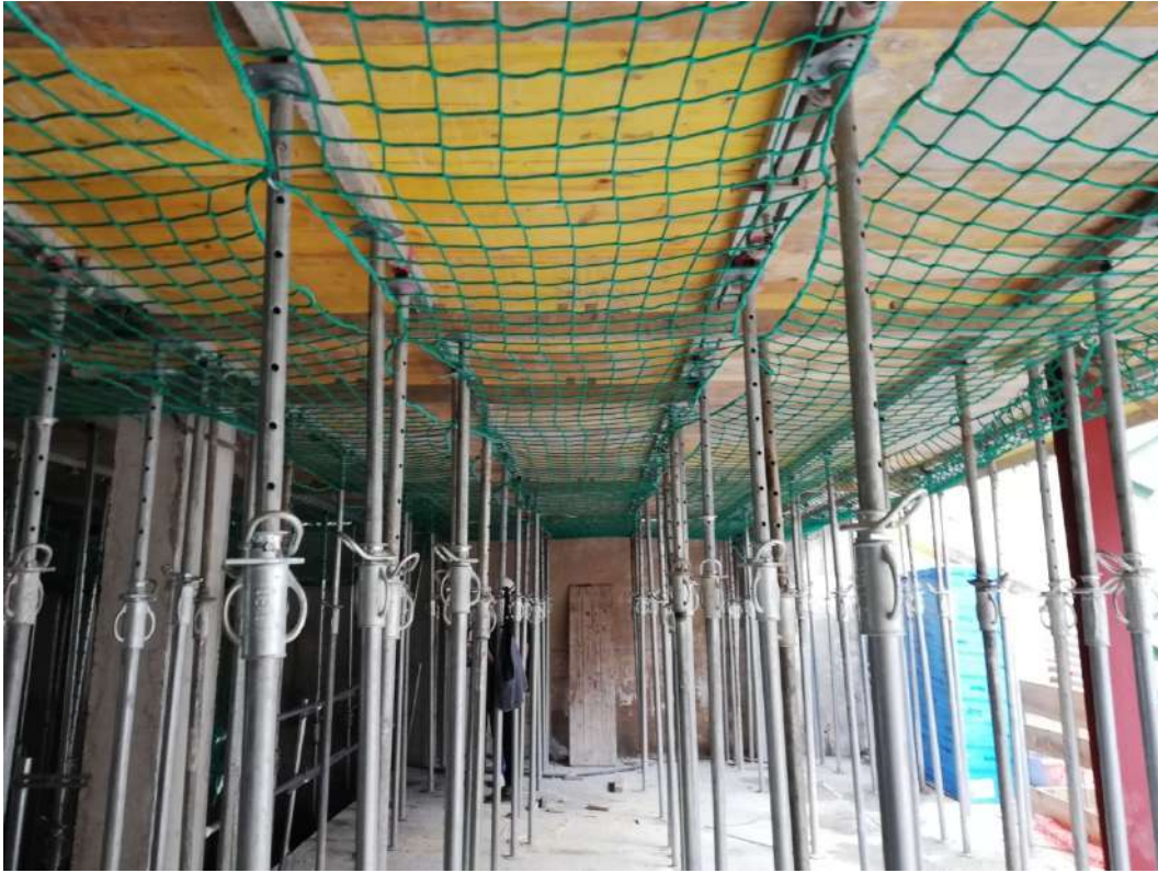
Ilustración 134. Encofrado de forjado de planta primera.
