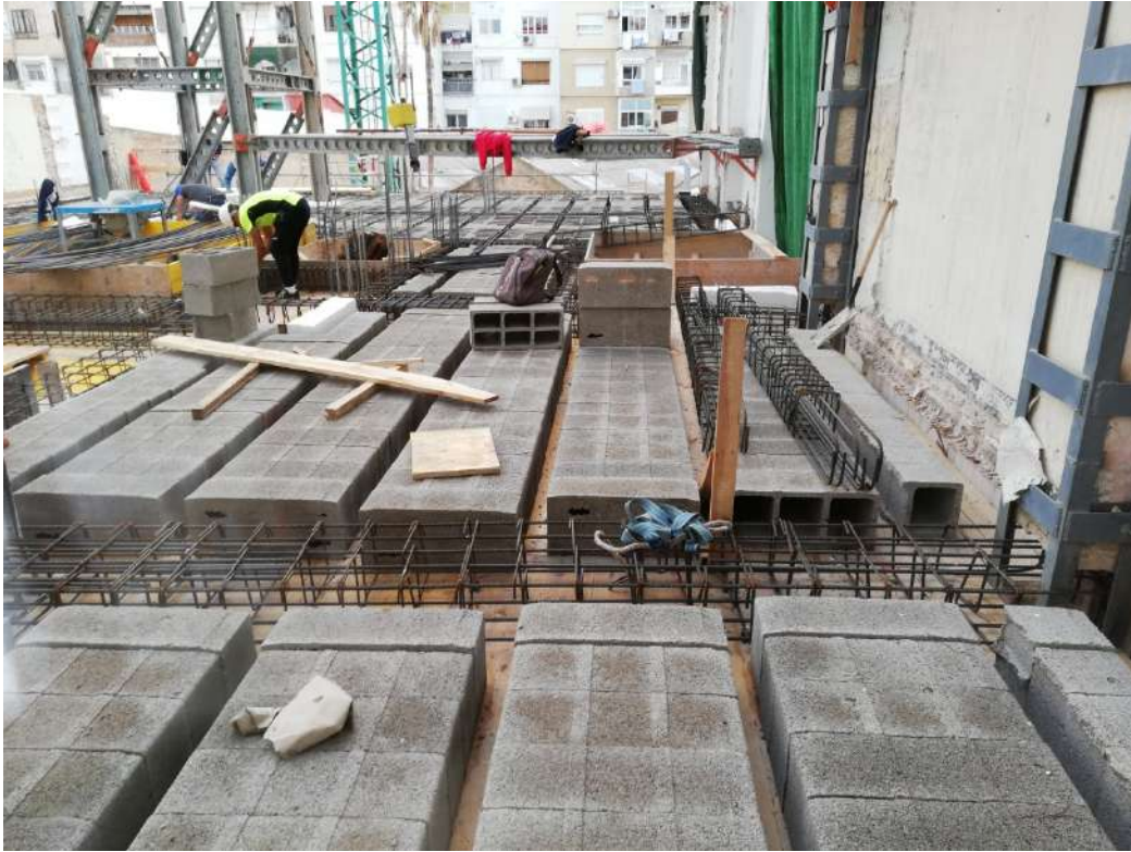
Ilustración 148. Montaje de forjado de planta segunda.
