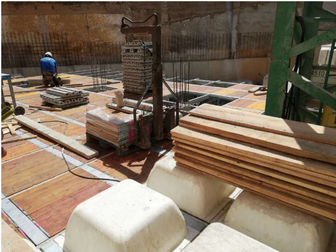
Ilustración 113. Montaje de encofrado de forjado reticular.
