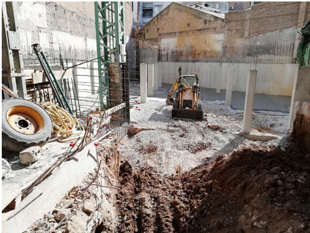
Ilustración 104. Excavación hueco losa cota a -1,70 metros.
