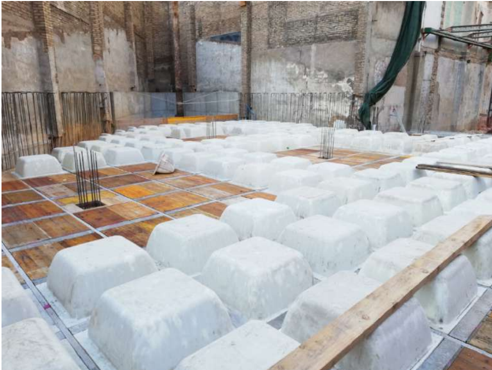
Ilustración 117. Encofrado para forjado reticulado.
