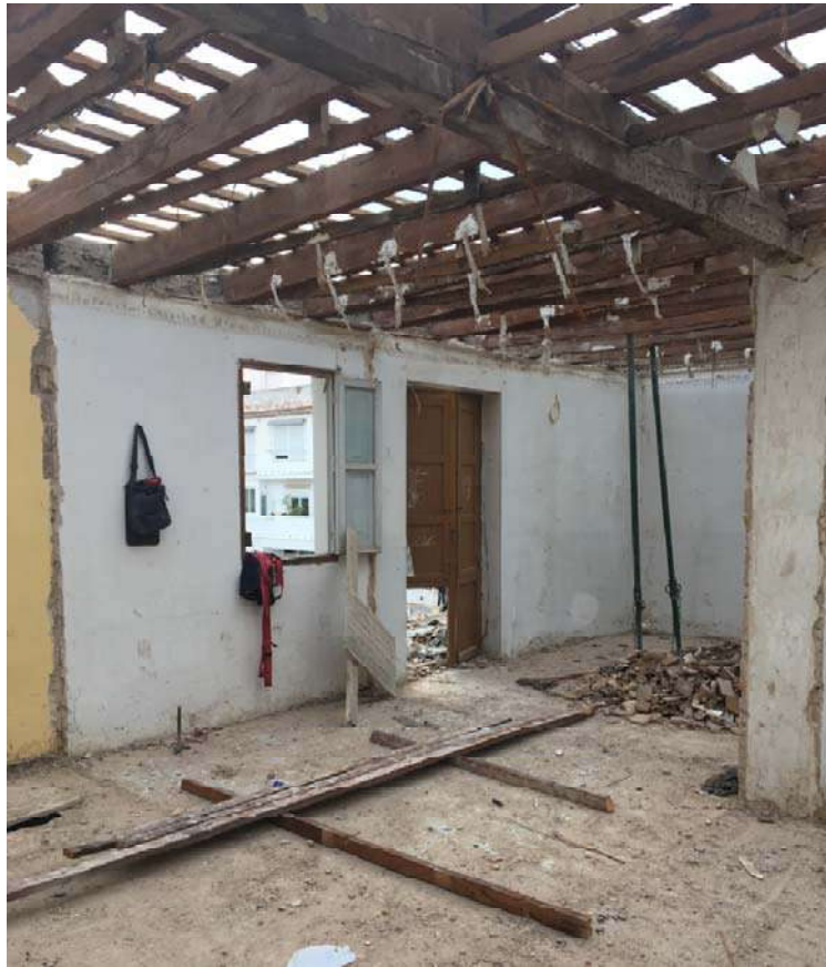
Ilustración 10. Demolición de cubierta.
