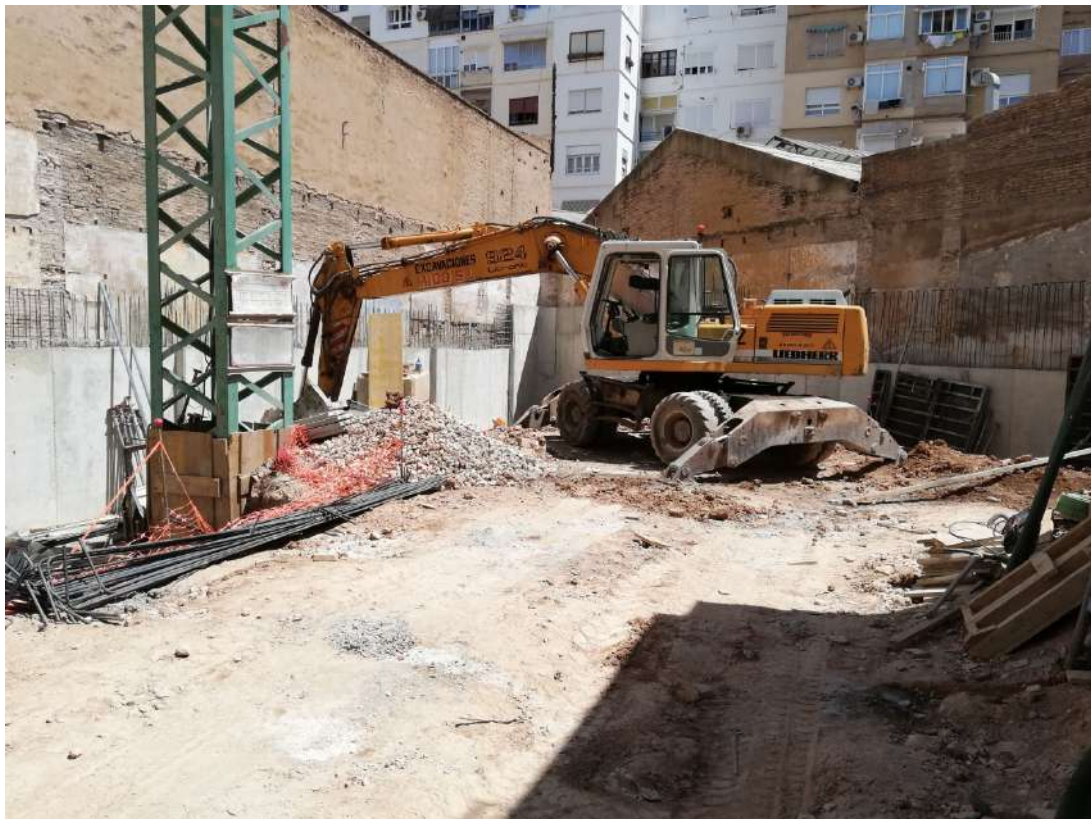
Ilustración 73. Rebaje de cota de excavación.
