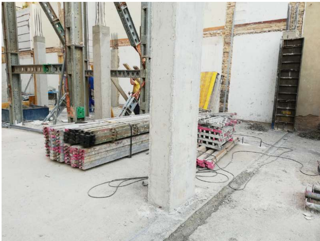
Ilustración 145. Pilares de planta primera ya desencofrados.
