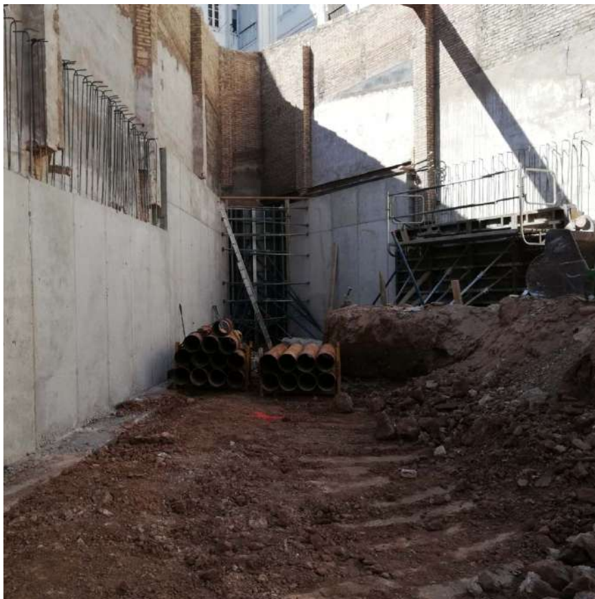
Ilustración 79. Encofrado de muro curvo y replanteo de pozo de extracción de geotermia.
