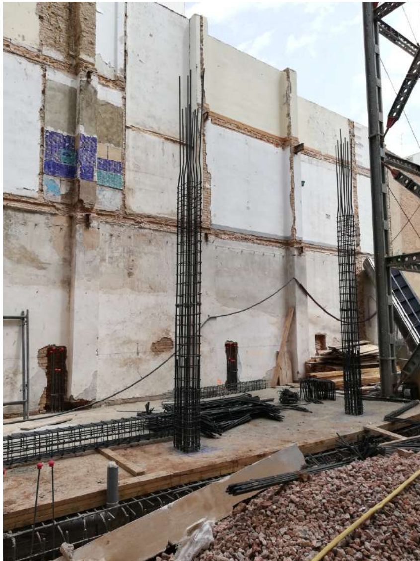
Ilustración 96. Armaduras de pilares sobre losa de cimentación.
