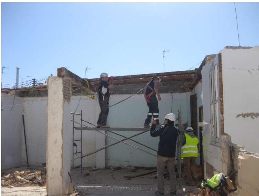
Ilustración 13. Operarios desmontando viguetas de la cubierta.
