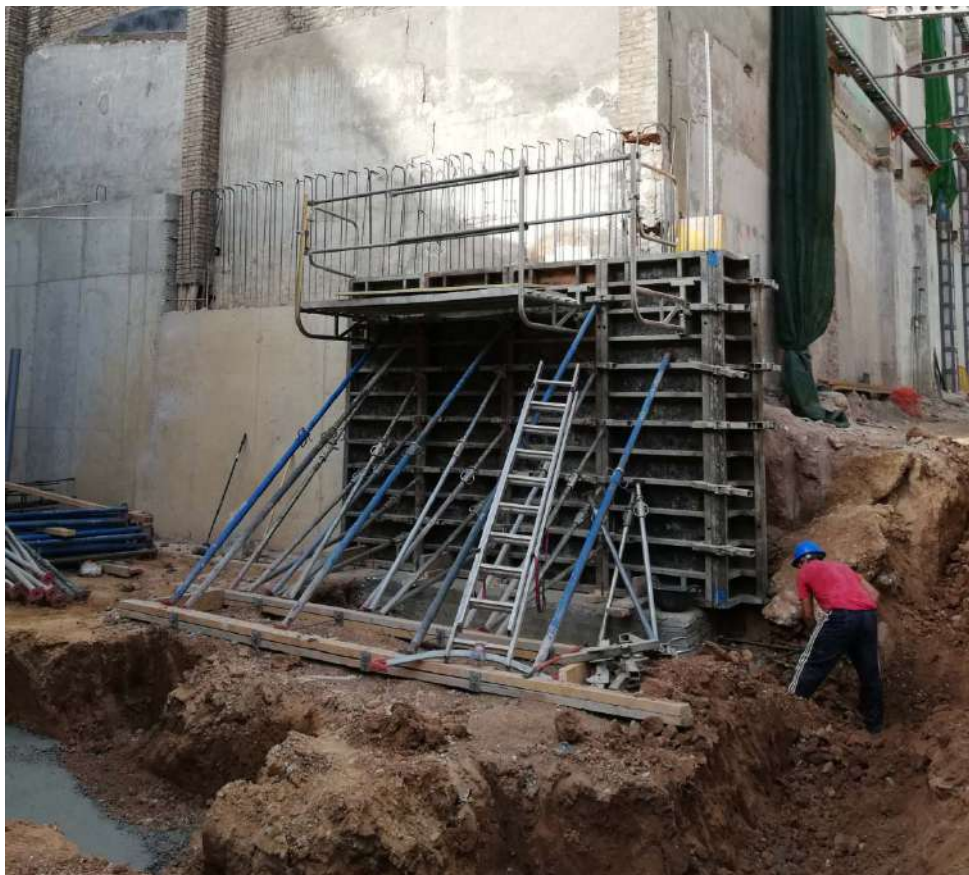
Ilustración 94. Último tramo de muro ya hormigonado.
