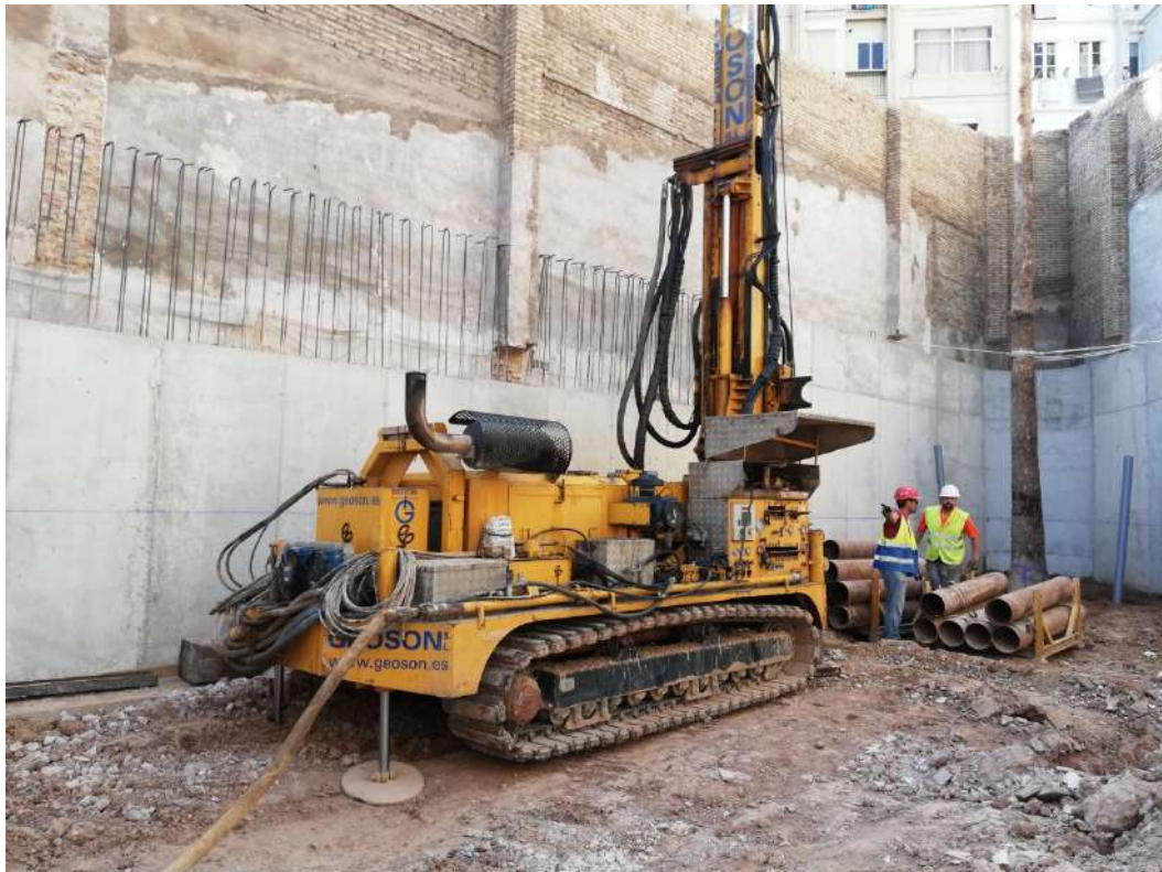
Ilustración 86. Preparación de la maquinaria para la ejecución del pozo de extracción.
