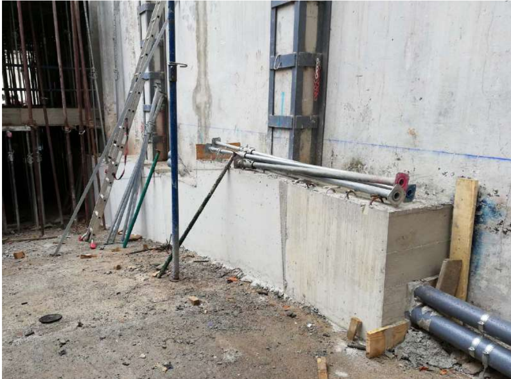
Ilustración 136. Muro medianero con edificio anexo ya hormigonado.
