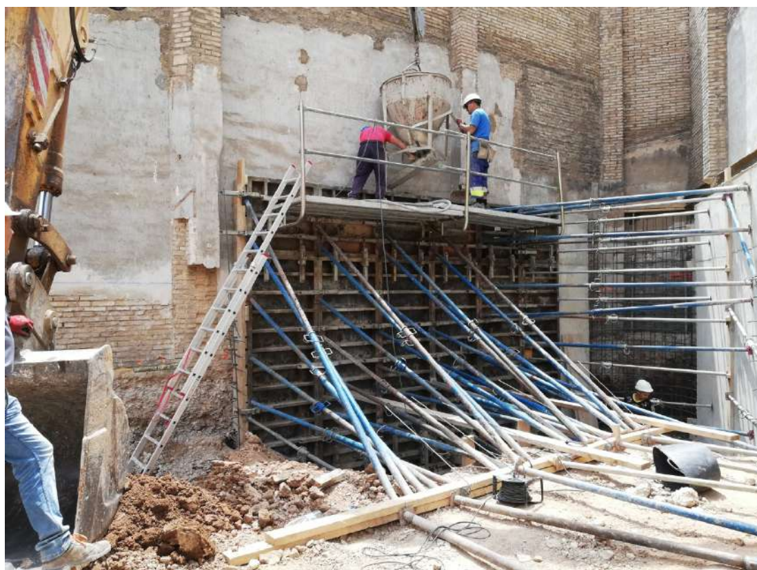
Ilustración 69. Hormigonado de muro perimetral.
