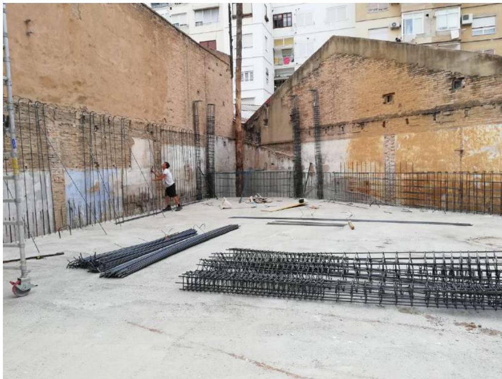
Ilustración 123. Colocación de armaduras de muro perimetral medianero con el cine.
