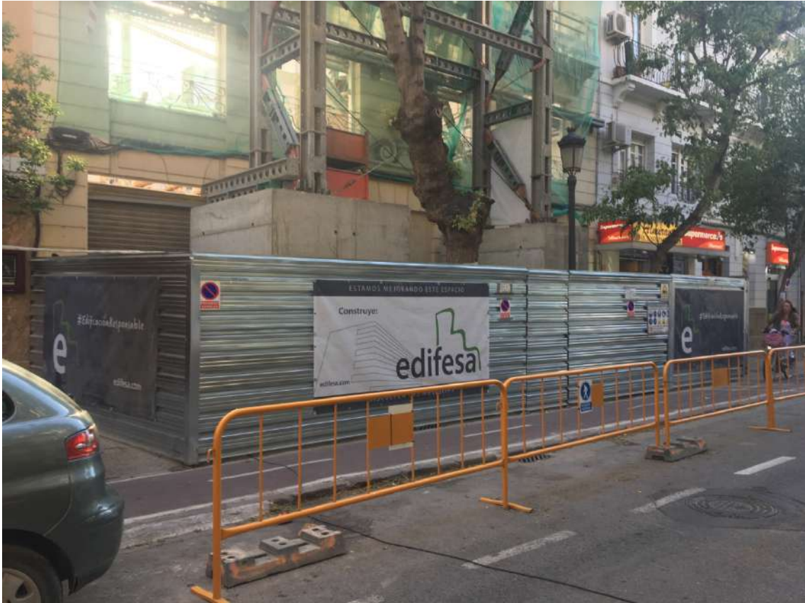
Ilustración 36. Vallado de obra de chapa grecada.
