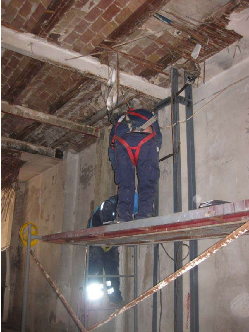
Ilustración 5. Operarios empresillando un pilar en medianera.
