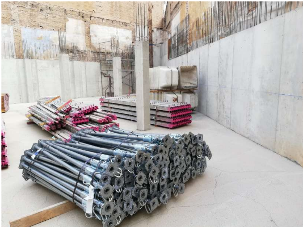
Ilustración 109. Acopio de material para encofrado de forjado.
