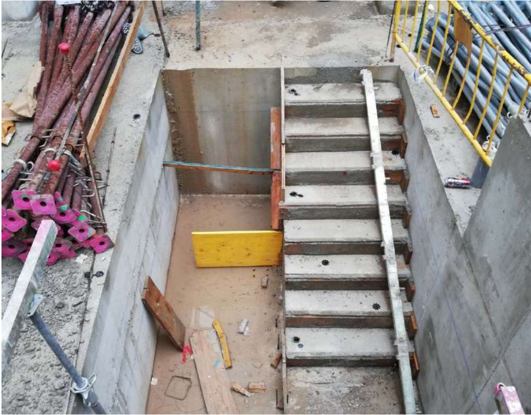
Ilustración 132. Escalera de acceso al sótano ya hormigonada.
