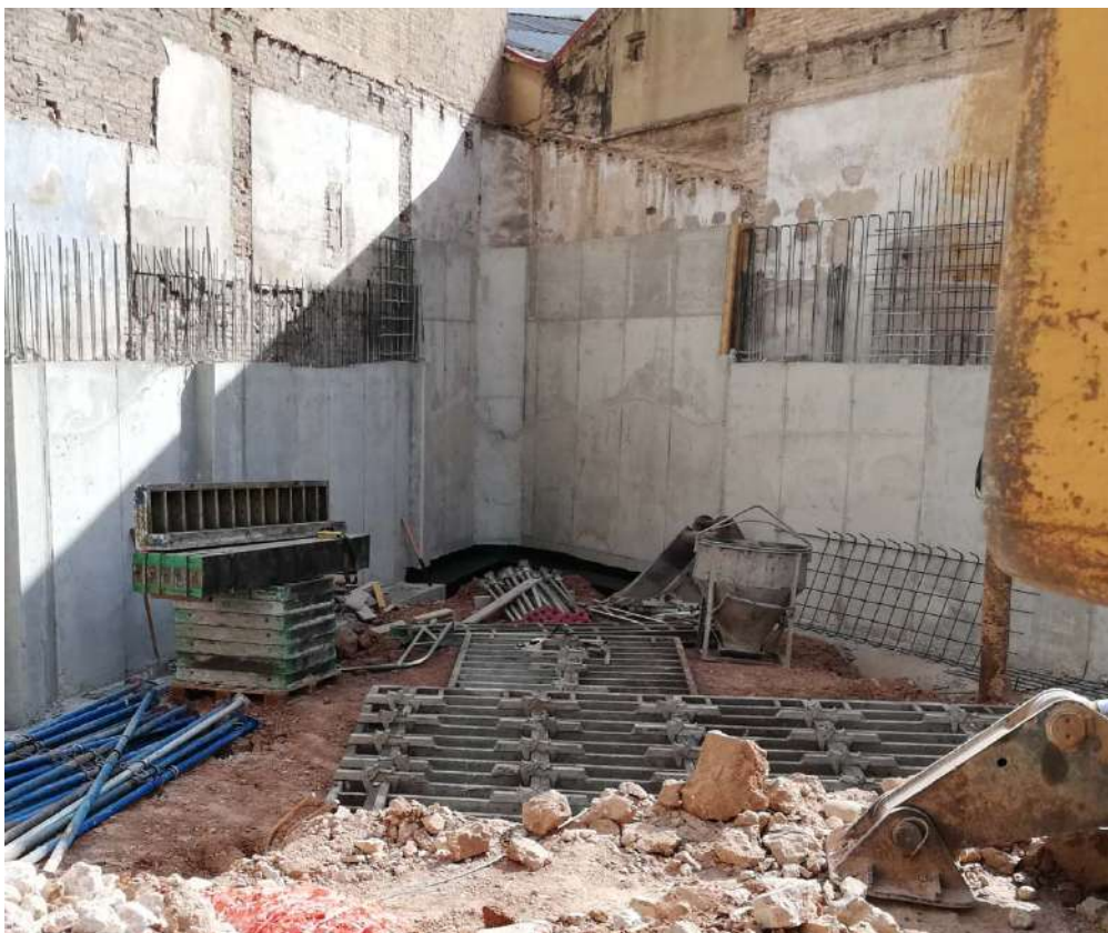
Ilustración 77. Pintado de zapata corrida de encuentro entre muros perimetrales.
