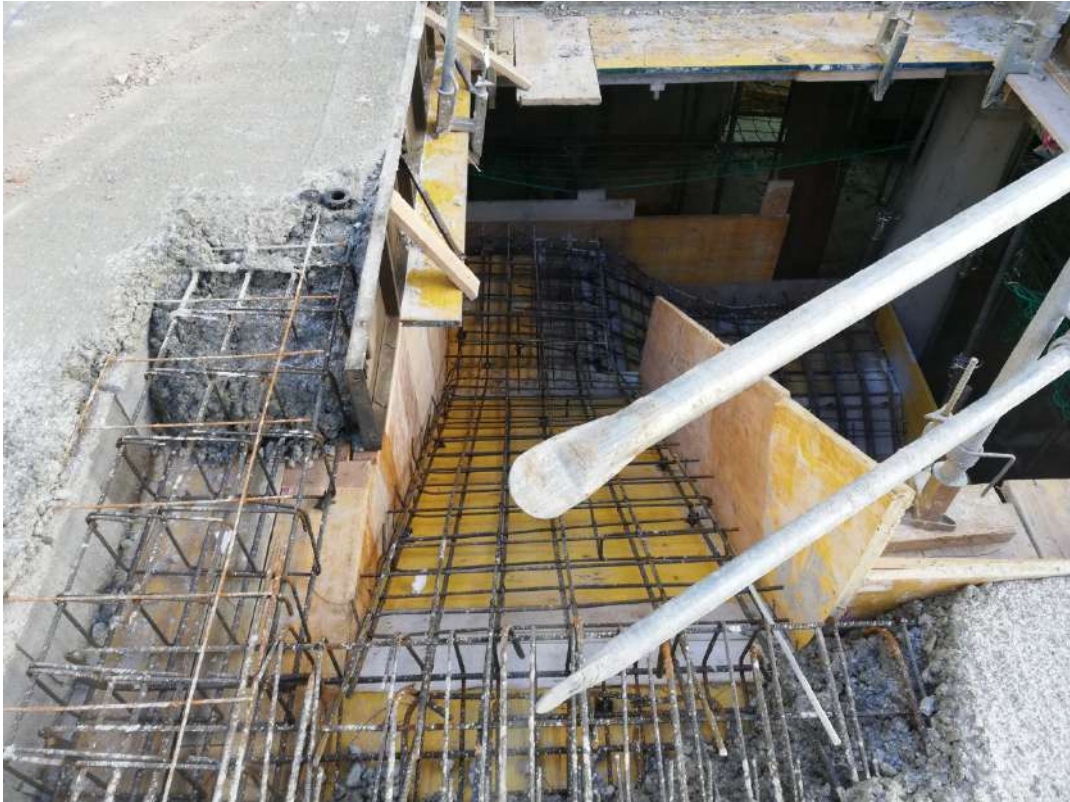
Ilustración 159. Armado de la escalera de acceso a forjado de planta tercera.
