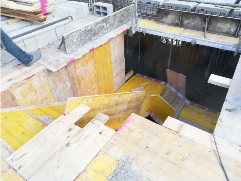
Ilustración 146. Encofrado de tramo de escalera de acceso a planta segunda.
