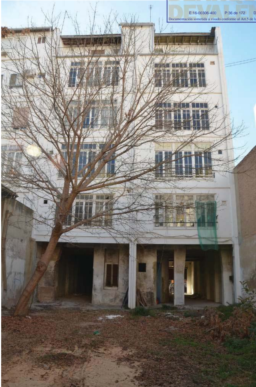
Fachada recayente al patio de manzana
