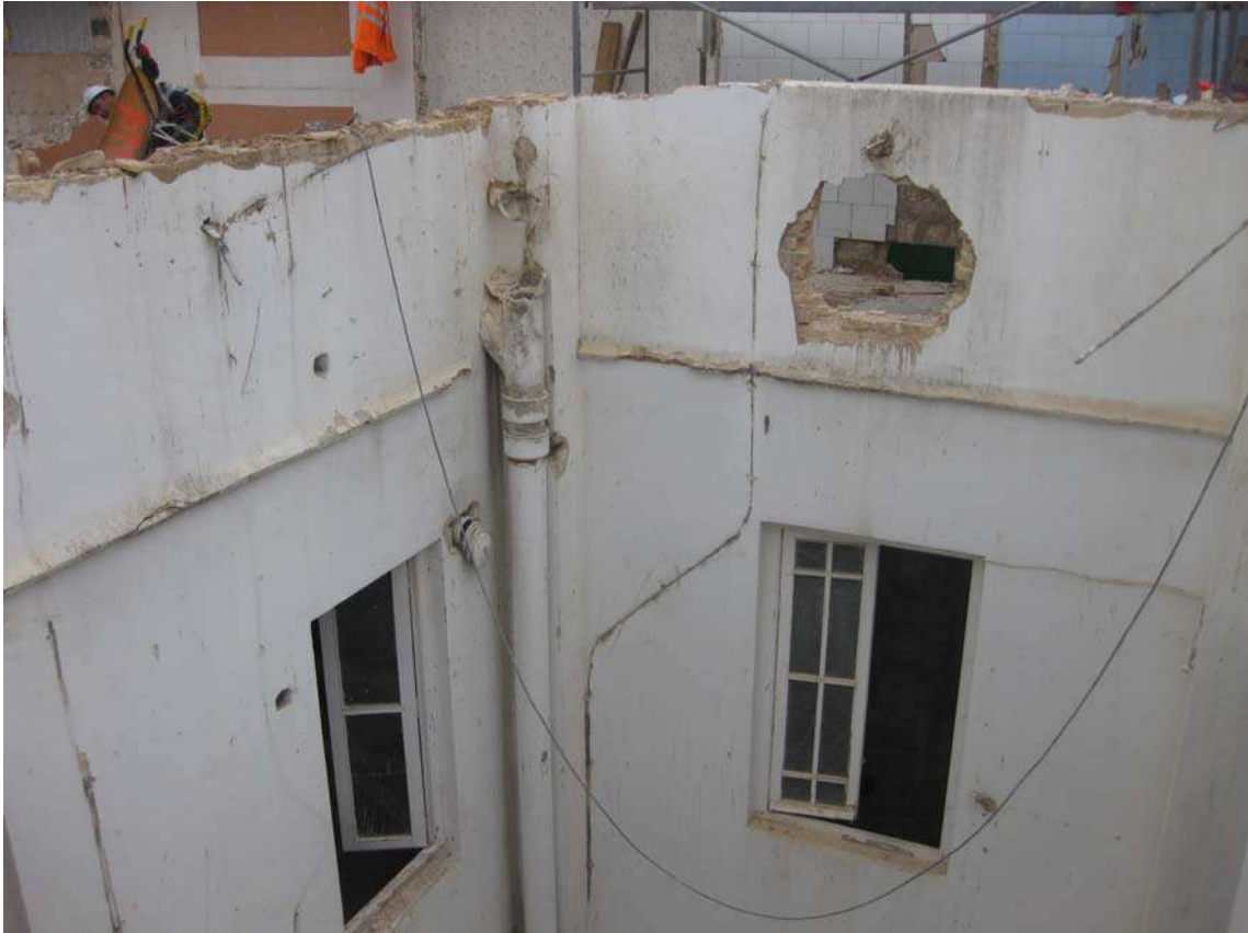
Ilustración 24.1. Demoliciones hueco patio interior.
