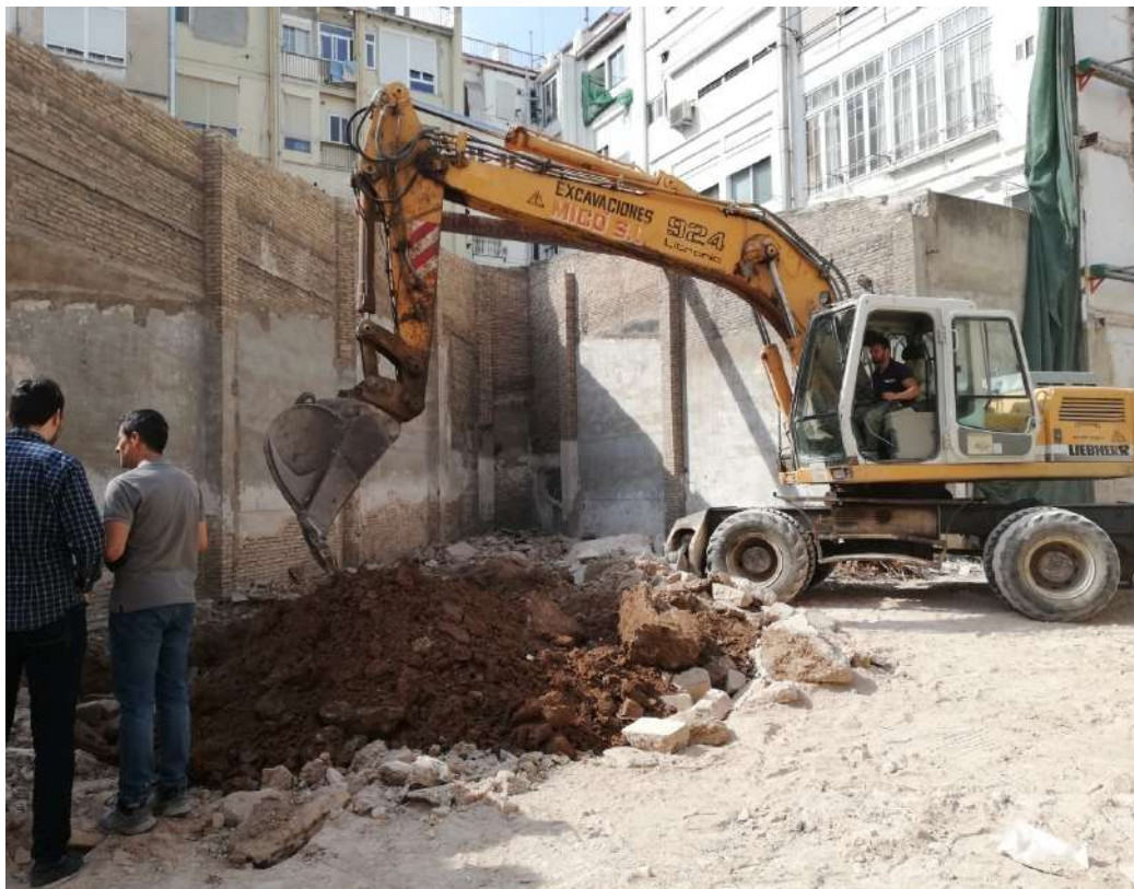
Ilustración 47. Cata para visualización de cota de cimentación del muro existente.
