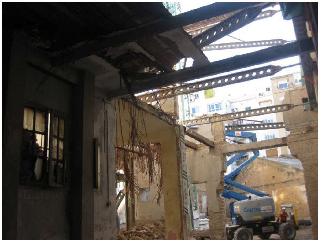
Ilustración 35. Parte de forjado de planta primera demolido.
