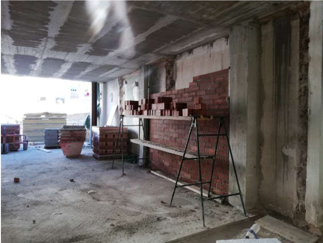
Ilustración 174. Trabajos de albañilería en planta primera.
