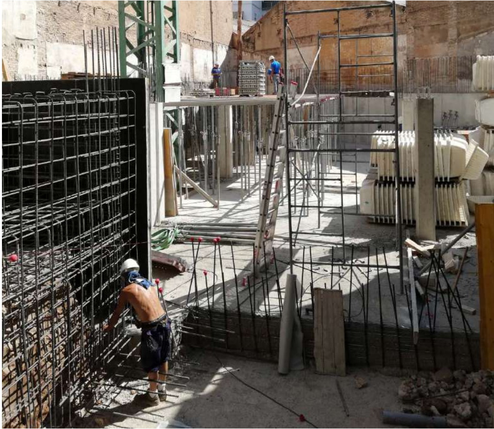
Ilustración 110. Colocación de armaduras de muro.
