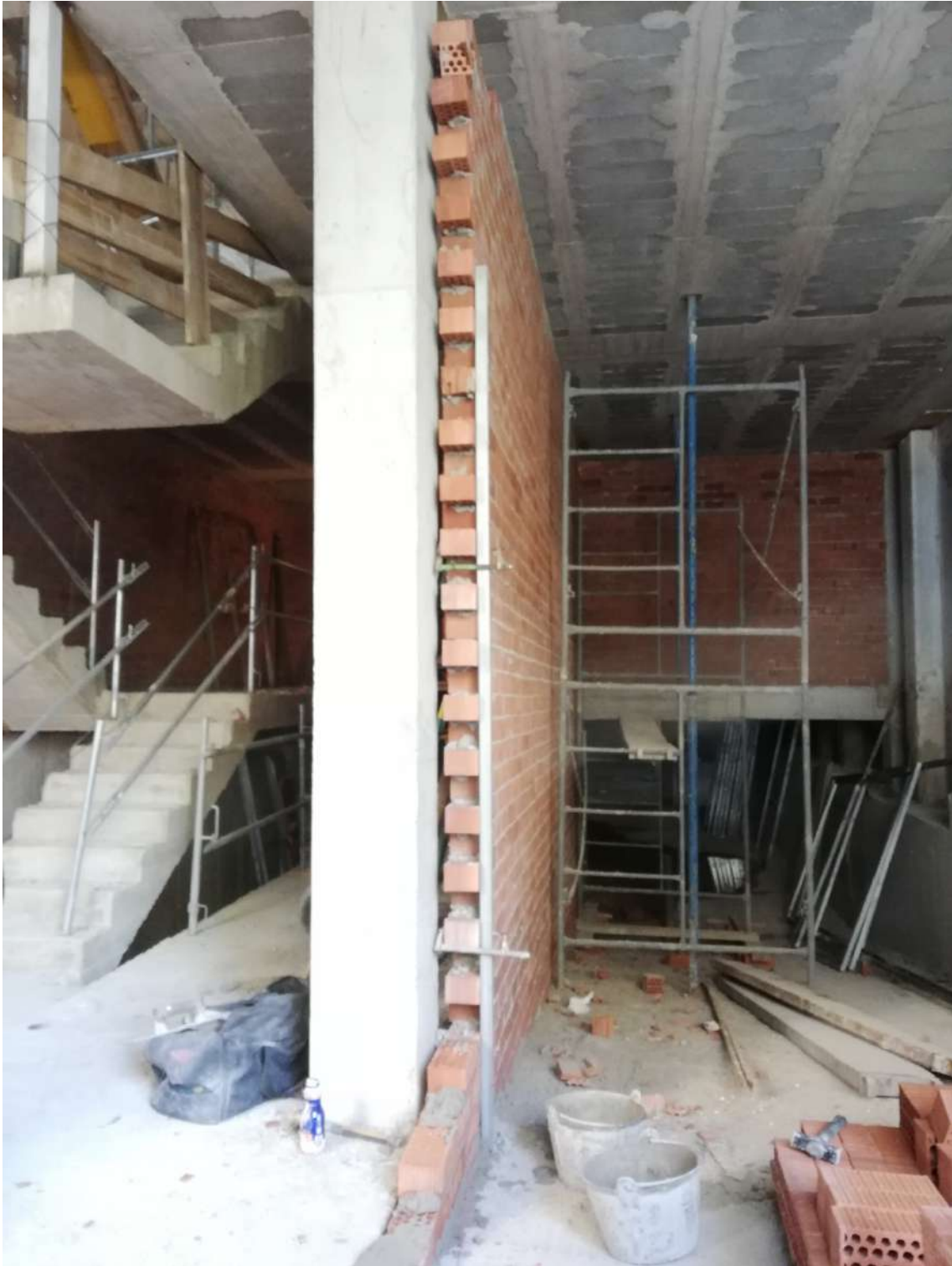
Ilustración 168. Formación de tabiques de fábrica de ladrillo en planta baja.
