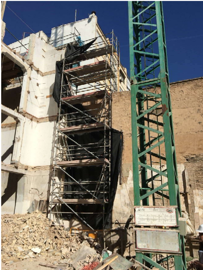
Ilustración 31.1. Andamio para acceso a las plantas.
