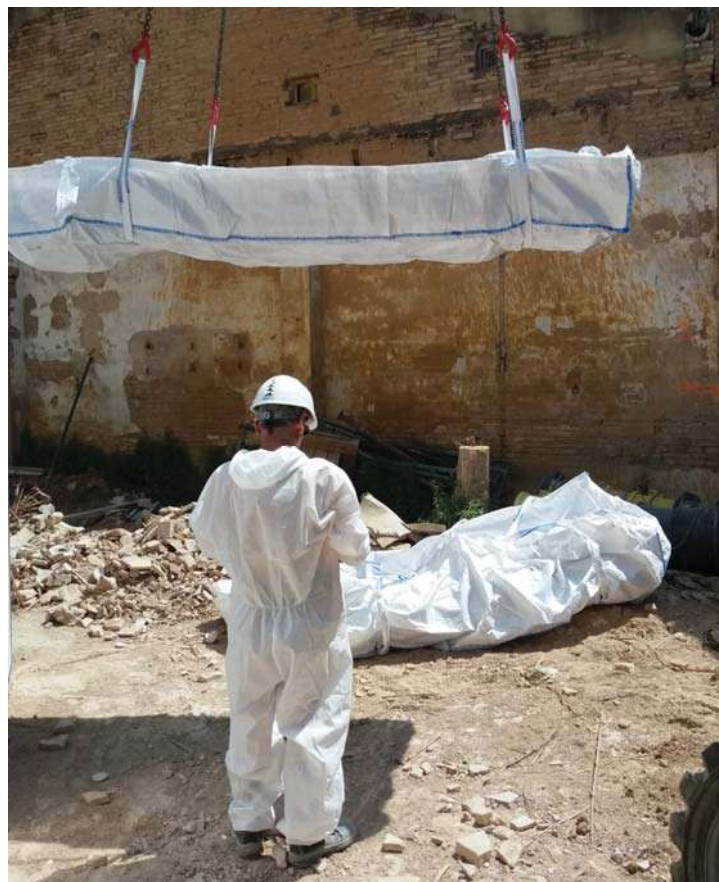
Ilustración 45. Retirada de material con amianto.
