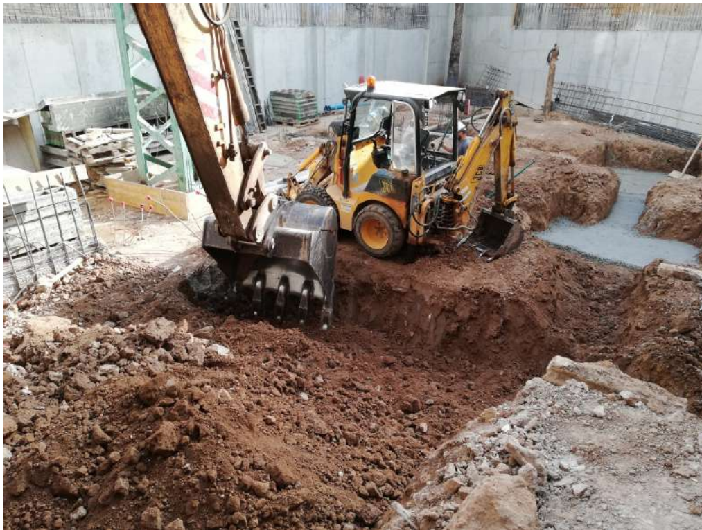
Ilustración 93. Excavación de zanjas para vigas y zapatas aisladas.
