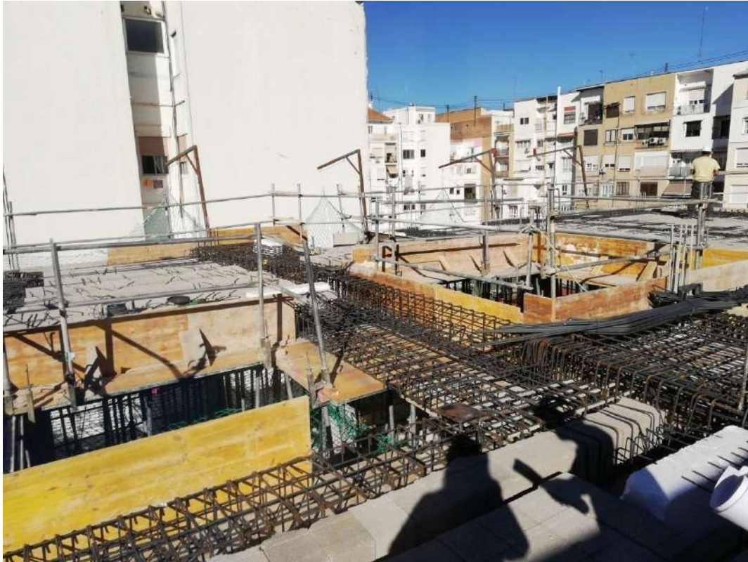
Ilustración 172. Montaje de armaduras de forjado de planta quinta.
