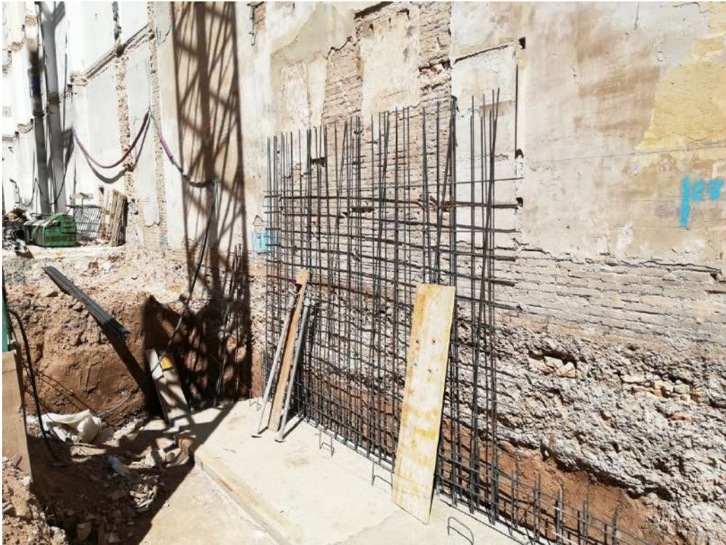
Ilustración 60. Tramo de muro perimetral junto a grúa torre.
