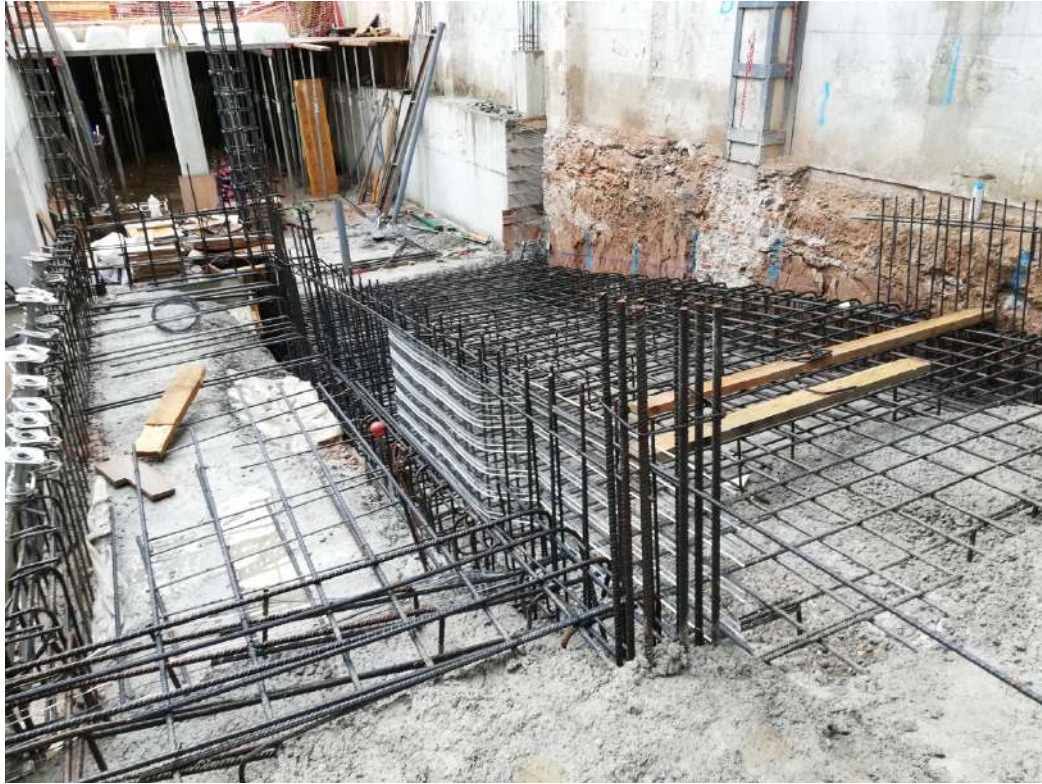
Ilustración 125. Armado de la rampa de acceso al aparcamiento.
