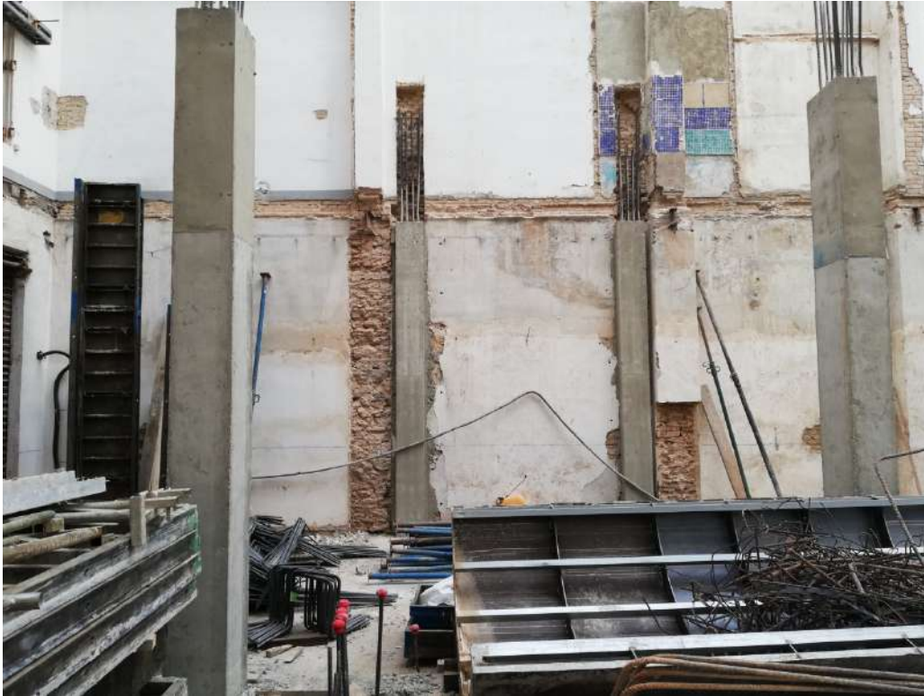
Ilustración 106. Pilares medianeros con el cine ya desencofrados.
