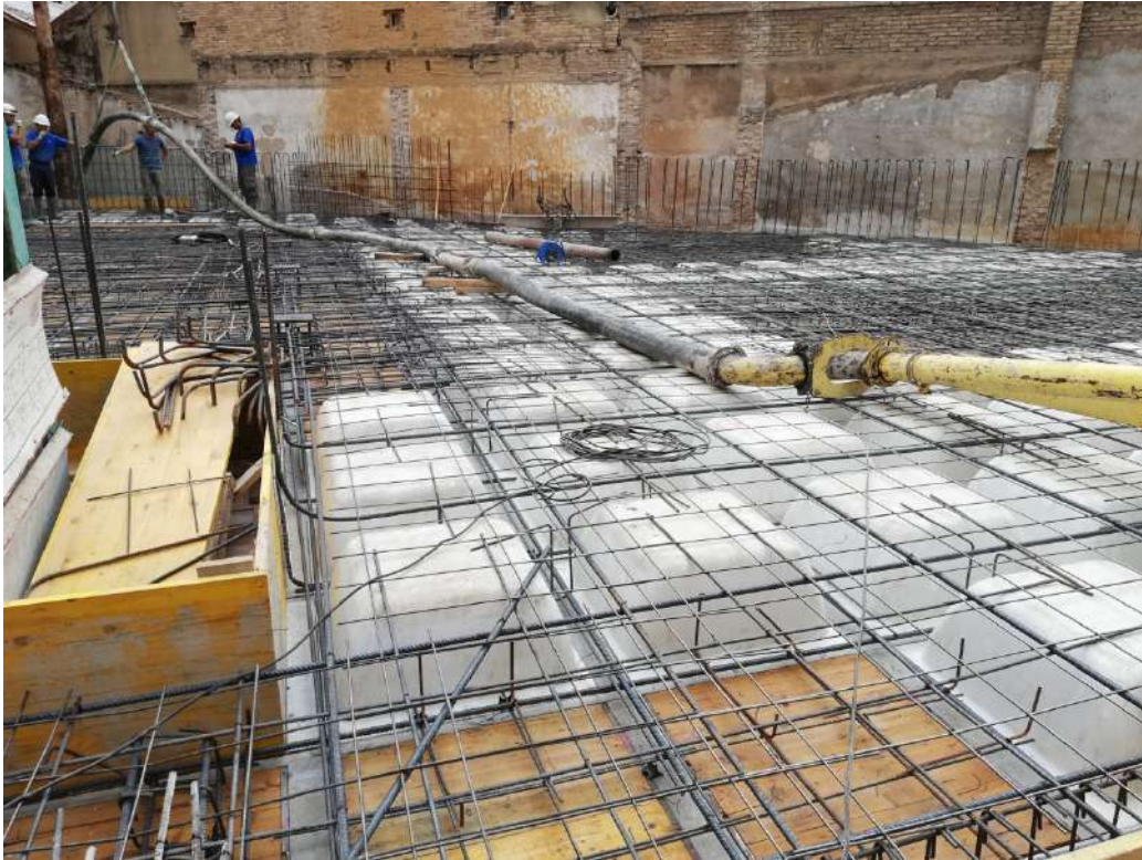
Ilustración 120. Colocación de tubería para hormigonado por bombeo.
