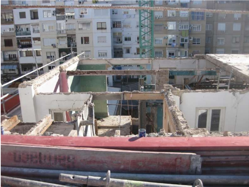
Ilustración 16. Parte del forjado de planta quinta demolido.
