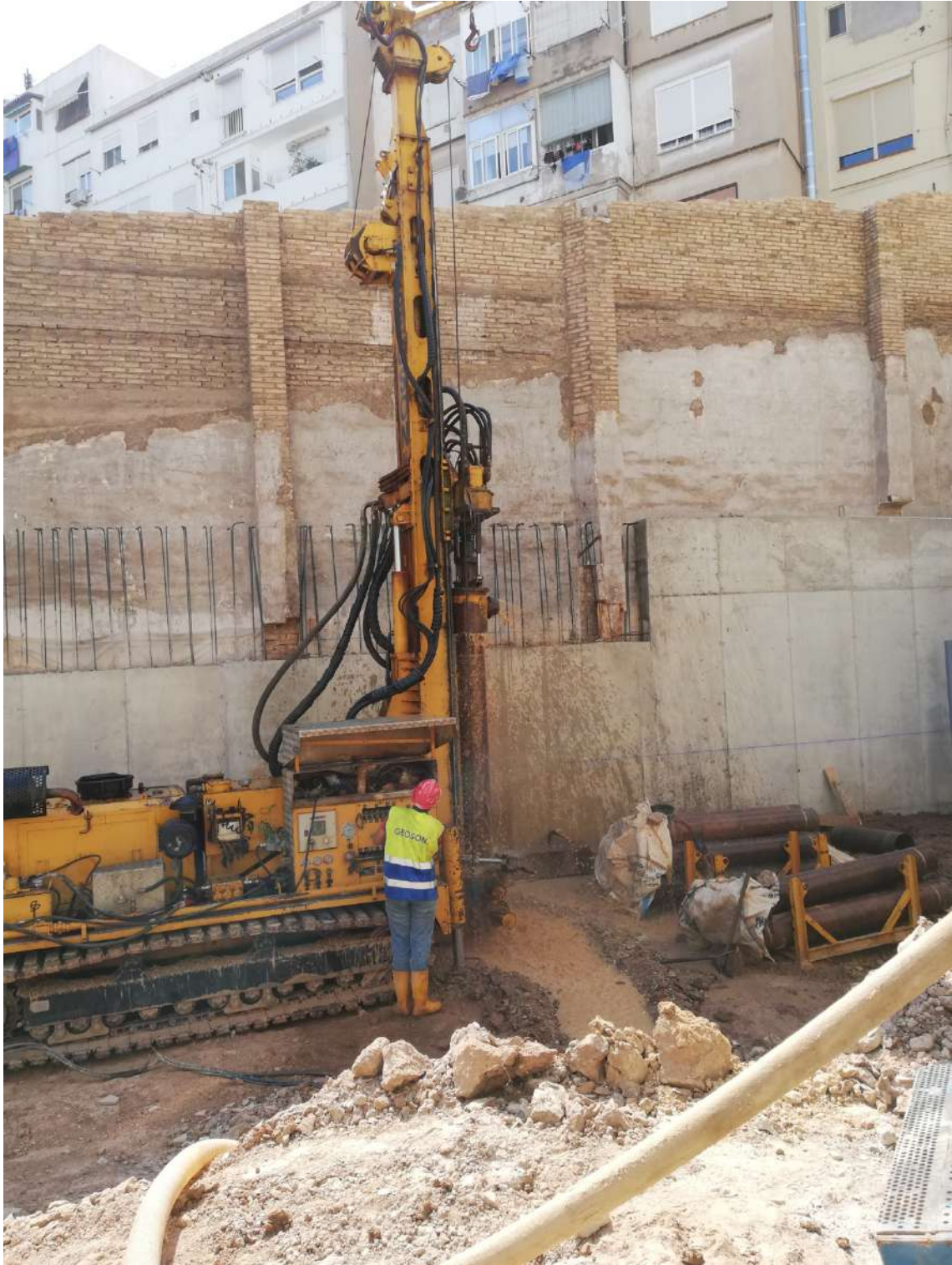
Ilustración 87. Ejecución de perforación de pozo de extracción de geotermia.
