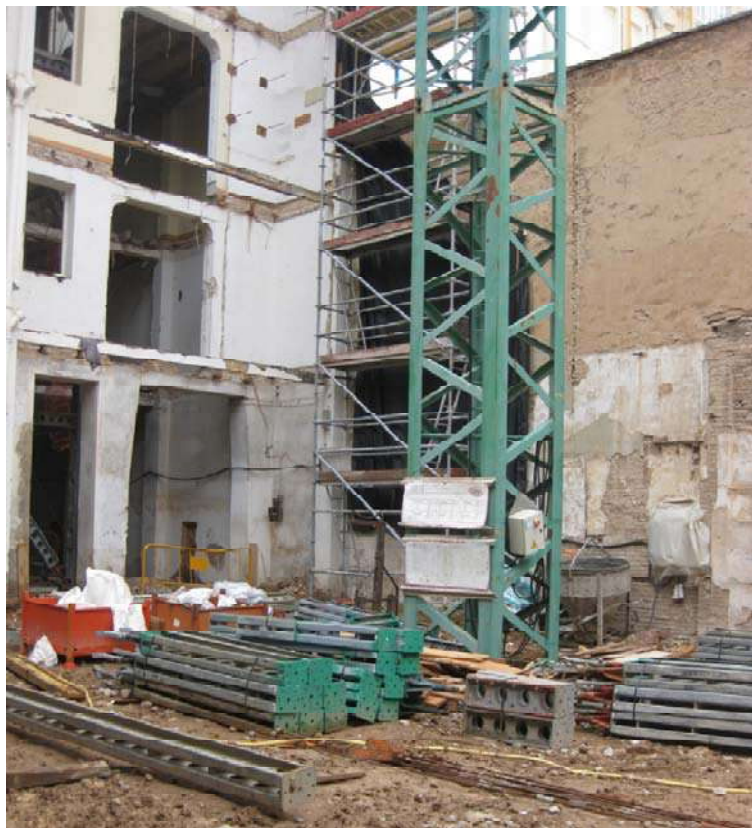
Ilustración 4. Acopio de material del estabilizador de fachada.
