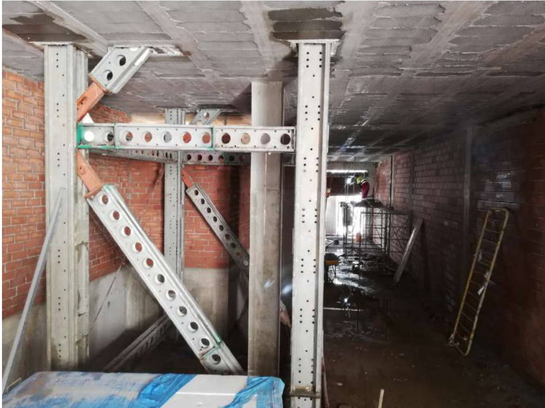
Ilustración 166. Ejecución de los trabajos de tabiquería interior en planta baja.
