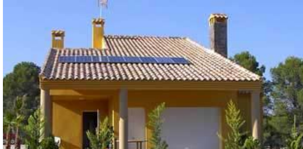
Figura 4.-Panel fotovoltaico sobrepuesto.
