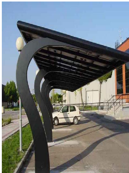
Figura 6.- Módulo fotovoltaico integrado como parasol.
