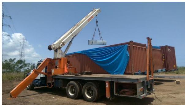
Figura 2.26. Descarga de material en contenedor Open-Top Foto tomada in situ, descarga de estructura solar
