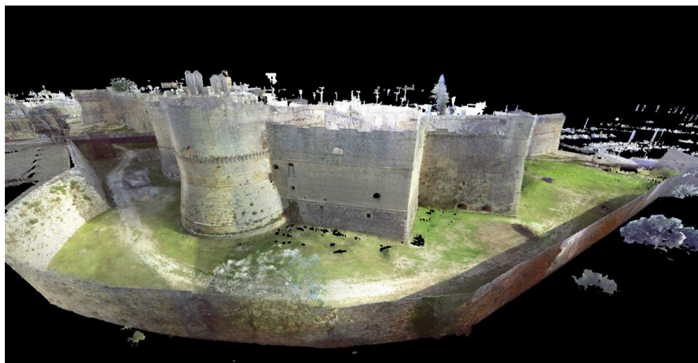
Fig. 4. Rilievo laser scanner 3D. Vista assometrica del fossato e del fronte bastionato del castello aragonese. Il modello tridimensionale generato dalla nuvola di punti globale rappresenta lo stato di fatto del monumento con tutte le peculiarità architettoniche e costruttive (Mitello & Muscatello, 2018).
