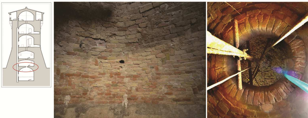
Fig. 6. Il “mastio” della “fortezza nuova”. La cupola emisferica della cisterna (piano interrato) con evidenziato il “cervello aperto” di forma circolare (Archivio Taddei, 2016).
