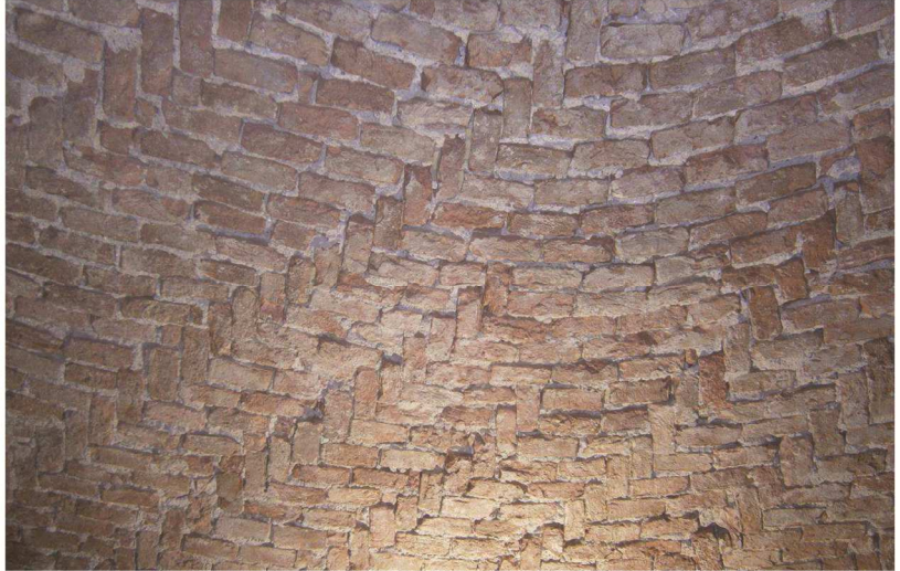
Fig. 7. Il “mastio” della “fortezza nuova”. Particolare della cupola emisferica a piano primo con la realizzazione dell’elicoide in mattoni per coltello con il modulo di 43 cm (braccio senese) (Archivio Taddei, 2016).
