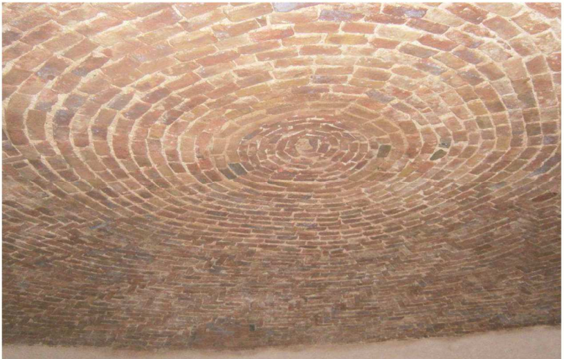
Fig. 8. Il “mastio” della “fortezza nuova”. Particolare della cupola emisferica a piano primo a forma ribassata con il “cervello” (oggi tamponato) facilmente leggibile nell’apparato murario (Archivio Taddei, 2016).
