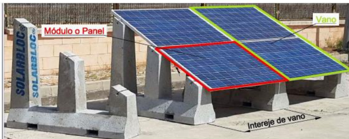
- Montaje de módulos fotovoltaicos.
