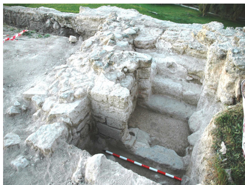
Fig. 3. Escalera que da acceso al paso de ronda del muro oeste (Autores, 2019).
