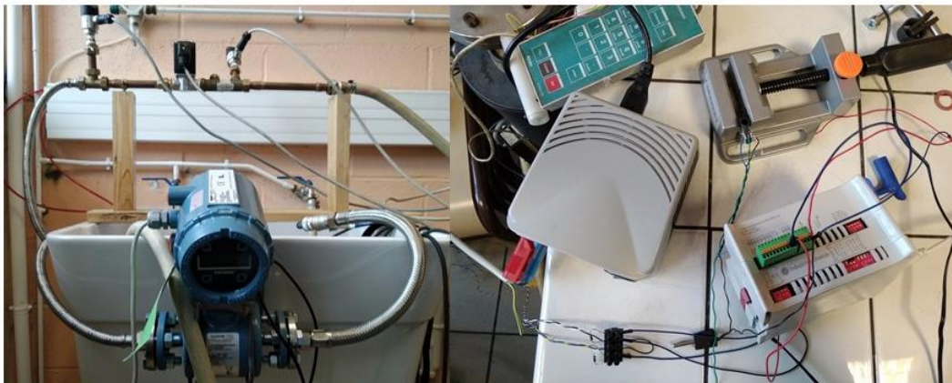
Figure 88. Installation de l'électrovanne
