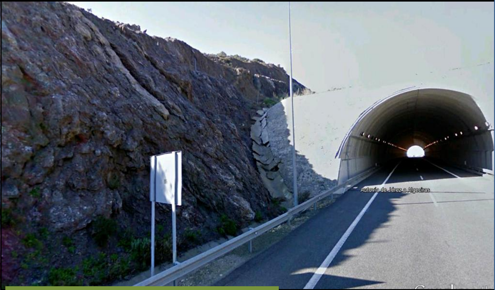
Destrozos en la boquilla del falso túnel en arcillas y yesos del Keuper, Triásico. S del Cerro La Higuera. NW Hoja de Alcalá de Los Gazules.
