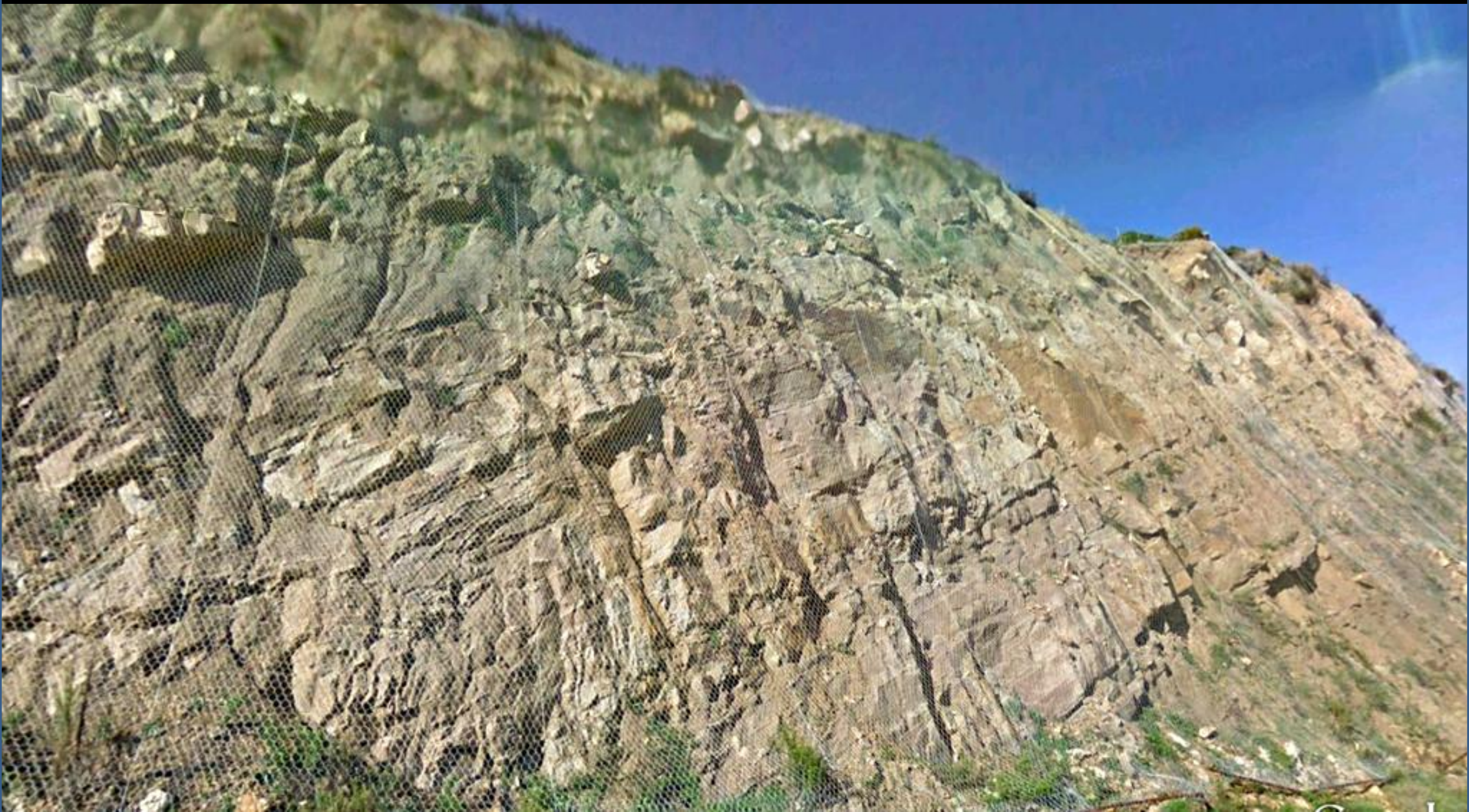
Mallazo en el talud de la Autopista del Mediterráneo, sobre serie areniscosa del Terciario. W de Punta Chullera. NE Hoja de San Roque.
