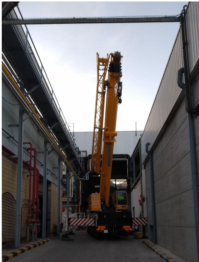
Ilustración 45: Grúa en ubicación de descarga
