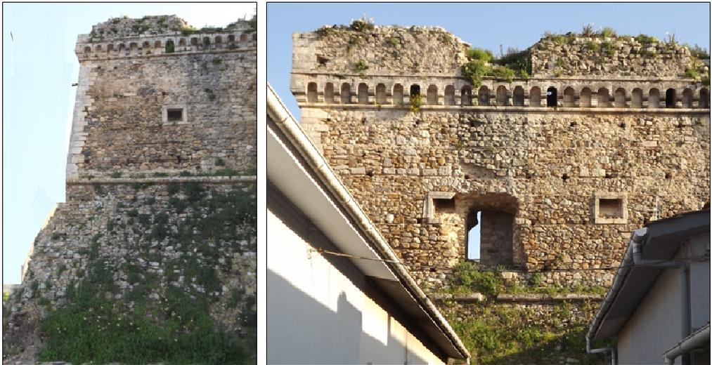
Fig. 6. Il degrado delle murature.
