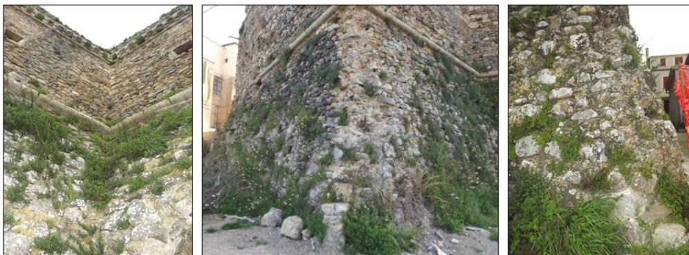
Fig. 5. Il degrado biologico delle superfici delle murature.
