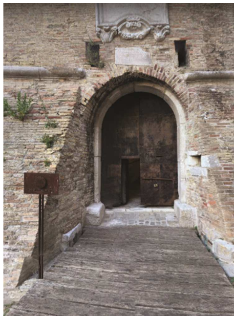
Fig. 9. Ingresso alla Cittadella-Fortezza (S. Rinaldi, 2019).
