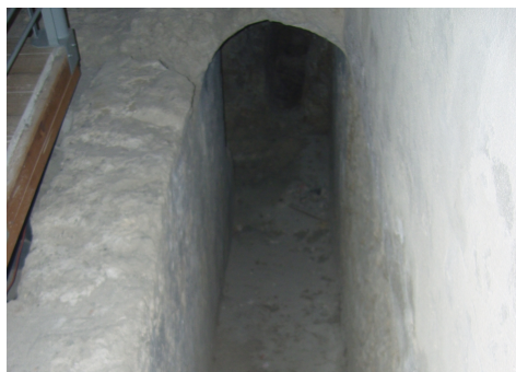
Fig. 10. Passaggio voltato al servizio del bastione di Santa Croce riconducibile all'opera dei fratelli Paleari.
