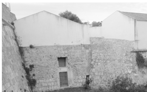
Fig. 9. Cannoniera nel fianco del bastione di Santa Croce posta in opera dai Paleari nel periodo 1573-1578.
