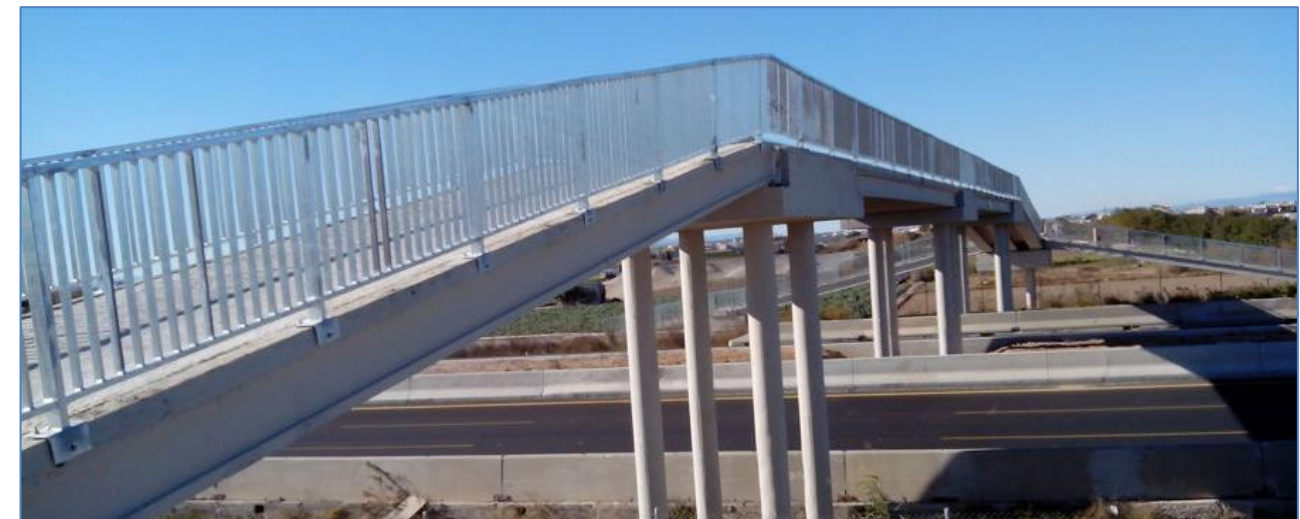
Fig. 28 Pasarela peatonal en V-21 de vigas de hormigón prefabricado
