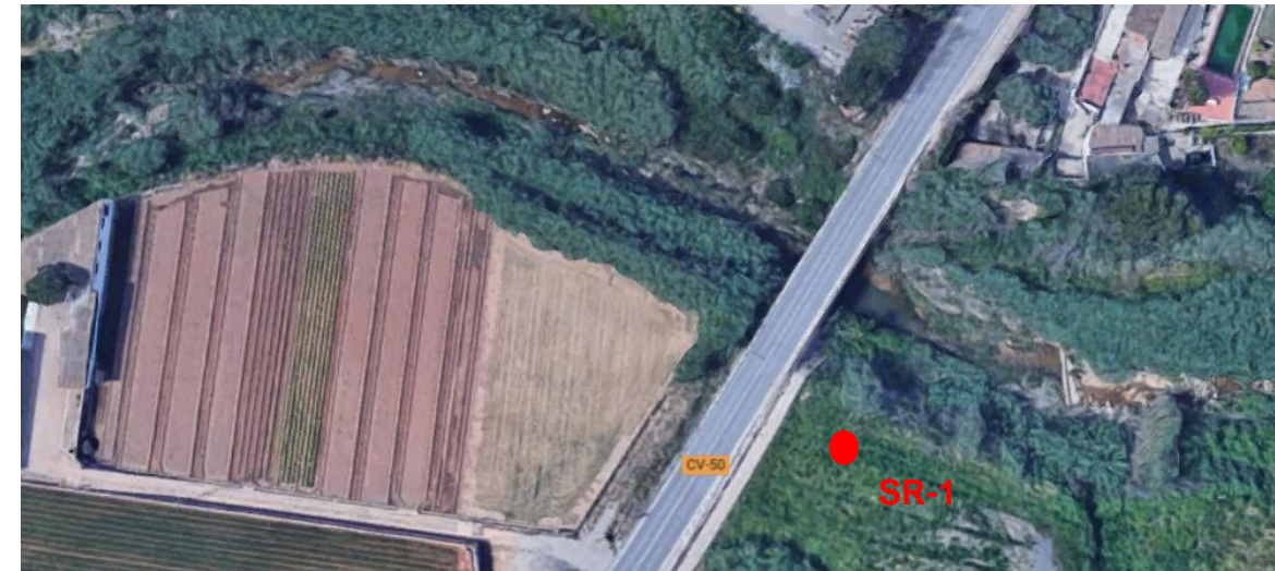
Fig. 5. Emplazamiento pasarela y sondeo rotativo
