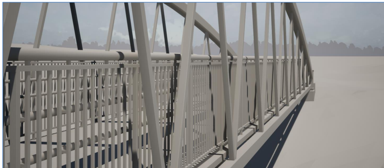
Fig. 23 Vista detalle de diagonales
