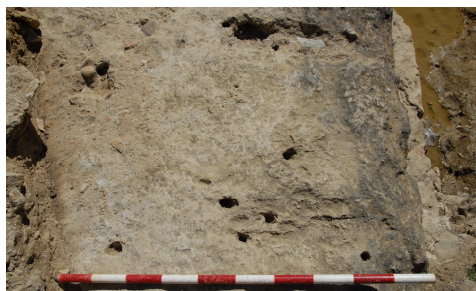
Fig. 6. Huella de los clavos en el negativo muy erosionado de las medias agujas (M101). Alrededor de éstas, negativos de las cuerdas que ataban los costales.
