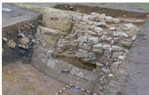
Fig. 2. Superposición de las obras de mampostería a las encofradas en el sector 1 (sondeos 1 y 2). Véase cómo toda la barbacana encofrada está forrada por la hoja de mampostería (M105) que sirve a su vez de horma para el relleno de calicanto (M206), que está sobre la tapia (M210).
