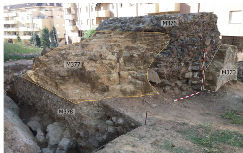
Fig. 8. Vista desde el noroeste de la torre T4. Antigua torre realizada con tapiales (M377 y M378) embutida dentro de la obra de calicanto (M376), a su vez realizada contra la hoja de mampostería (M373).
