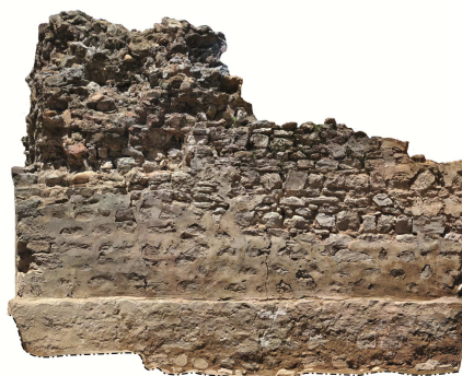
Fig. 7. Ortofotografía del lado este de la torre T4 que se erigió con calicanto entre hojas de mampostería.
