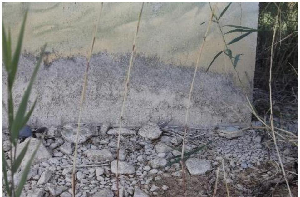
Figura 20. Detalle de daños producidos por el agua en la obra *Justicia para Honduras*.
