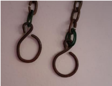
Figura 41. Topes originales del extremo de las cadenas interiores
