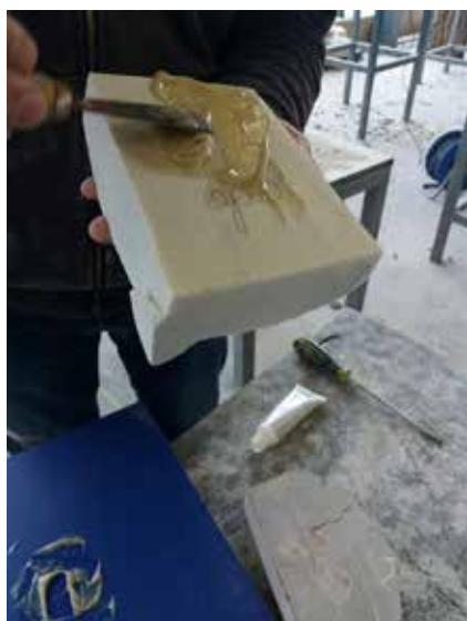
Figura 16. Encolado con resina de poliéster tixotrópica. 1.
