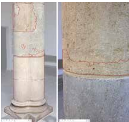
Figura 2. Detalles de piedra calcarenita bioclástica y piedra artificial porosa restauradora en las faltas de soporte.
