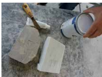
Figura 15. Presentación de los fragmentos sin encolar. Bloque superior.
