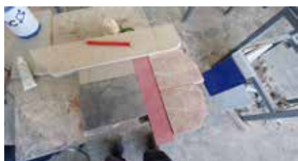
Figura 14. Presentación de los fragmentos sin encolar. Bloque inferior.
