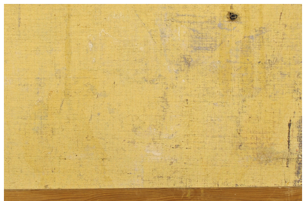
Figuras 72. Manchas de humedad del lado inferior .
