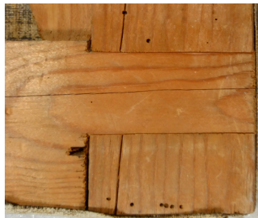
Figuras 75. Grieta del ensamble inferior derecho.
