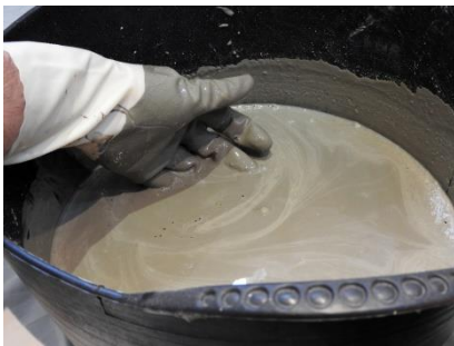
Fig. 27. Argamasa conseguida tras mezclar el cemento en polvo con el agua. Fotografía propia.
