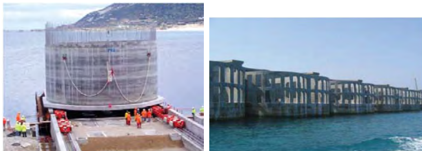
Figura 2.22. Vistas del dique exterior del Puerto de Tánger (Marruecos, 1997)
