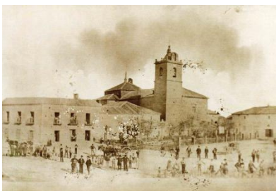
Fig. 6. Plaza de España (1874), construida alrededor del pozo Tomilloso.
