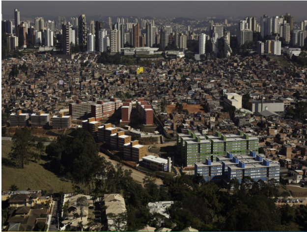
Figura 14. Conjunto de viviendas. Urbanización de la favela Paraisópolis
