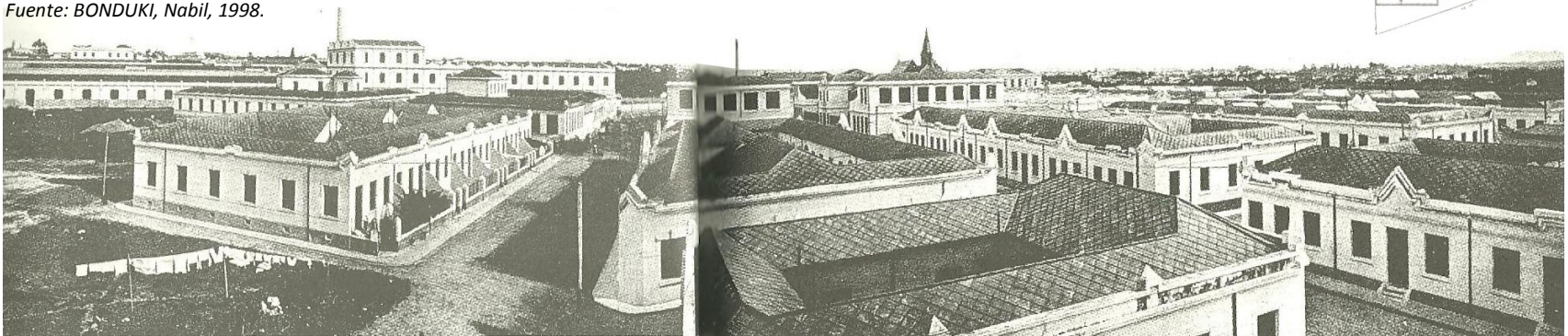
Figura 5. Villa operaria Maria Zélia, en San Pablo, 1919. Precursora de los conjuntos de viviendas. Fuente: BONDUKI, Nabil, 1998.
