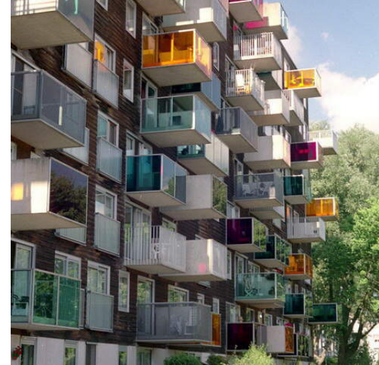
Figura 31. Holanda: La solución de balcones en voladizo es muy frecuente, buscando un mínimo espacio exterior para aprovechar la escasa radiación solar.
