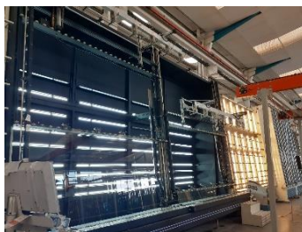
Figura 11. Espai d'acoblament a la línia B. (Font: Elaboració pròpia)
