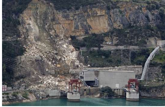
Figura 3: Desprendimiento de la ladera norte de la Muela de Cortes de Pallás
