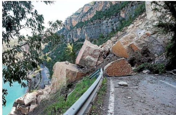
Figura 4: CV-428 cortada por el desprendimiento
