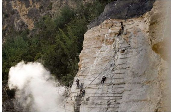
Figura 5: Trabajos elaborados en la ladera
