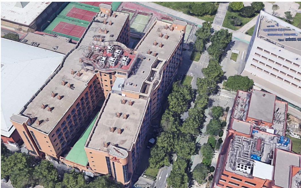
Figura 6.-Entorno del edificio
