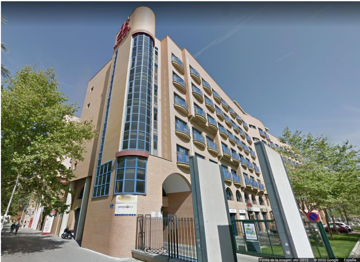
Figura 2.-Vista del edificio
