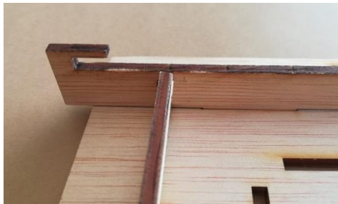
Figura 96. Variante 1. Encaje de los topes
