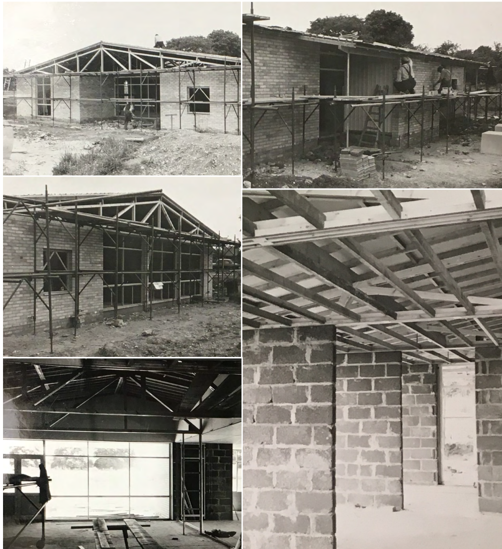
Proceso de ejecución de Finnere Primary School
