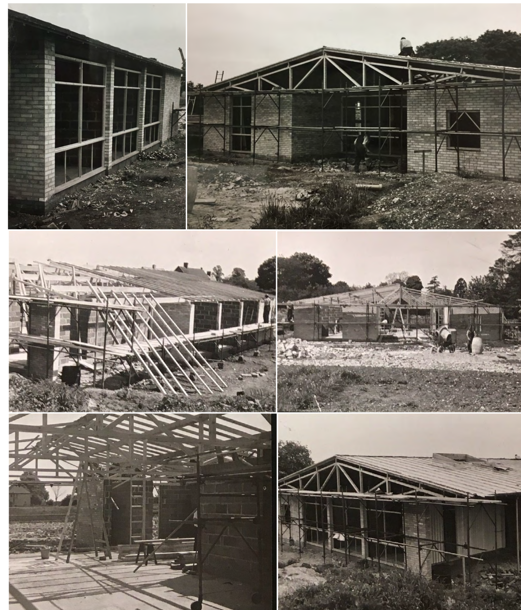
Proceso de ejecución de Finmere Primary School
