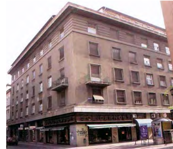
Imagen 486. Edificio de la Facultad de Arquitectura de la Universidad de Zagreb. En ella E. Schön ha asimilado totalmente el lenguaje de lo moderno, pero sin asumir apuestas vanguardistas ni apostar más allá de la clara y segura ortodoxia.
