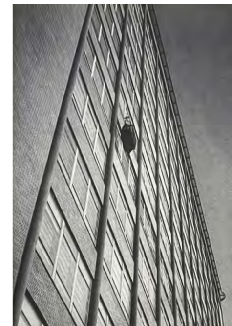
Imagen 124. Plementería exterior de ladrillo y vidrio.
