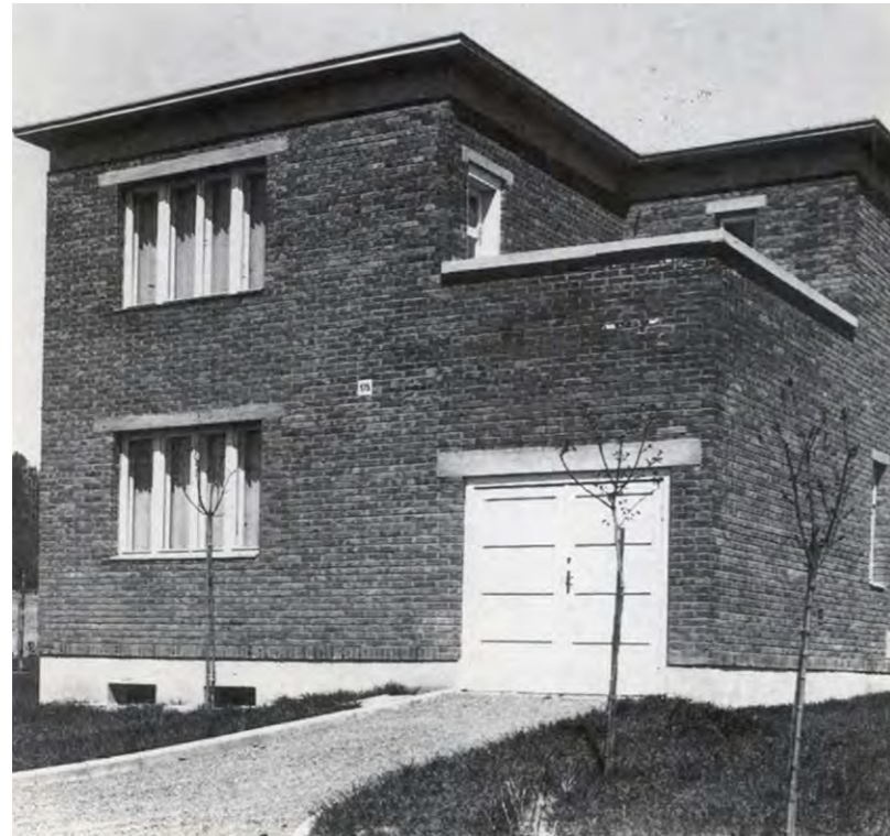
Imagen 498. Vivienda para directivos de la empresa en doble planta de V. Karfik (1936).
