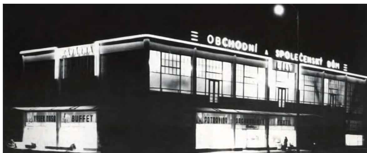
Imagen 155. Vista nocturna del Economato en el momento de su culminada construcción.
