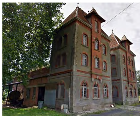
Imagen 278. Fachada frontal del edificio principal (fuente: Google Maps).
