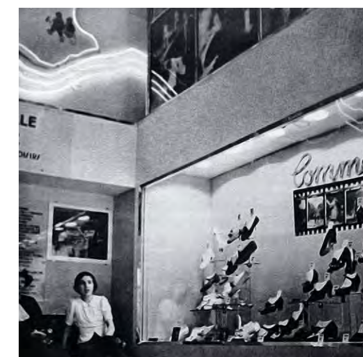
Imagen 415. Cinco vistas captadas del interior del Pabellón Bat'a construido.
