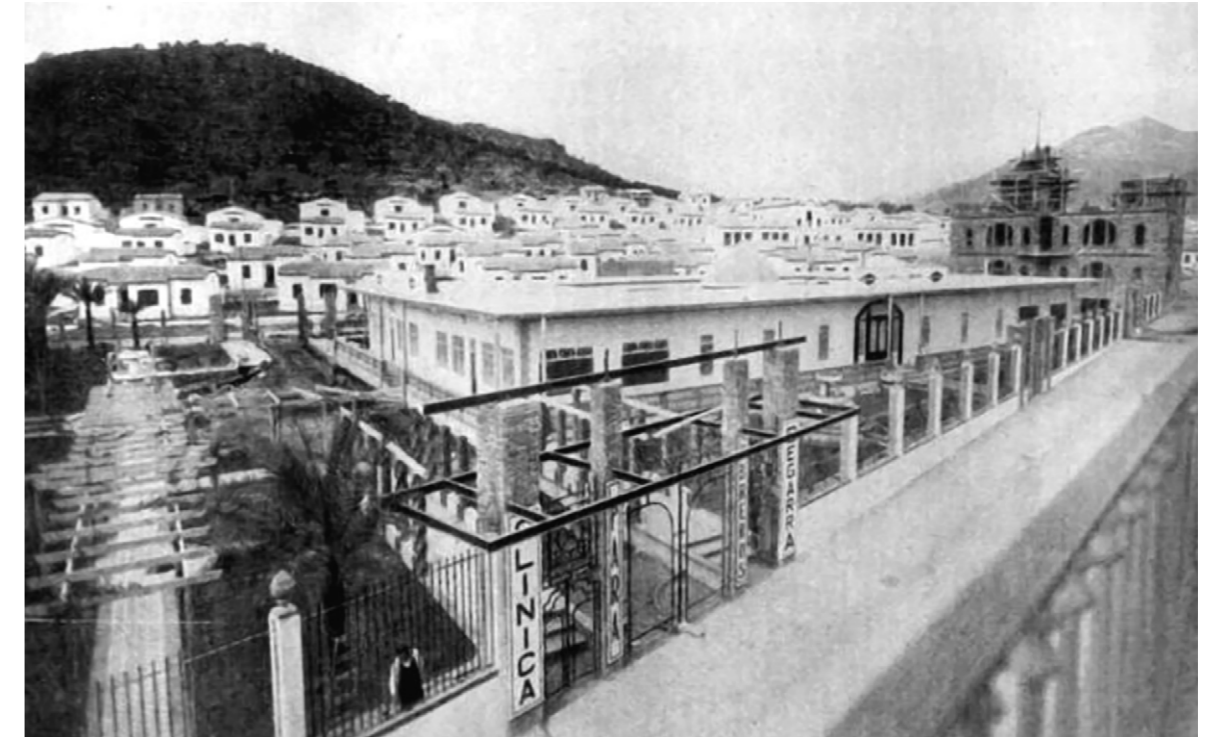
Imagen 2. Aspecto del momento de construcción de los diferentes equipamientos. En primer término: la Clínica, a falta todavía de su característica cubierta en el porche de entrada (se observan los perfiles de acero que la formalizarán); al fondo: el Edificio del Reloj todavía con andamios y la primera fase de la colonia Segarra.
