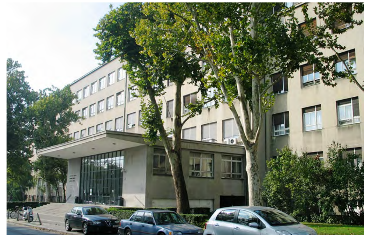
Imagen 488. Edificio residencial donde se aprecia la evolución su lenguaje, pasando por los primeros racionalismos (n.º 6 c. Varšavska de Zagreb, 1928).
