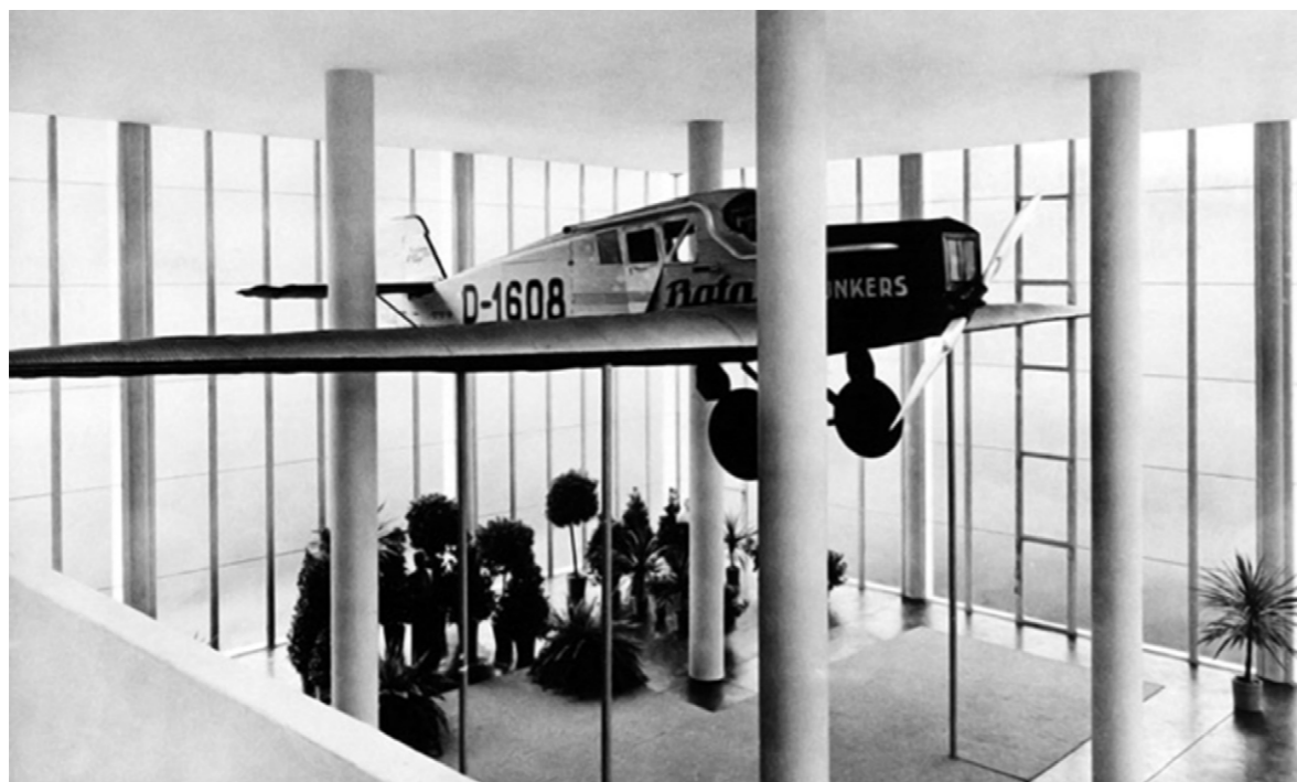
Imagen 162. Vista del interior desde la plataforma intermedia. Queda manifiesta la condición de la transparencia pretendida con el tratamiento del vidrio y la dominante pregnancia que ejerce el prototipo del avión.
