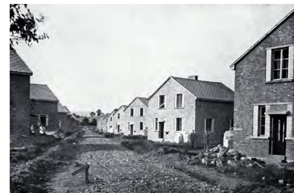
Imagen 75. Aspecto en el momento de su construcción de la unidad residencial Zálesná.
