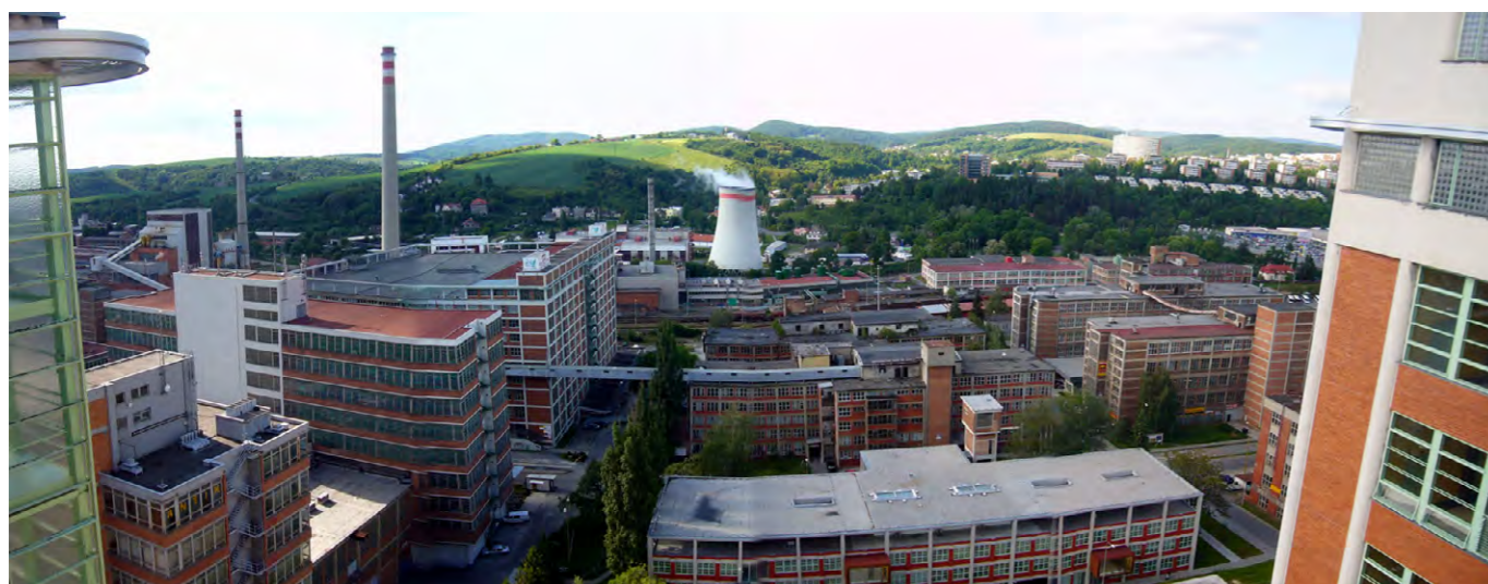
Imagen 59. Segunda vista global de este conjunto, hacia el norte: almacén general (drcha, en segundo plano), central térmica de producción eléctrica que abastece la factoría (fondo). La vía arbolada, orientada a la chimenea de la central, marca aproximadamente la separación de etapas constructivas. El área inicial de viviendas, de Gahura, no ha sido sustituida (drcha.), (fotografía del autor desde edificio administrativo N 21, 2007).
