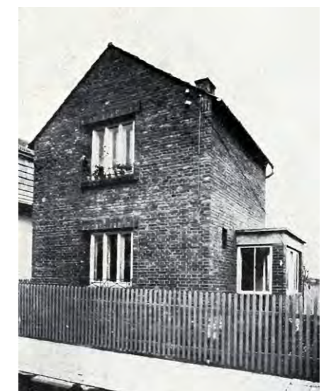
Imagen 81. Vista exterior de este tercer ejemplo de vivienda.
