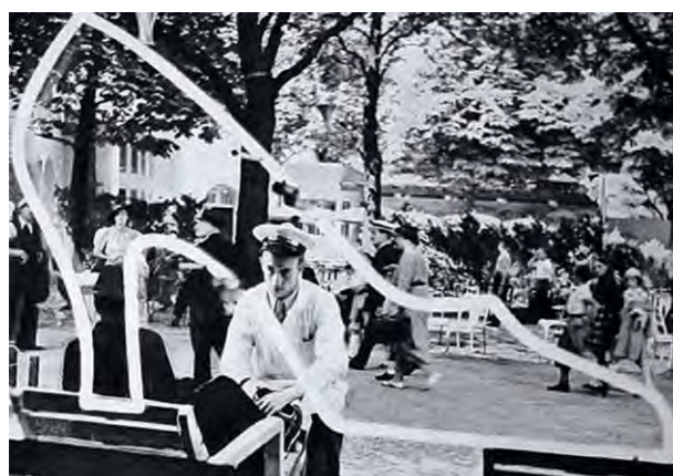
Imagen 414. Fotografía conservada del Pabellón de M. Boyer para la empresa Bat'a. Nótese que en el exterior se publicita tan solo la factoría francesa. Los nuevos tiempos caminan por las tendencias nacionalistas y en el ejemplo construido se opta, claramente, por reflejar el talante galo de la apuesta. Idéntico sesgo se ha apreciado en el proyecto de Le Corbusier; sin embargo, aquí puede leerse, con evidencia, que el pabellón está destinado a las «oficinas de zapatos en Hellocourt-Mosela». Por lo demás, continúa la apuesta formal de la empresa por el racionalismo más vanguardista. Sin ninguna pretensión especial. Los grandes paños vidriados dominan la fachada, por más que deban ser sistemáticamente cegados con cortinas en la completa integridad de su interior. Obsérvese como el departamento de pedicura se convierte en un aliciente exterior para el visitante (fuente: Bat'a Ze Zlín do Světa , 2005, p. 32).
