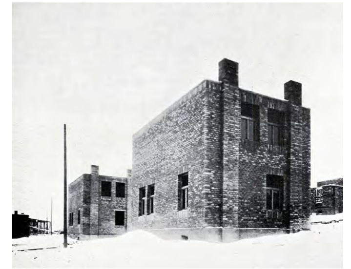
Imagen 79. Aspecto en el momento de su construcción de estas viviendas de los administradores.
