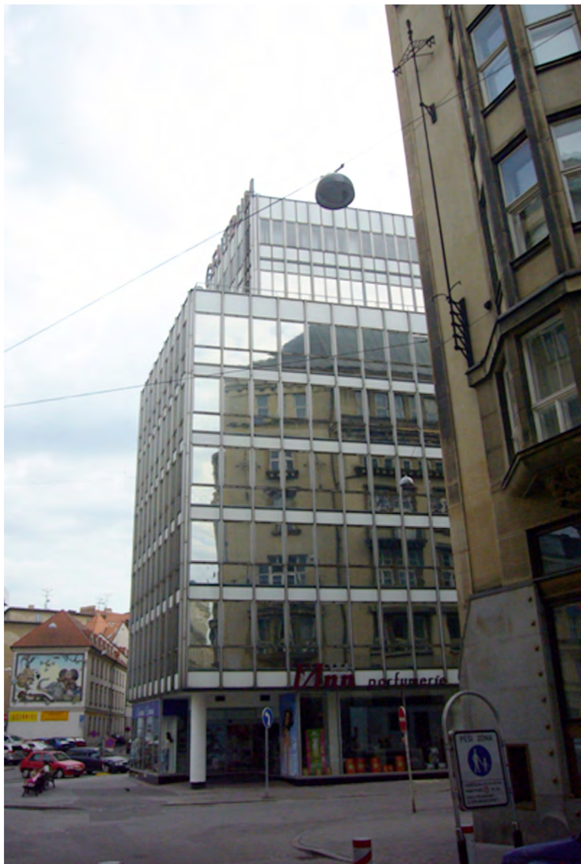
Imagen 105. Edificio Bat'a Brno. En su encuentro con la cota cero, este entrega parte de su planta a los recorridos peatonales.
