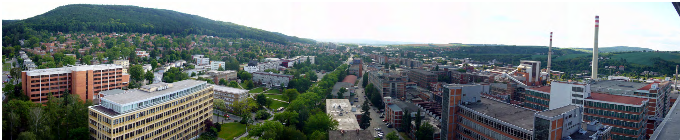
Imagen 58. Vista panorámica del complejo de Zlín, hacia el este: colonia residencial Letná (izqda.) y vía principal de acceso desde Otrokovice (Bař'ov) (horizonte del fondo); edificios industriales, en segundo término, ya tardíos, construidos durante la ocupación alemana o en el período soviético (fotografía del autor desde la azotea del edificio administrativo N 21, 2007).
