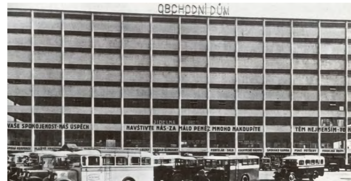
Imagen 152. El Economato recién terminado. Obsérvese el aspecto, sumamente abstracto, logrado a través de la alternancia de bandas altas de iluminación con la retícula estructural.
