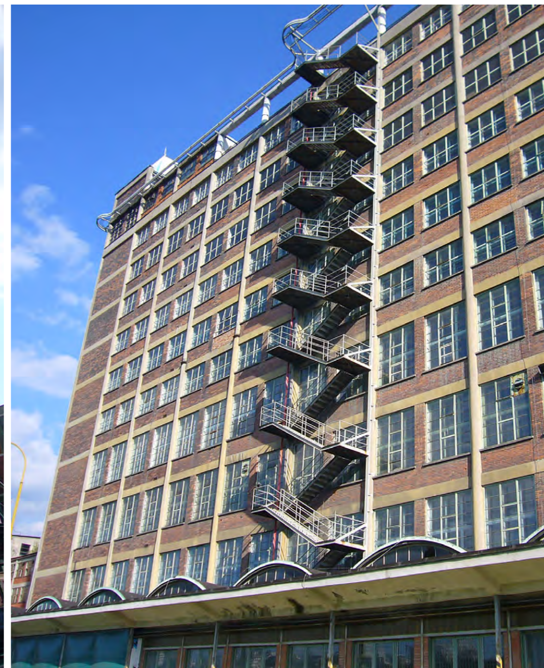
Imagen 63. Edificio N° 34. Es inevitable que algunos elementos presenten piezas añadidas, como en el caso de este lo son las marquesinas de la planta baja y el mecanismo de limpieza de los vidrios, aunque con todo, es remarkable su afortunada integración (fotografía del autor, 2007).
