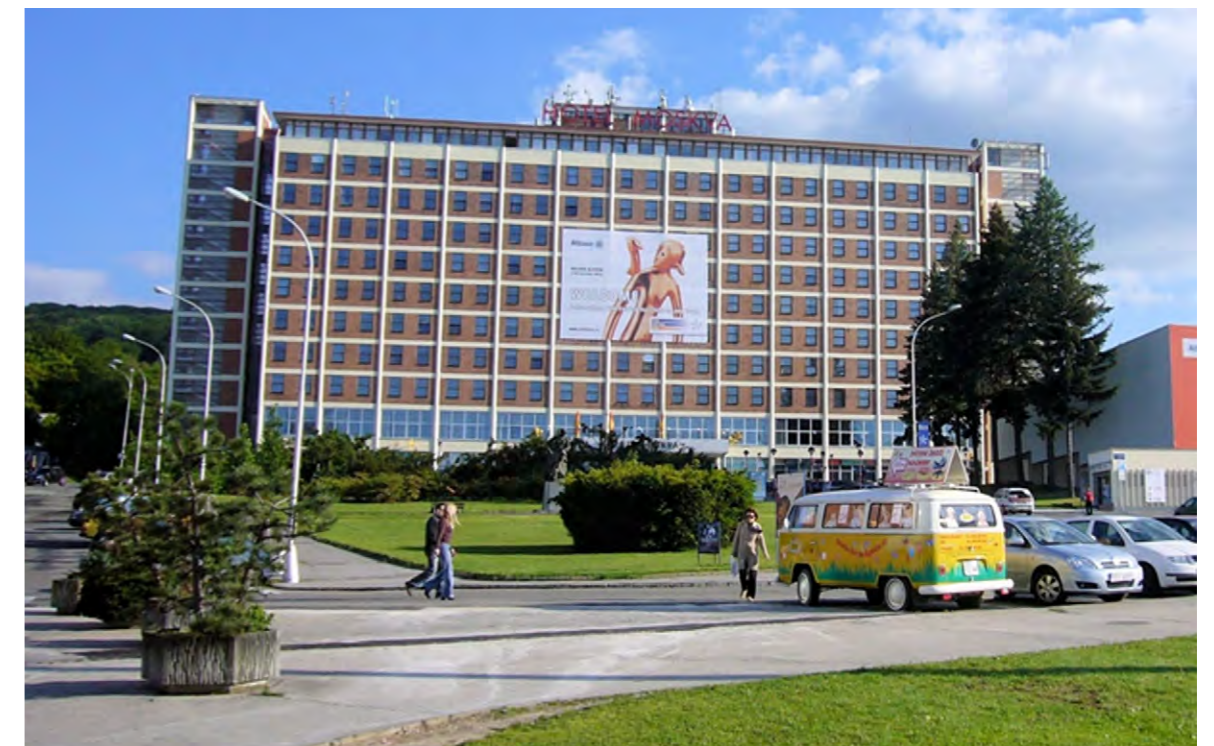
Imagen 148. Estado de la residencia central comunitaria u Hotel. El edificio ha sufrido el macizado de la cubierta con un paño de vidrio y la aparición de dos cuerpos en los extremos que albergan sendas escaleras de evacuación. Si bien la inserción no es desafortunada, sí varían de manera ostensible las proporciones del conjunto (fotografía del autor, 2007).
