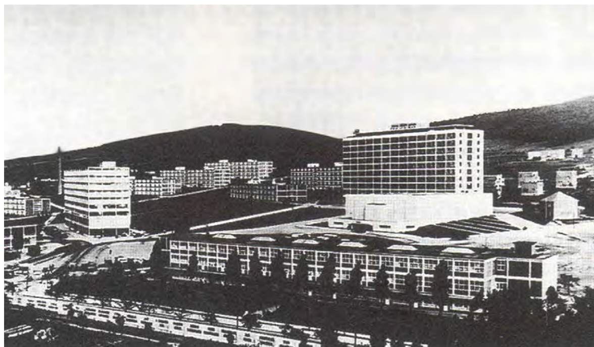
Imagen 142. El conjunto del Hotel recién construido. Se adivinan también los Edificios comerciales y los Institutos de investigación.
