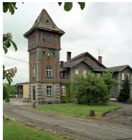
Imagen 276. Edificio de los encargados. La torre del conjunto es, en realidad, un depósito de agua (fotografía del autor, 2007).
