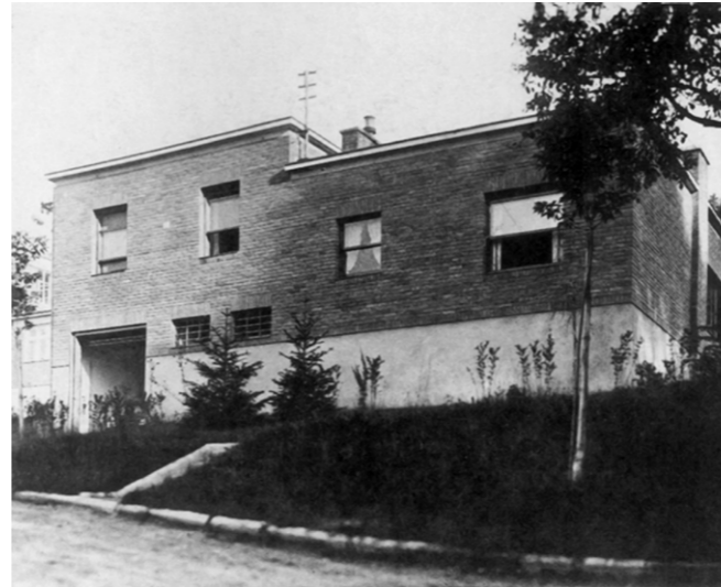
Imagen 241. Alzado trasero del prototipo de la vivienda proyectada por V. Karfík. Se observa la materialización volumétrica de las semiplantas y el aprovechamiento del desnivel topográfico.
