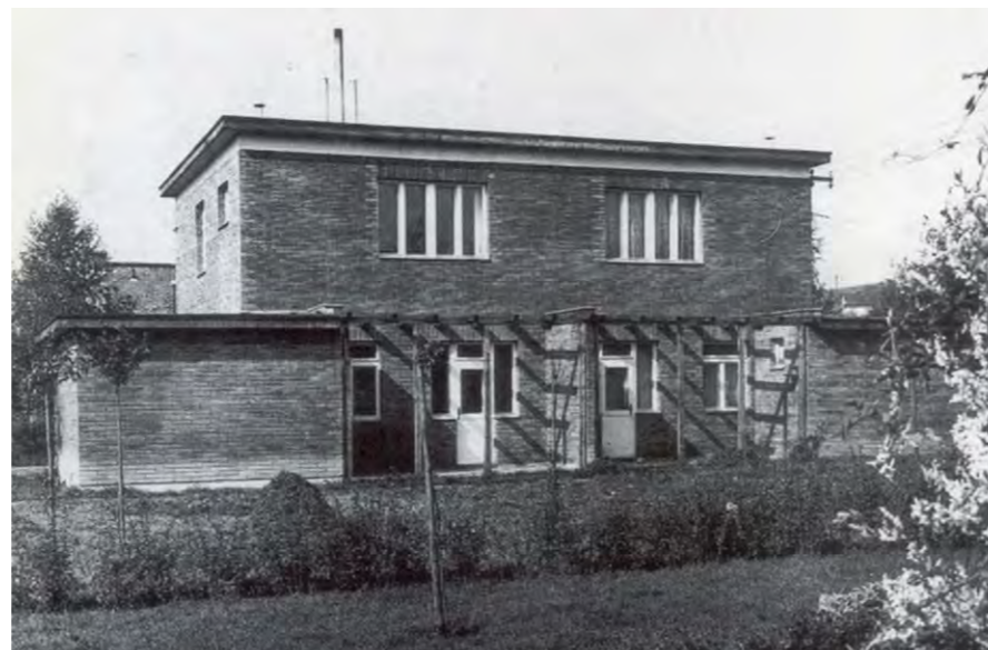
Imagen 504. Vista desde los porches de las viviendas pareadas de M. Drofa (1939).
