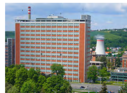
Imagen 127. Visiones exteriores del Edificio 21, después de su rehabilitación.
