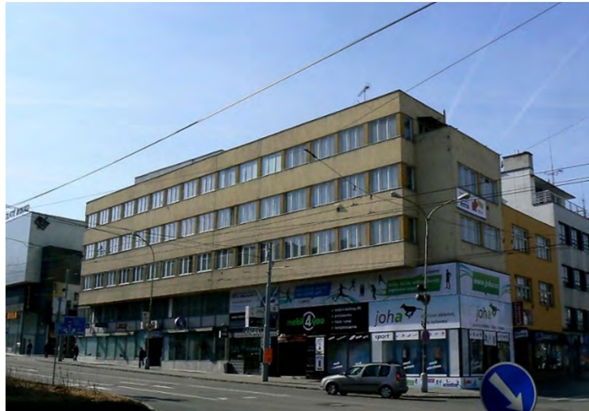
Imagen 462. Edificio residencial Eduard Pelcák de M. Lorenc (Zlín).
