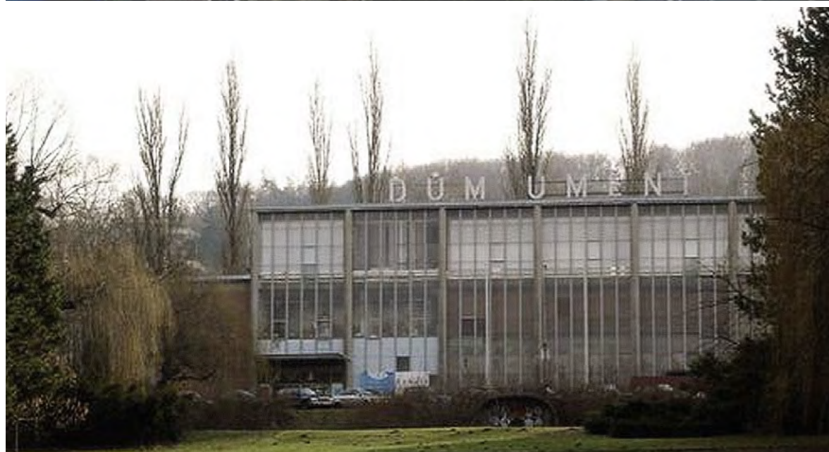
Imagen 165. Dos vistas del edificio donde se perciben varias e intensas modificaciones que han mermado sustancialmente su significado y sus condiciones espaciales: cuerpos de edificación añadidos, entradas abiertas en lugares no previstos, particiones interiores, forjados intermedios, etc. (fotografía del autor, 2007).
