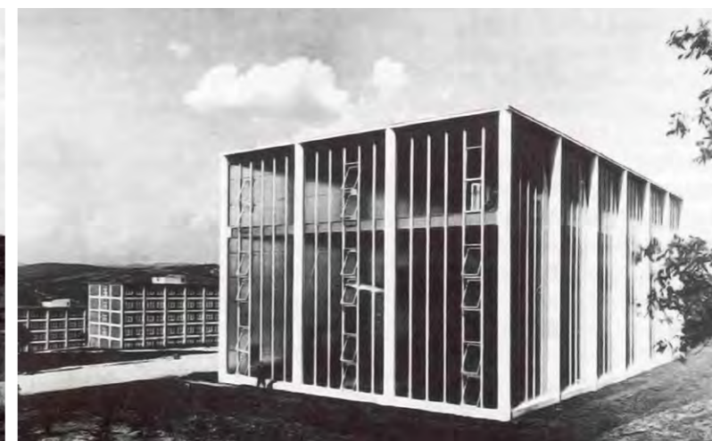
Imagen 160. Dos visiones de la época, desde ángulos diferentes, del edificio del Memorial.
