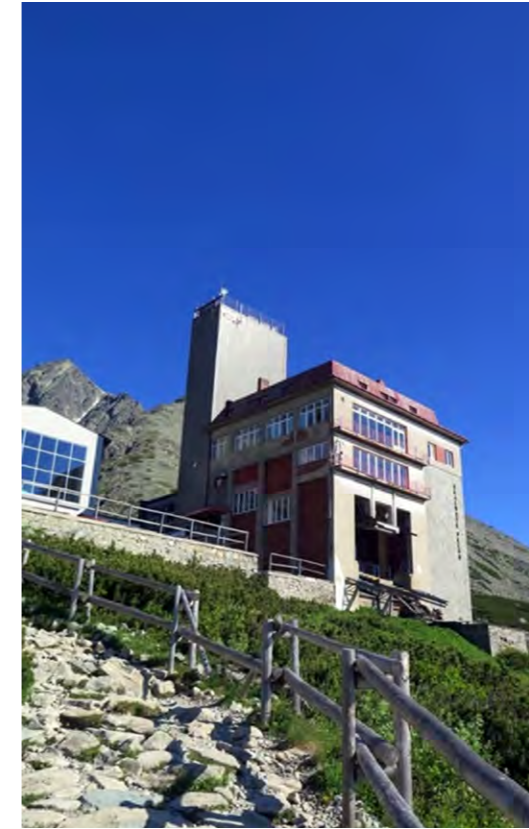
Imagen 491. Edificio de recepción del teleférico de los montes Tatras, obra decididamente racionalista de D. Jurkovič (Tatzaňskej kômnicy, 1935-1937).
