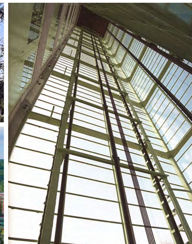
Imagen 128. Interior recinto de ascensor que aloja el despacho desplazable, tras la rehabilitación.
