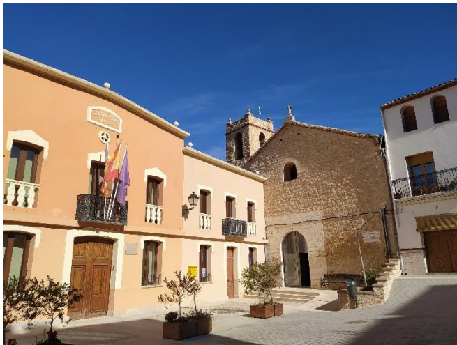
Il·lustració 20: Vistes de l'església construïda sobre l'antic Castell-Palau d'Alcalà de la Jovada.
