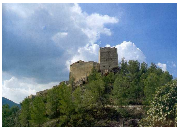
Il·lustració 47: Vistes exteriors del castell de Barxell. Font: Inventari General del Patrimoni Cultural Valencià
