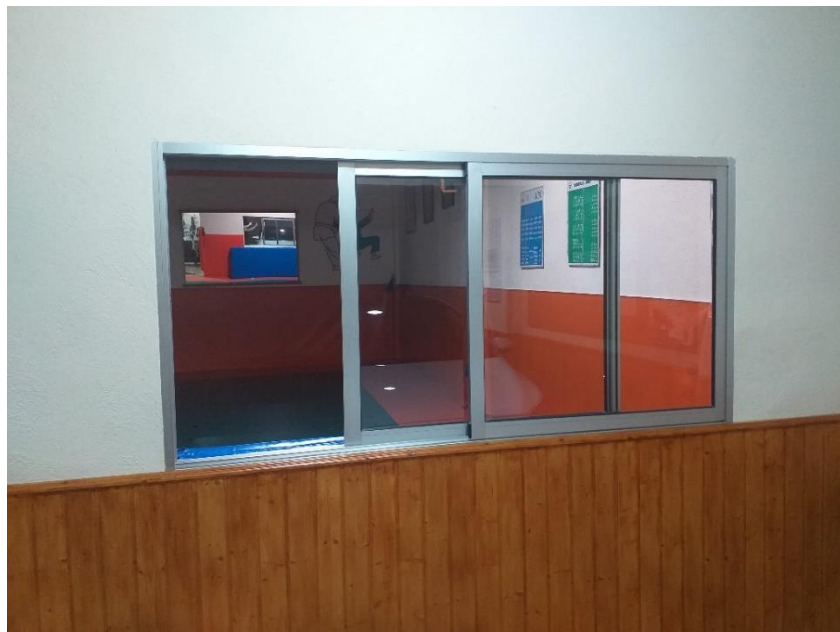
Figura 30 : Ventana corredera de aluminio en sala de espera, 2020.
