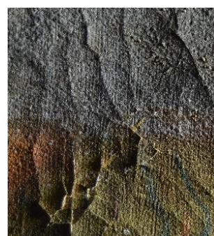
Imagen 38. Detalle de esquina de bastidor con grietas y cuña.
