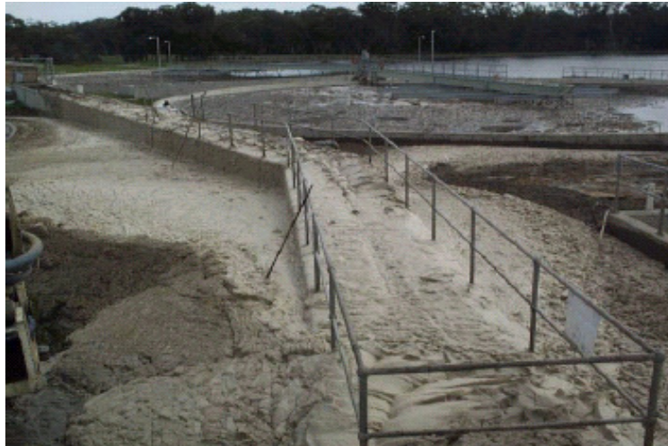
Figura 6: Problema real de espumas en depuradora
