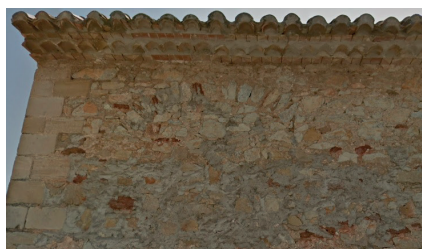
Figura 4. Detall de les restes d'una construcció anterior, paret est de l'ermita de Santa Bàrbara.
