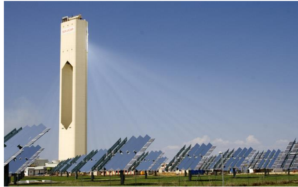
Il·lustració 3: Instal·lació d'energia solar termoelèctrica de torre central.
