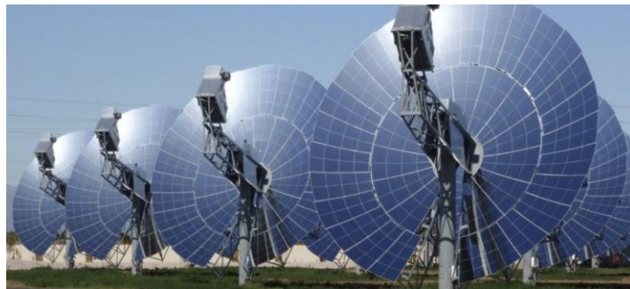
Il·lustració 4: Instal·lació d'energia solar termoelèctrica de discos parabòlics.
